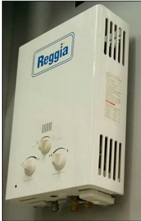
Figura 1.2 Terma a gas marca Reggia (Ref. Tienda Maestro Surquillo)
