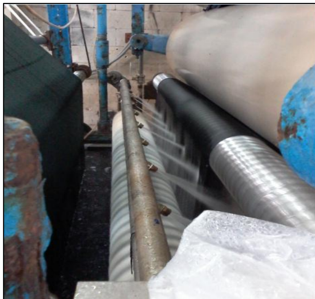
Figura 25. Chorro de agua saliente de toberas
