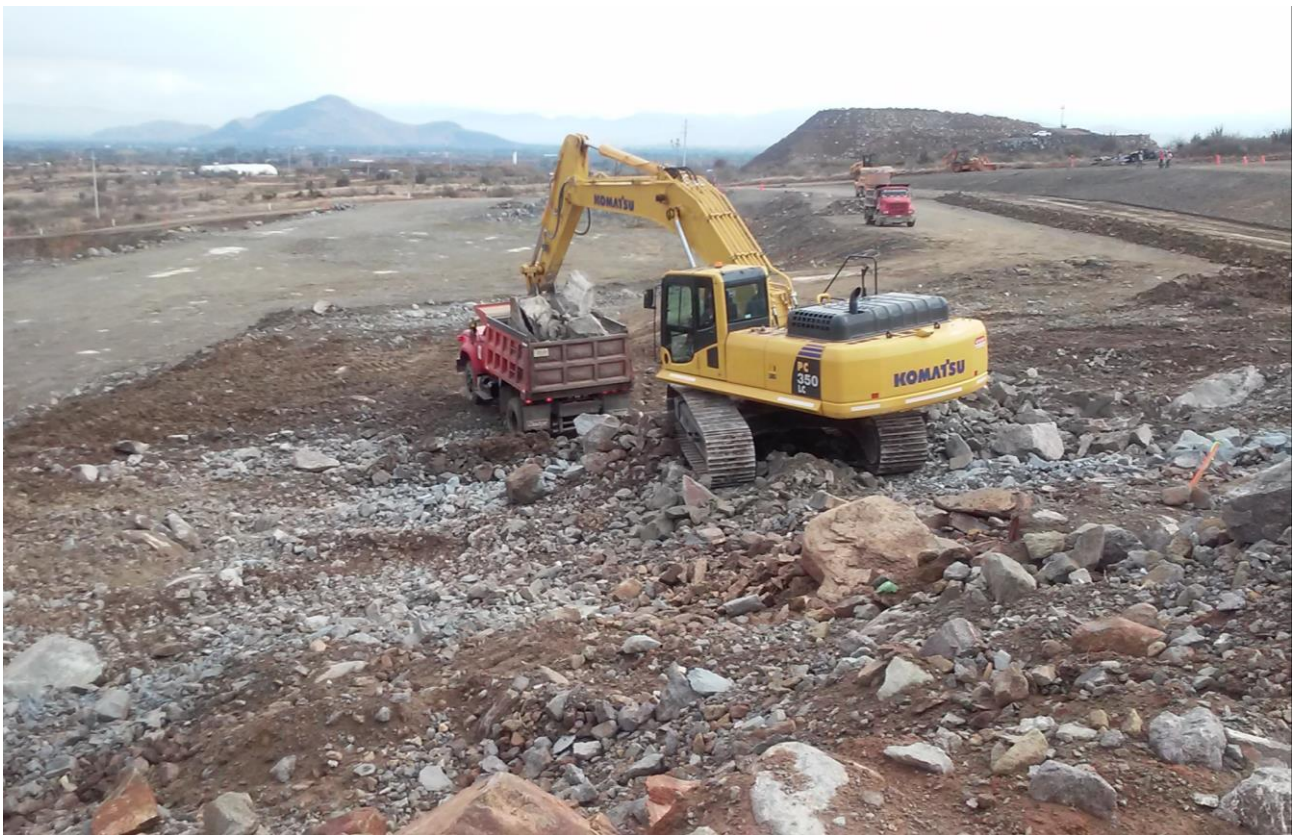
Foto N° 8: Eliminación de material de sobre tamaño.
