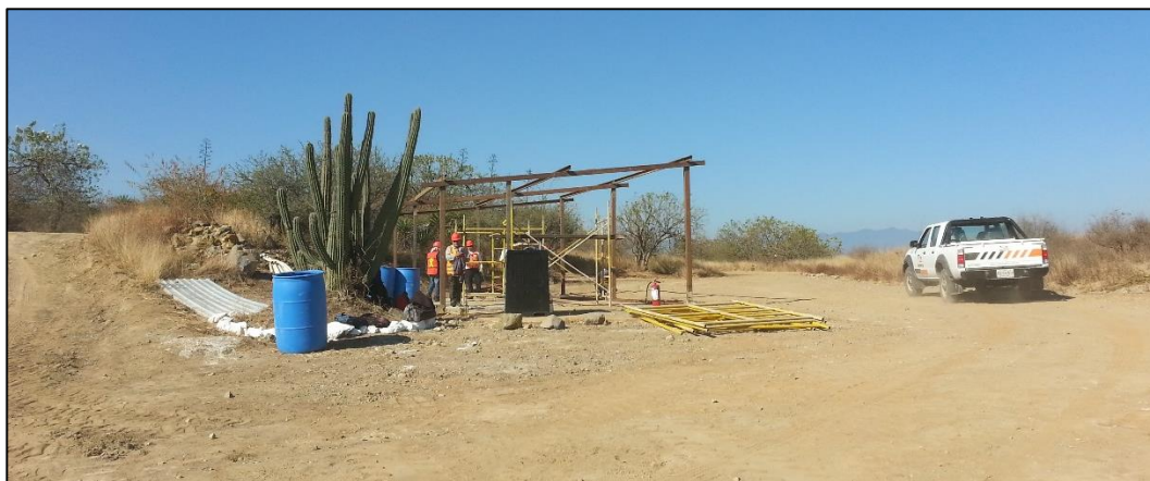
Fotografía 3-2: Habilitación del área de comedor del contratista.
