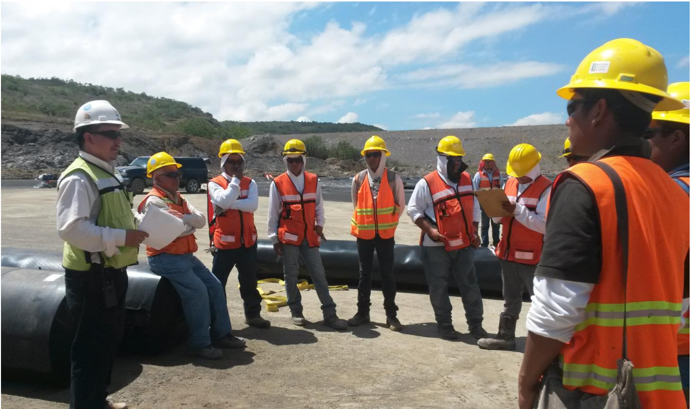
Foto N° 5: Charla de seguridad de 5 minutos antes de iniciar las labores.
