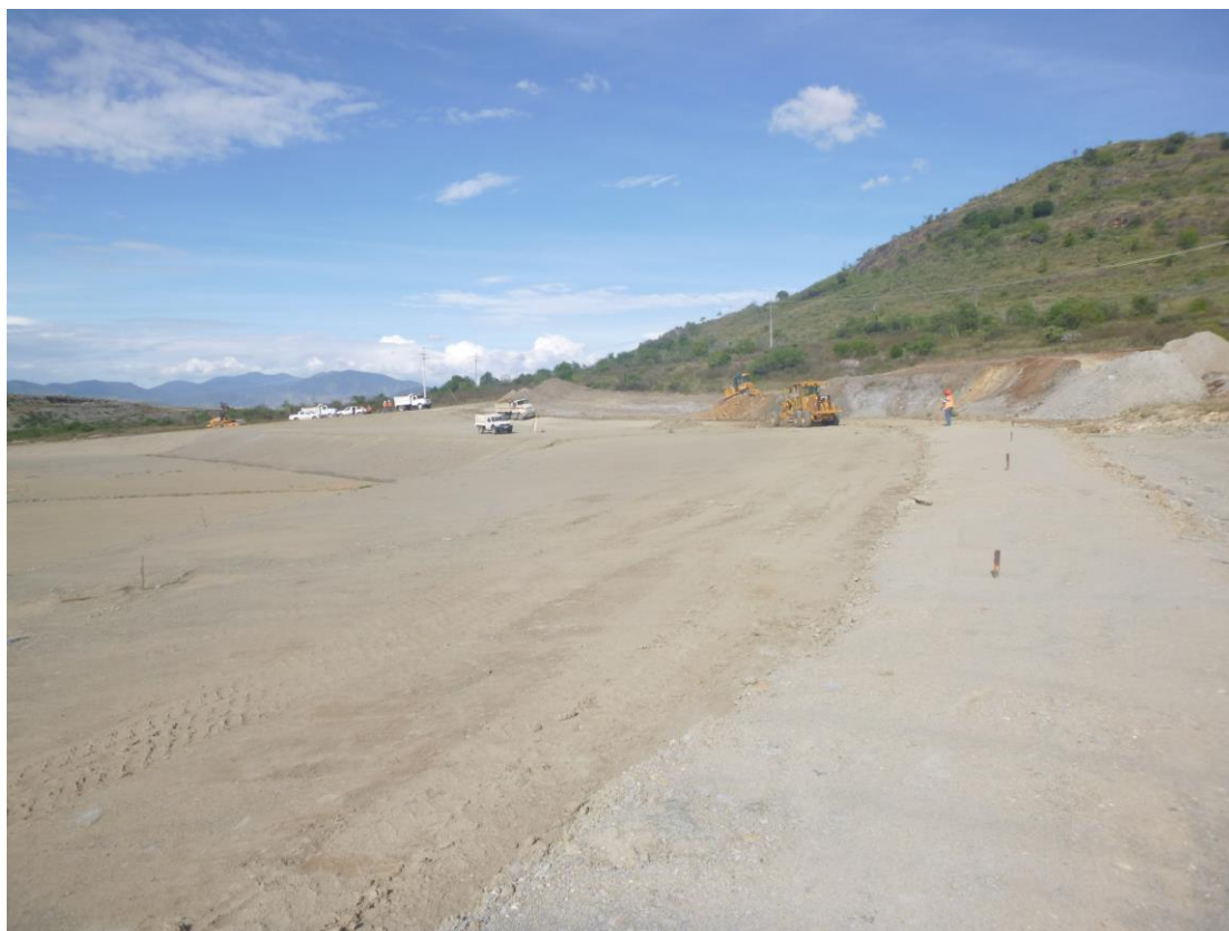
Foto N° 3: Refine, perfilado y compactación del vaso del depósito.
