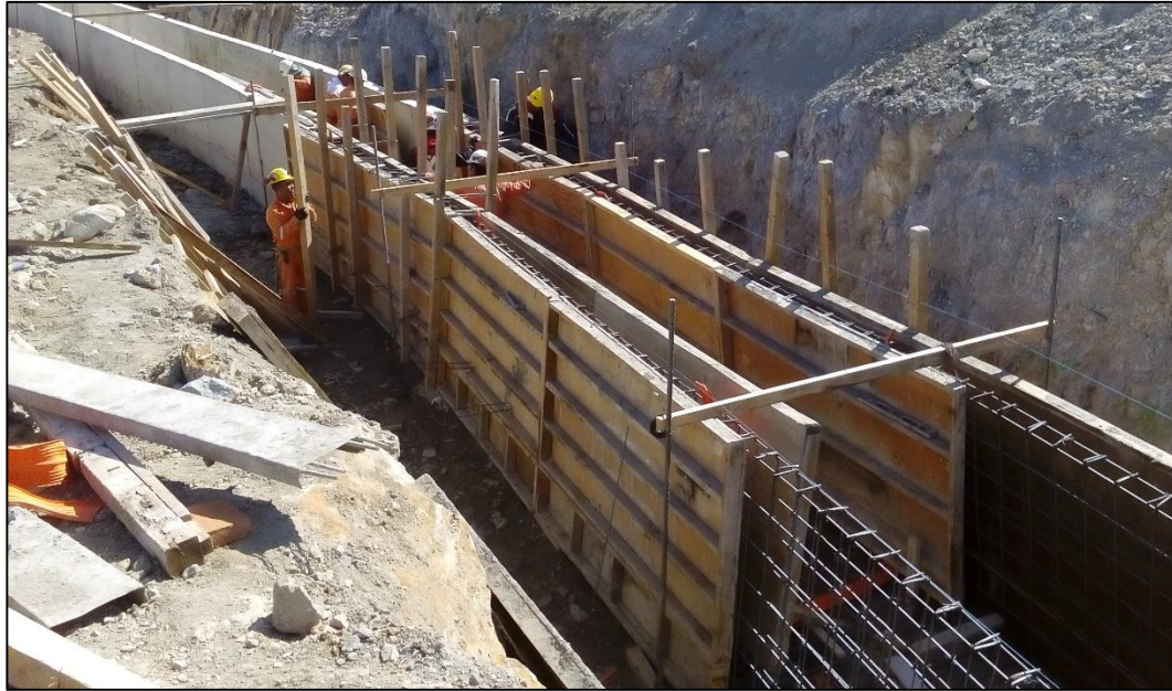
Fotografía 3-9: Construcción del canal de coronación temporal.
