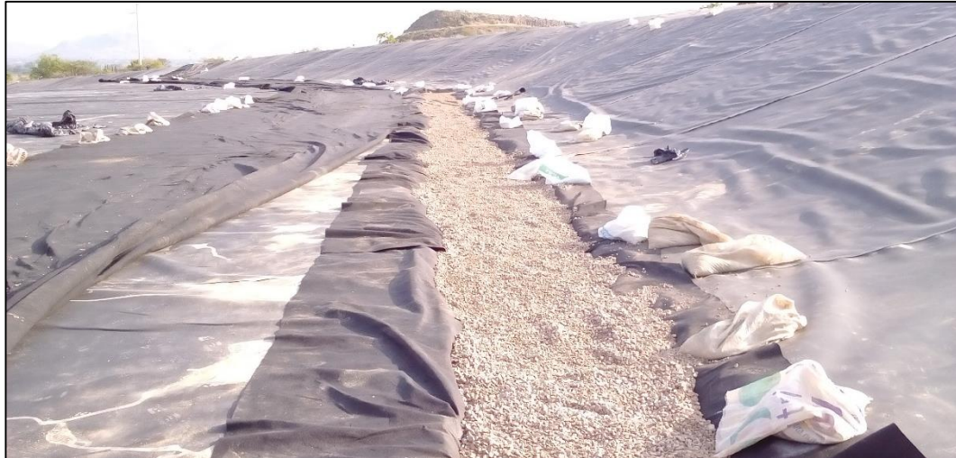
Fotografía 3-7: Construcción del sistema de drenaje Interno del depósito.
