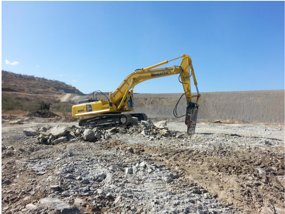
Foto N° 5: Corte de roca fija con excavadora equipada con martillo hidráulico.
