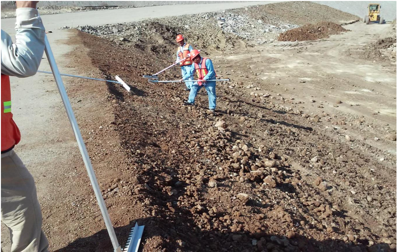
Foto N° 11: Afine de taludes del vaso con personal obrero.
