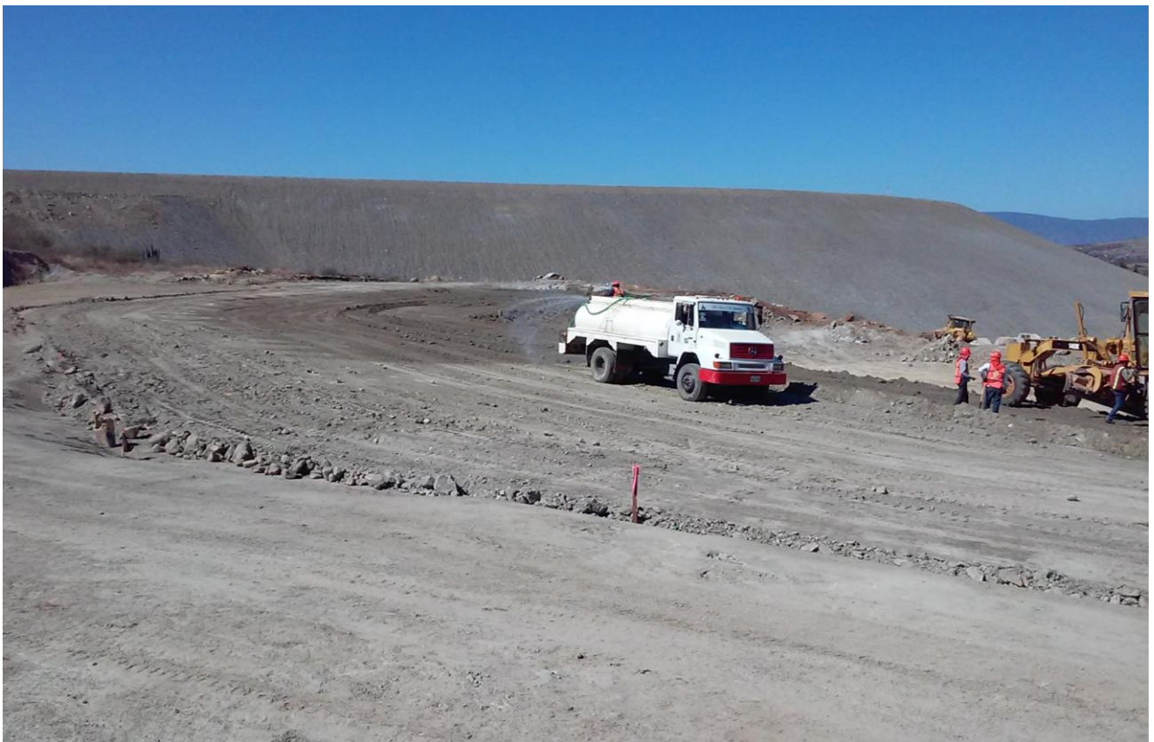
Foto N° 6: Riego del material extendido para mejorar la compactación y control de polución.
