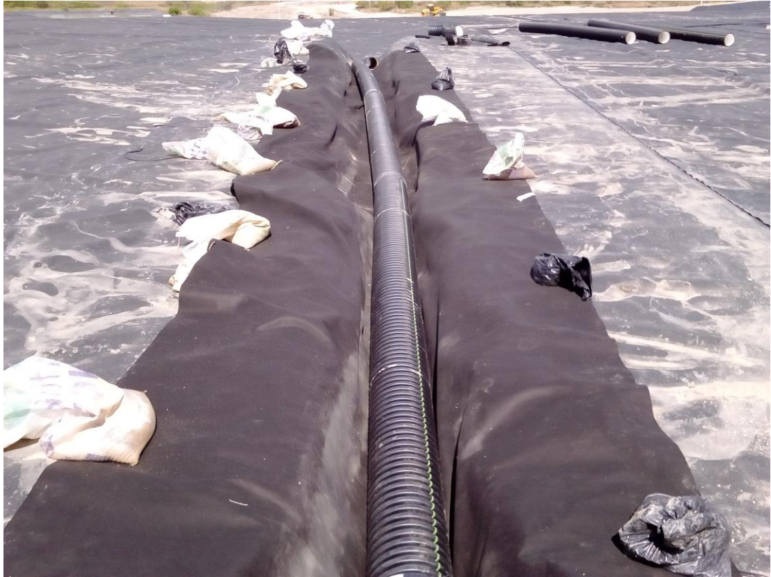
Foto N° 7: instalación de tubería corrugada de 12" del sistema de drenaje interno.
