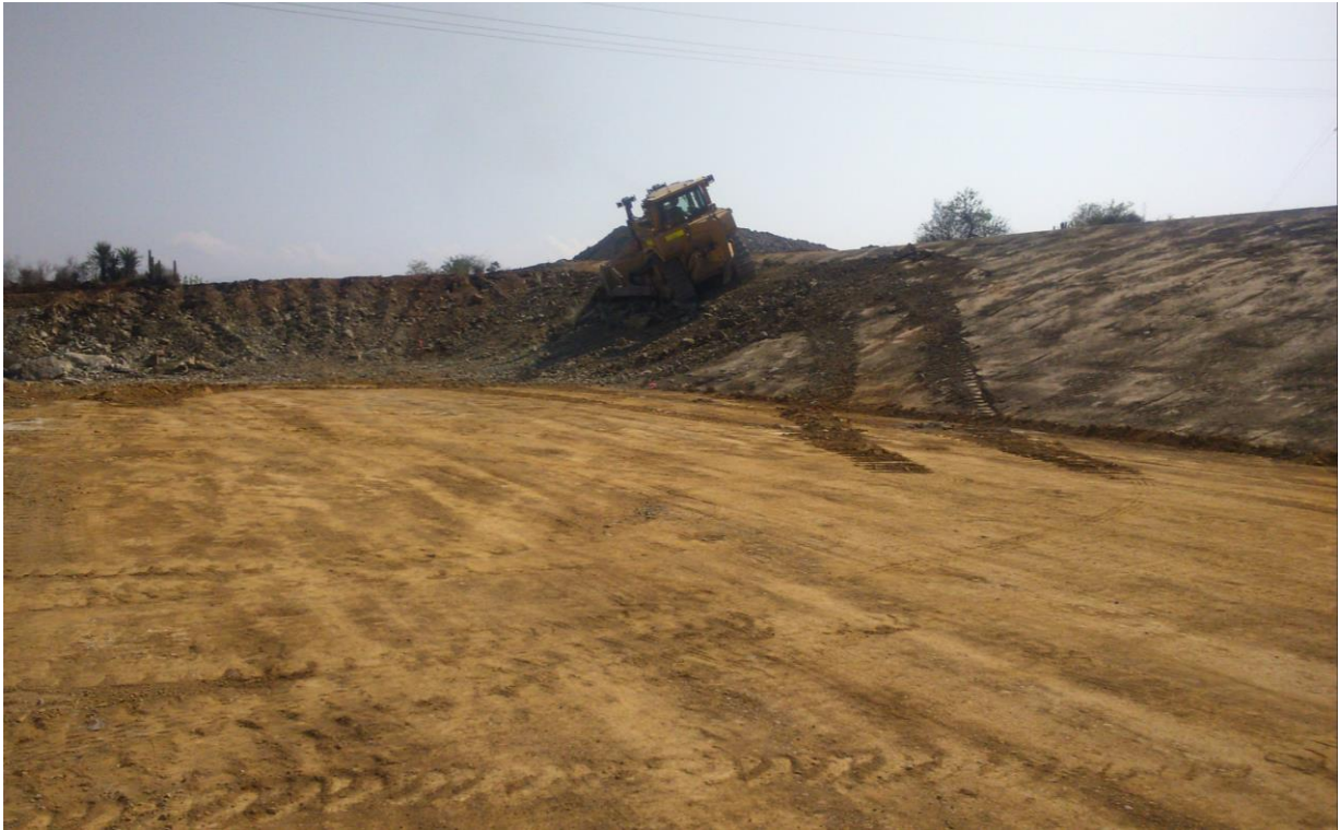
Foto N° 13: Nivelación de taludes y plataformas con tractor D8T.
