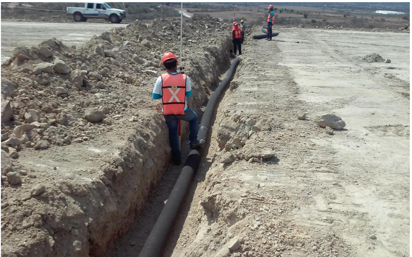
Foto N° 12: Control de cotas en la instalación de ramales del sistema de subdrenaje.
