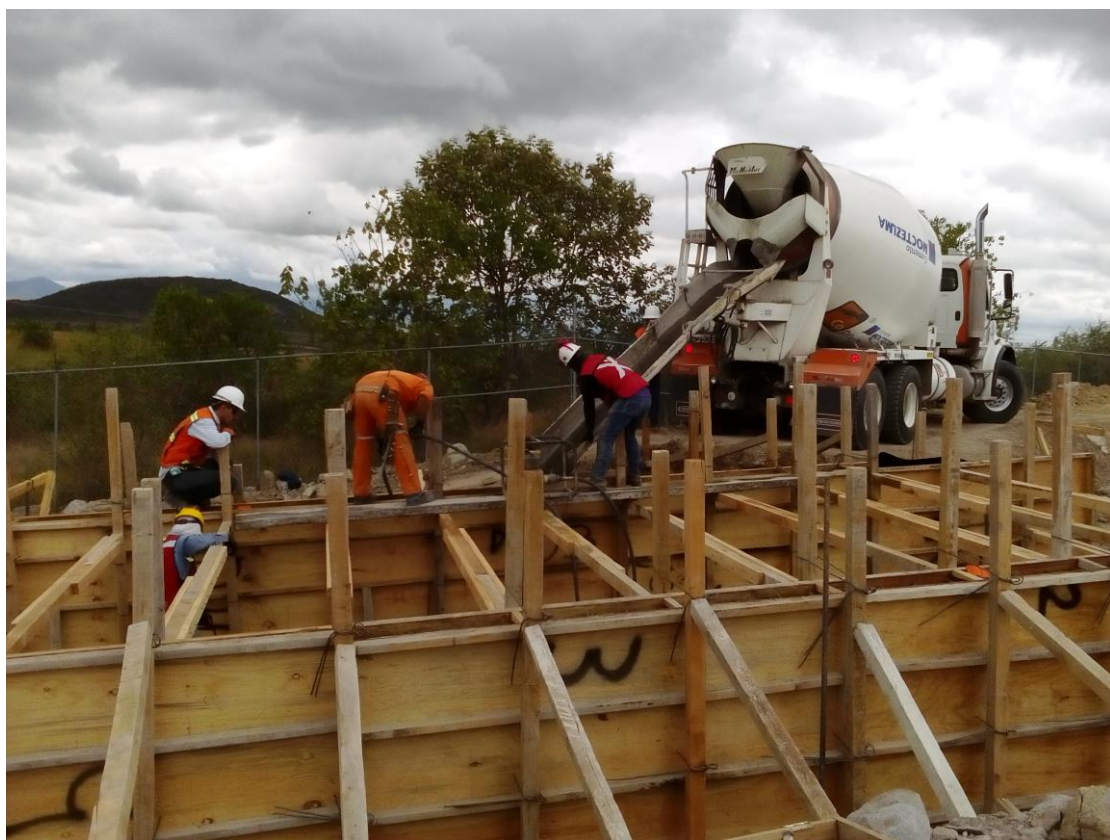
Foto N° 10: Actividades de colado del vertedero de descarga.
