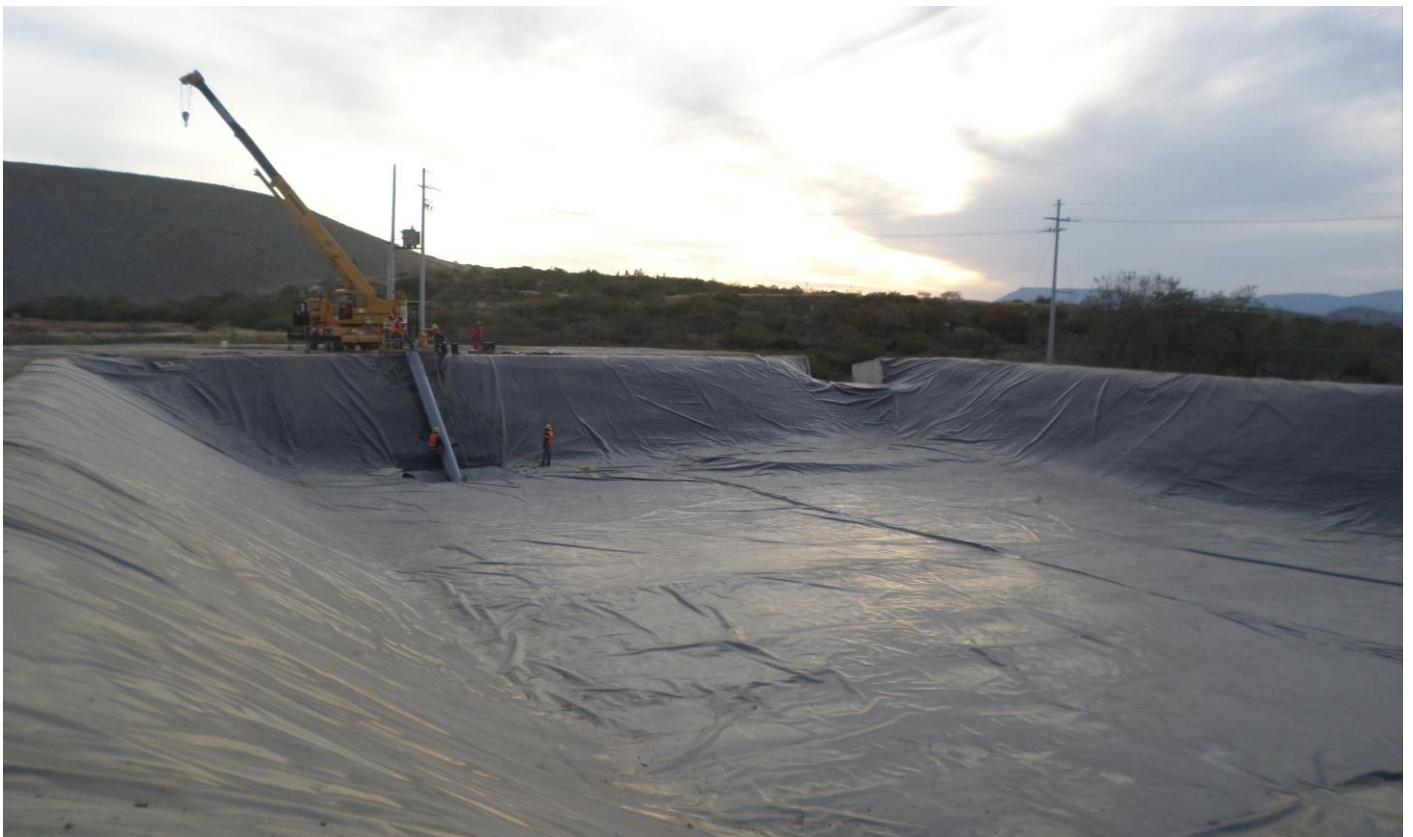
Foto N° 16: Vista de la poza del sistema de drenaje superficial concluida.
