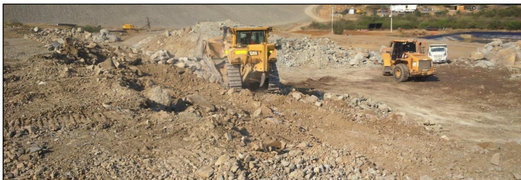
Fotografía 3-3: Preparación de la superficie del vaso del depósito.
