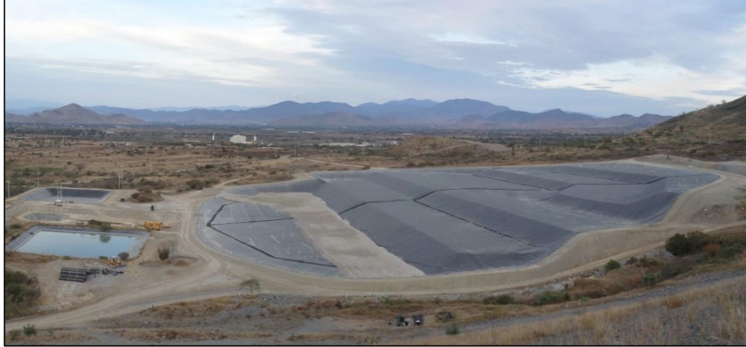
Fotografía 1-1: Vista panorámica de la cimentación del depósito de relaves filtrados concluido.
