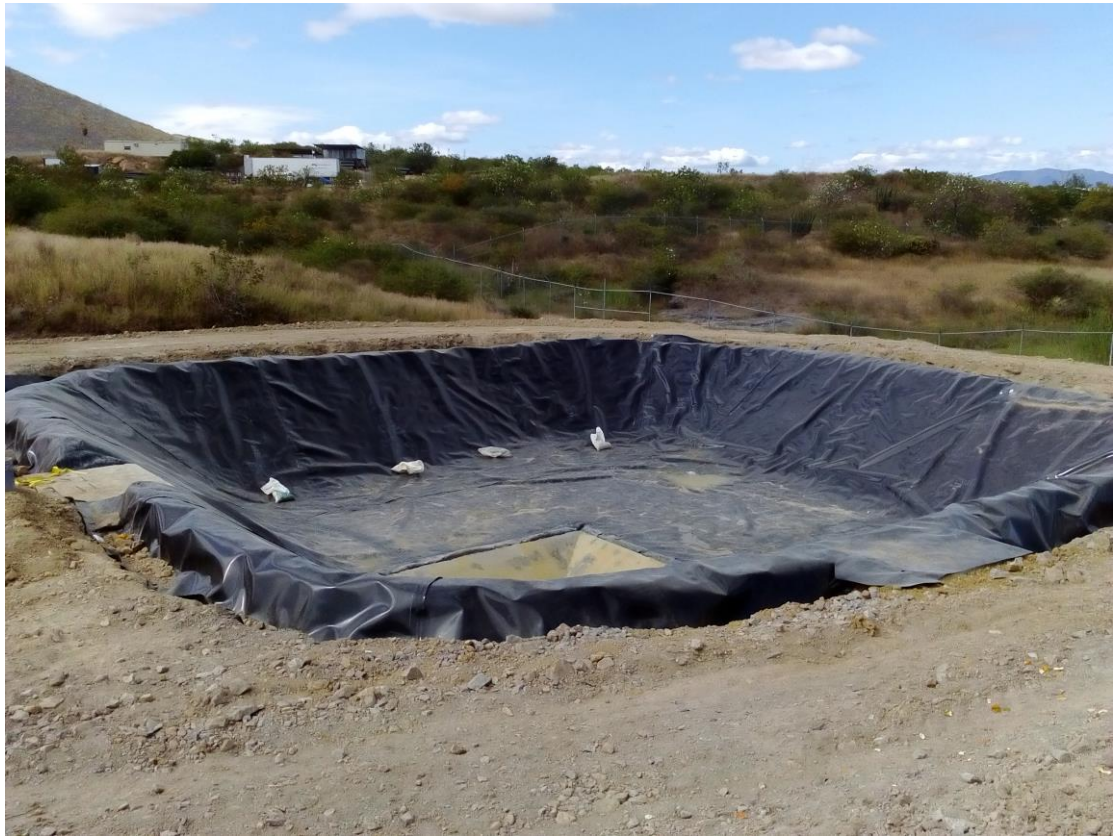
Foto N° 15: Colocación de cobertura impermeable en poza del sistema de drenaje interno.
