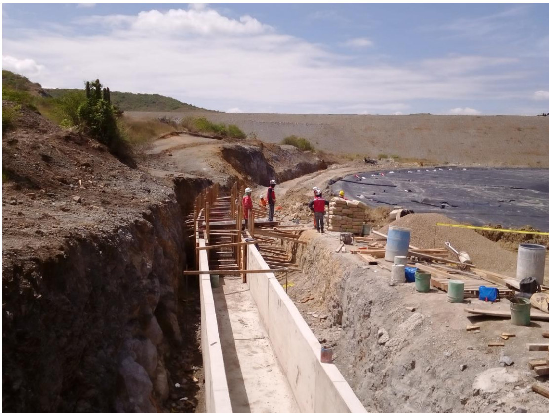
Foto N° 6: Vista de los trabajos de colado del canal de coronación.
