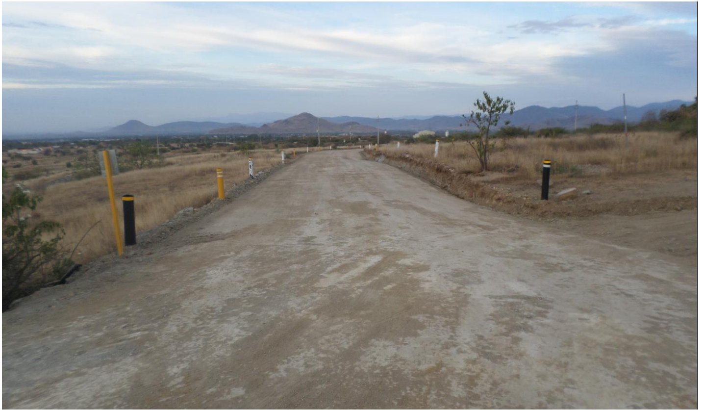
Foto N° 17: Vista del acceso de operación concluido.
