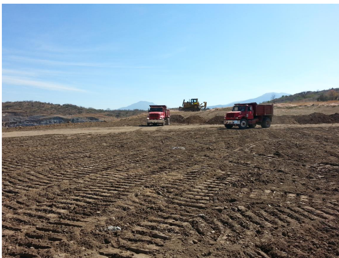
Foto N° 4: Apilamiento del material orgánico en el depósito de Top Soil N°1.
