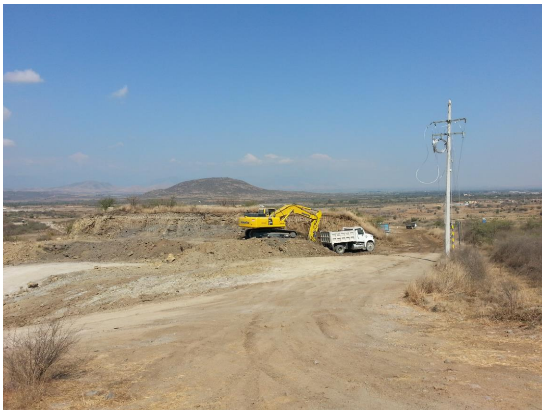
Foto N° 3: Carguío del material del depósito de top soil existente.
