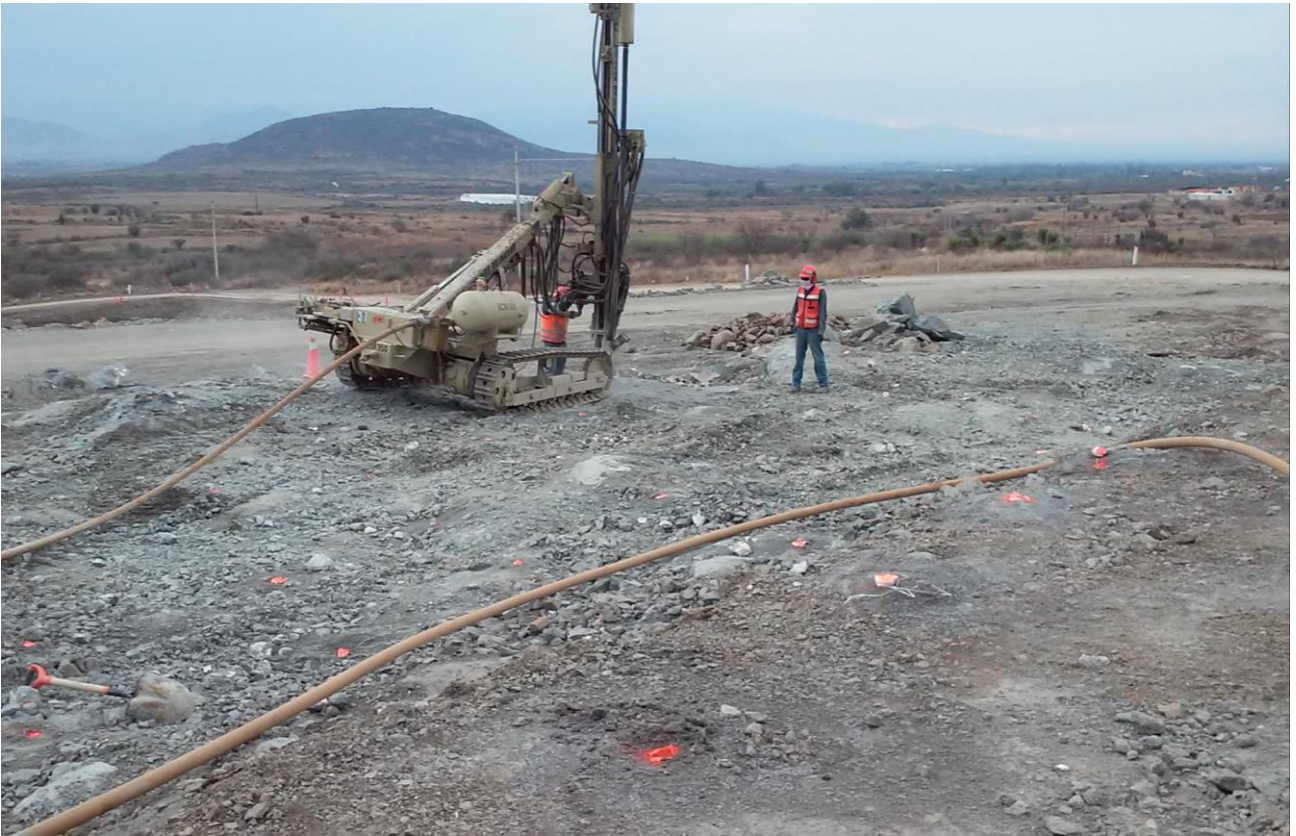
Foto N° 9: Trabajos de barrenación con track drill en zonas de roca fija.
