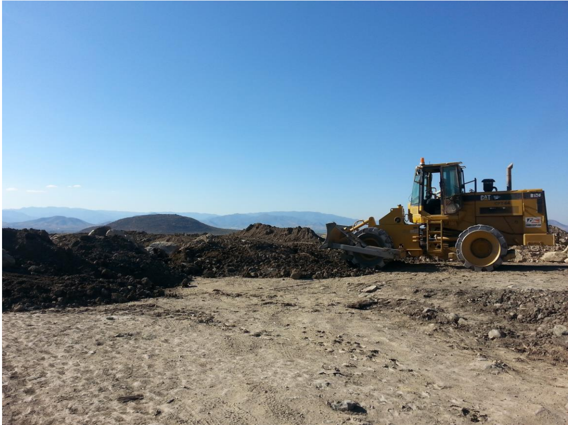
Foto N° 7: Compactación del suelo de cobertura vegetal en el depósito de Top Soil N°2.
