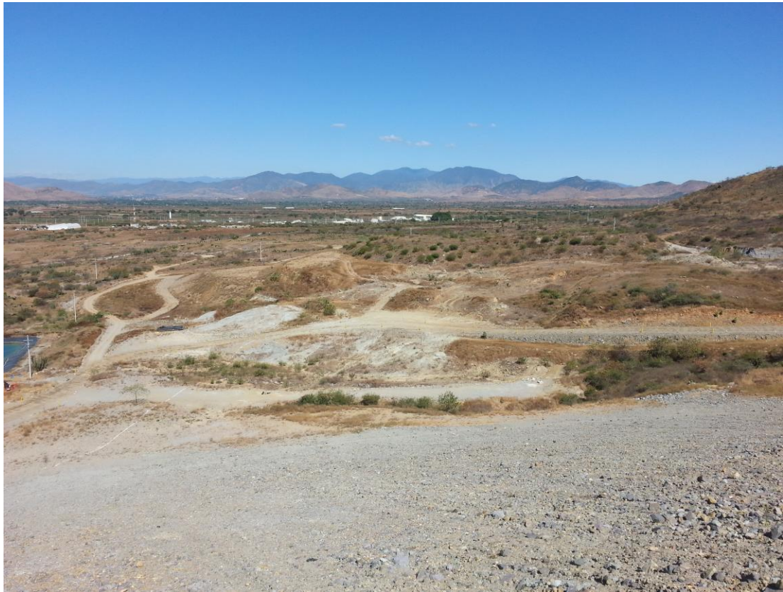
Foto N° 1: Vista inicial del área de emplazamiento del proyecto.
