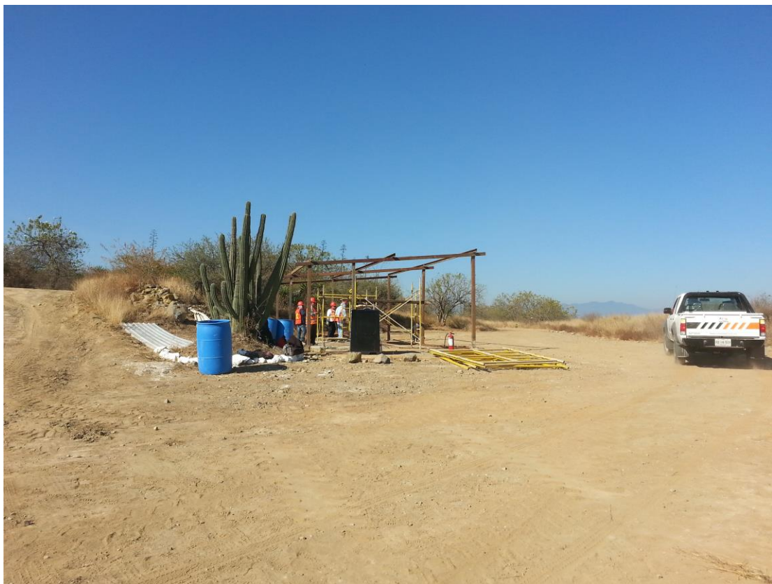
Foto N° 2: Habilitación del comedor del contratista.
