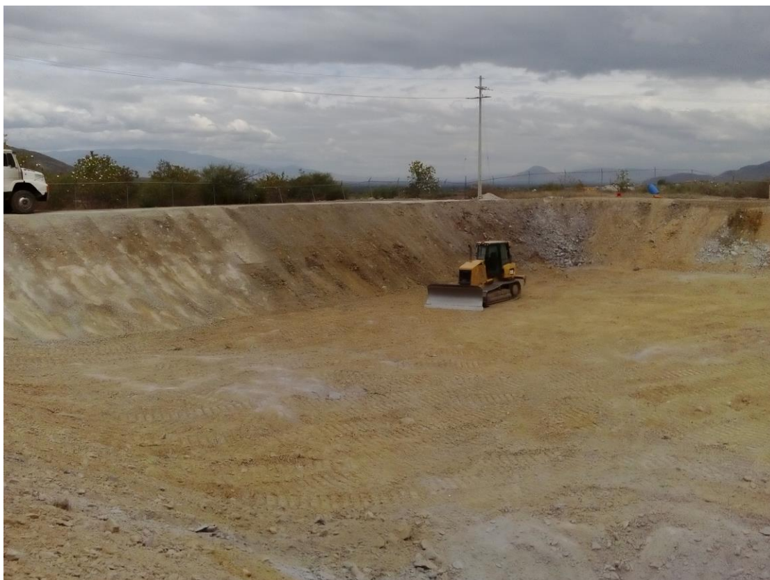
Foto N° 13: Perfilado y refine de la superficie de la poza del sistema de drenaje superficial.
