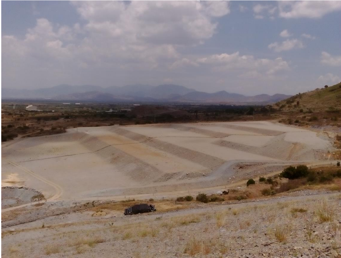
Foto N° 1: Vista del área de emplazamiento del proyecto al iniciar el segundo periodo de construcción.
