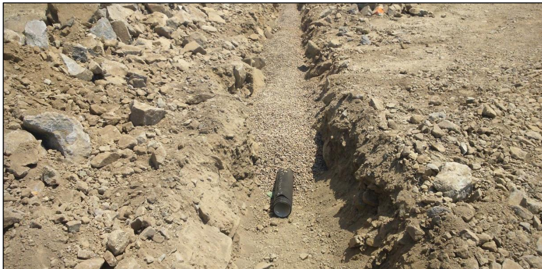
Fotografía 3-4: Construcción del sistema de sub-drenaje.
