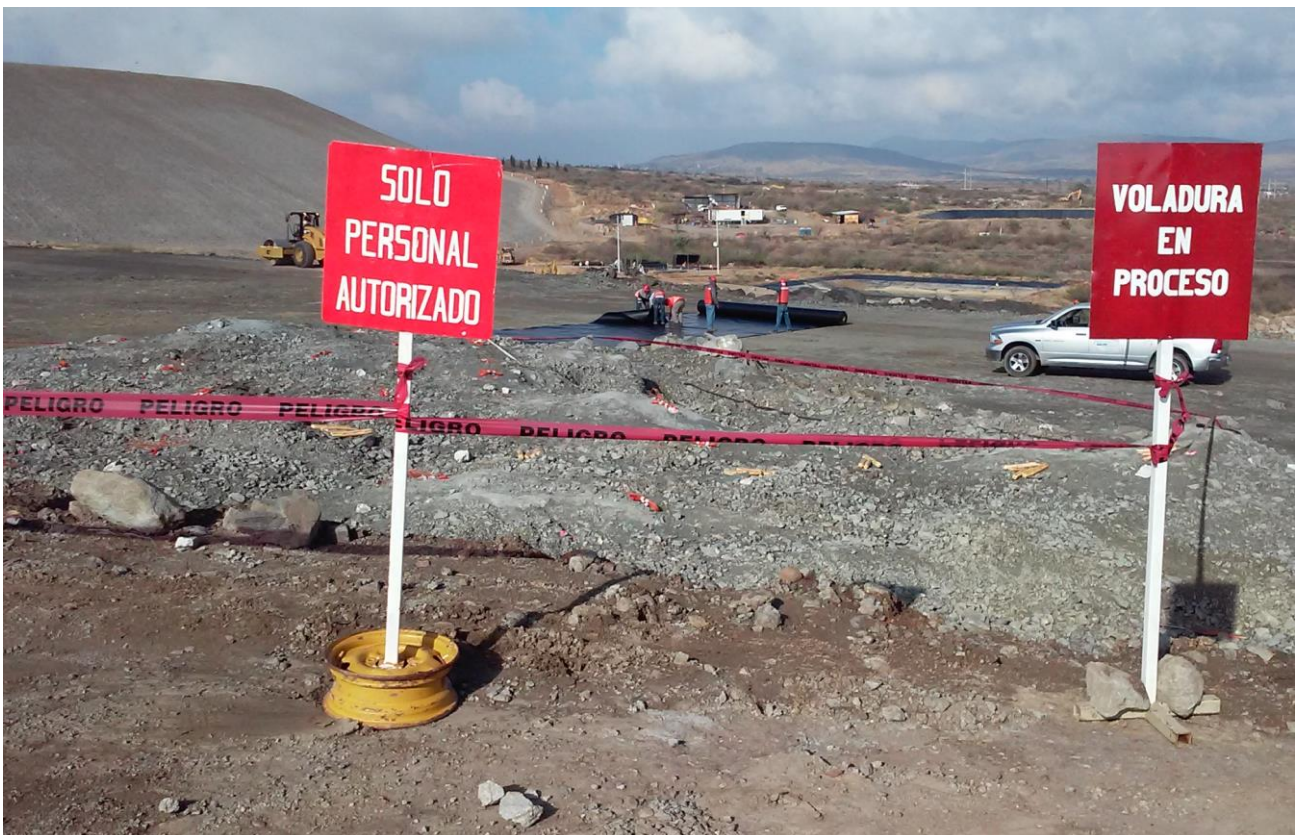
Foto N° 10: Señalización del área de voladura durante proceso de cargado de barrenos.
