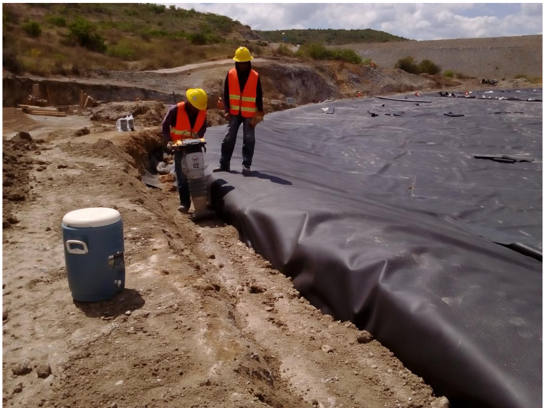
Foto N° 8: Relleno y compactación de zanja de anclaje de geosintéticos.
