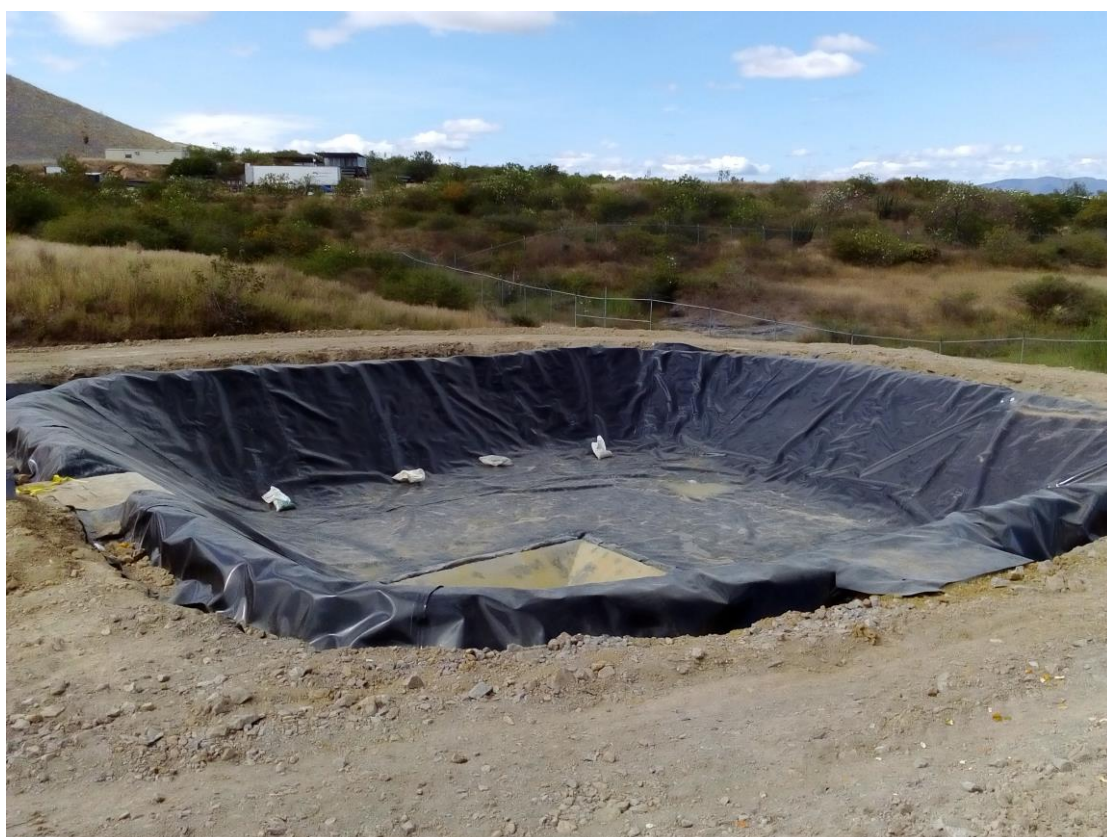
Foto N° 14: Colocación de cobertura impermeable en poza del sistema de drenaje interno.
