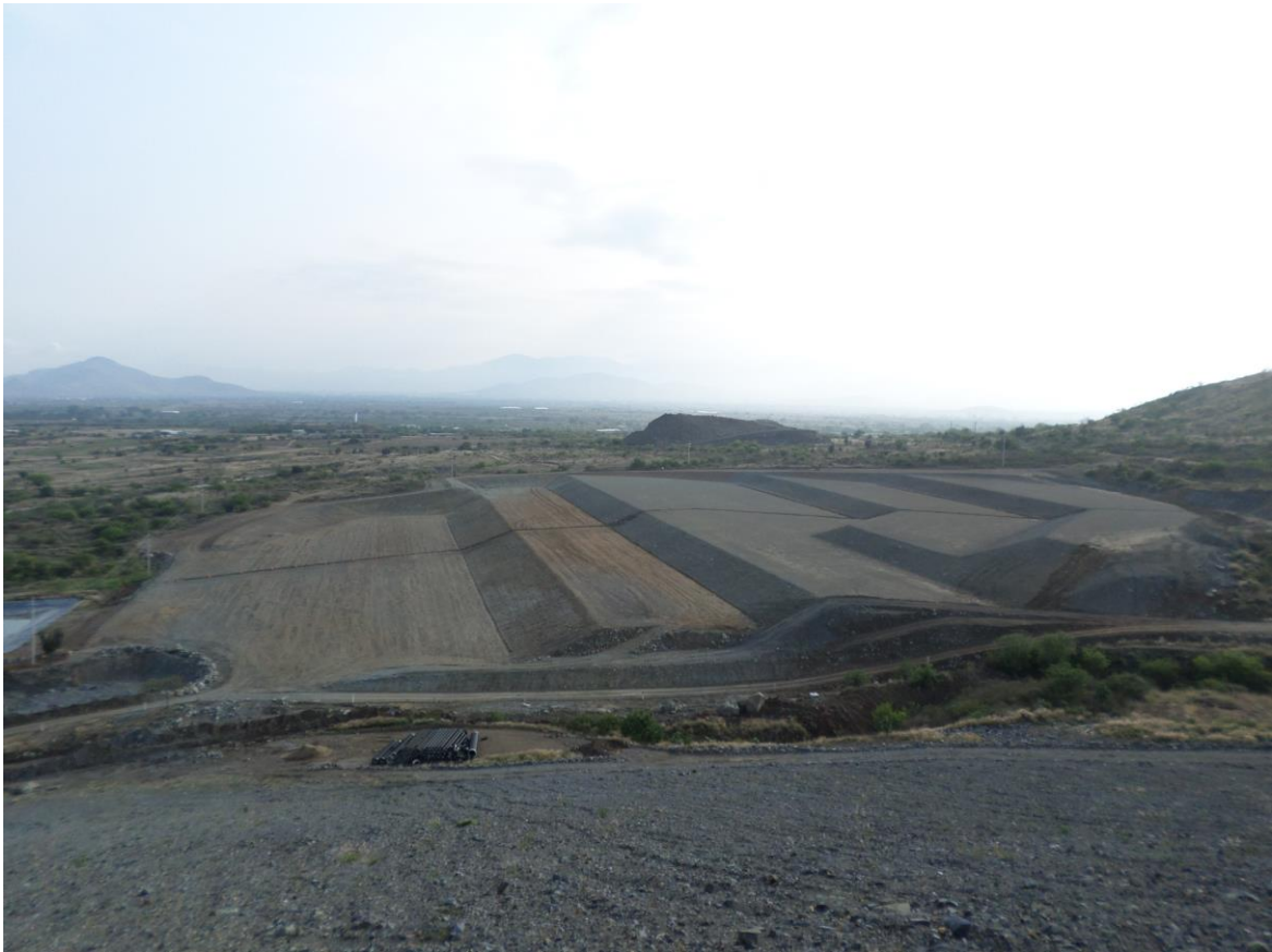
Foto N° 14: Vista del área del depósito al final del primer periodo de construcción.
