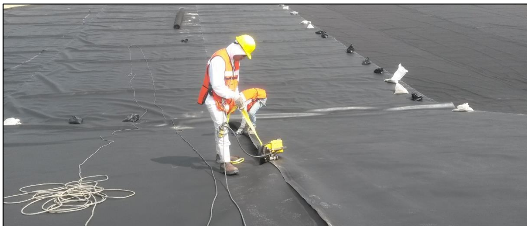
Fotografía 3-6: Instalación de la cobertura geosintética sobre la superficie del vaso del depósito.
