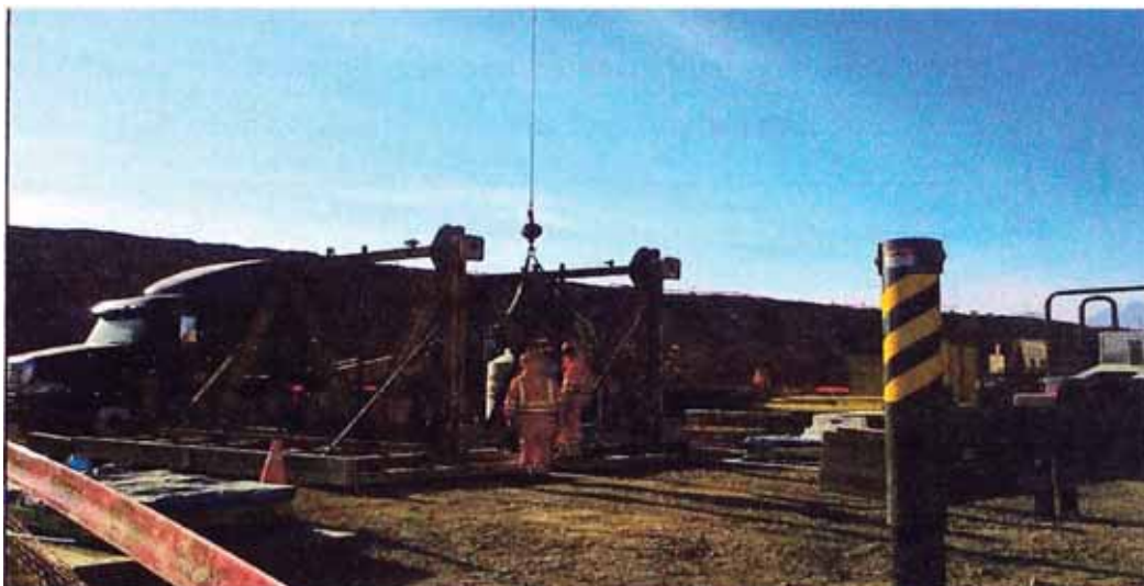
Figura N° 34: Izamiento de molde de encofrado – Proyecto CV 2 Fase 1 K109 (Fuente: Fotografías del Equipo Implementador – CGP)
