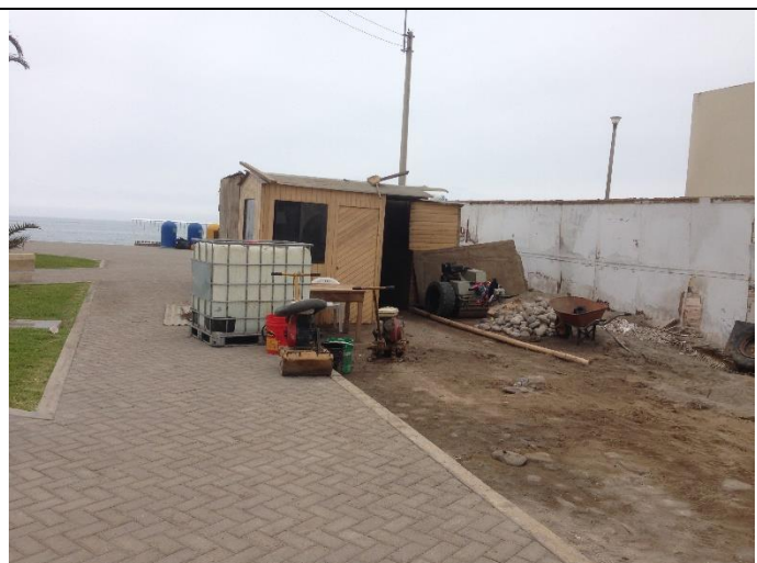
VISTA DEL ALMACEN DE OBRA
