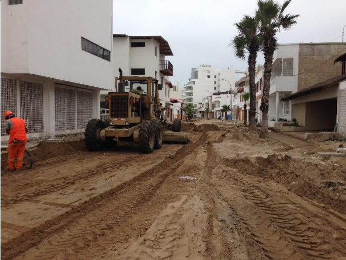
TRABAJOS DE EXTENDIDO DE MATERIAL GRANULAR PARA SUBRASANTE MEJORADA (e=0.10m), PROG. 0+080
