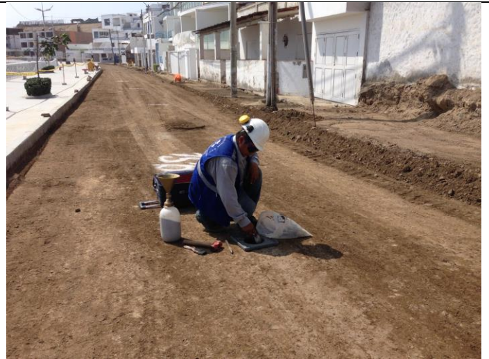
ENSAYO DE DENSIDAD DE CAMPO A LA SUBRASANTE MEJORADA, PROG. 0+403
