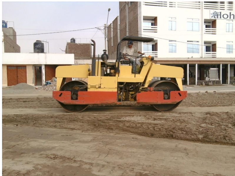
FIGURA N° 2-5: COMPACTACIÓN DEL TERRENO DE FUNDACIÓN
