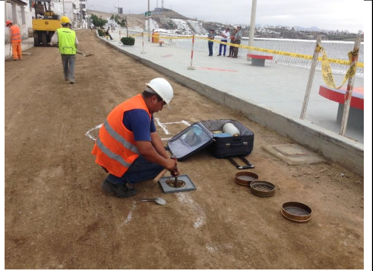
ENSAYO DE DENSIDAD DE CAMPO A LA CAPA DE BASE, PROG. 0+500
