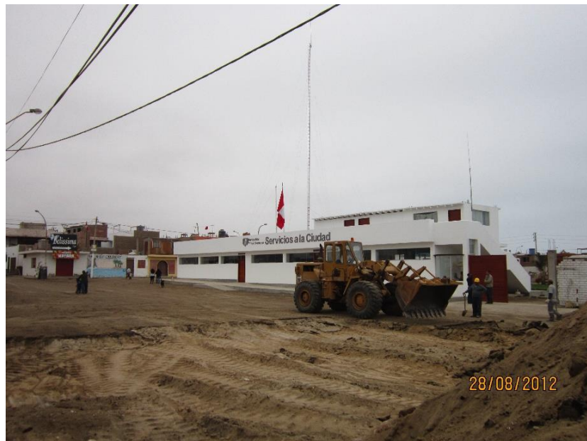
FIGURA N° 2-2: EXCAVACIÓN HASTA TERRENO DE FUNDACIÓN
