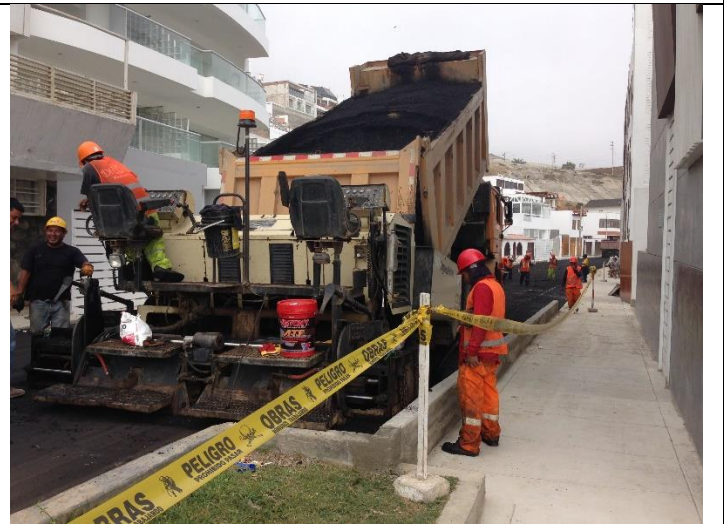
TRABAJOS DE COLOCACION DE LA CARPETA ASFALTICA
