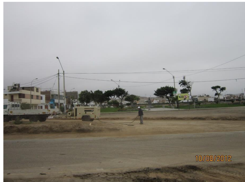
FIGURA N° 2-8: LIMPIEZA PARA LA IMPRIMACIÓN
