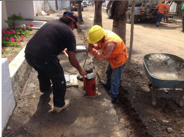
ELABORACION DE PROBETAS DEL CONCRETO PARA SARDINEL
