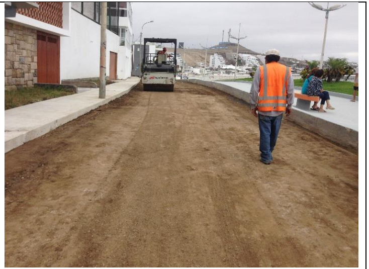
COMPACTACION DE CAPA DE BASE GRANULAR
