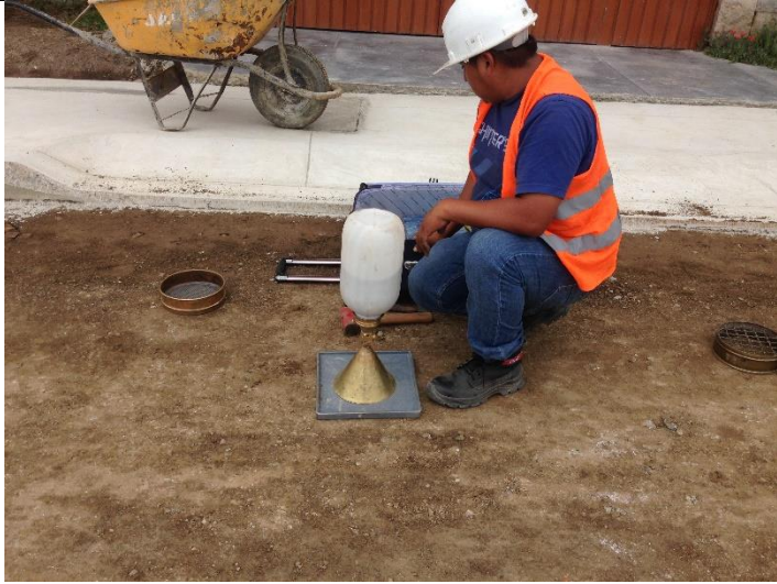
ENSAYO DE DENSIDAD DE CAMPO A LA CAPA DE BASE, PROG. 0+340
