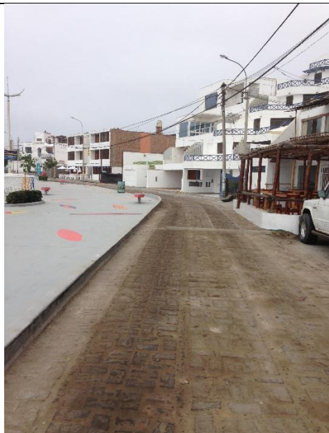
TERRENO NATURAL ANTES DE REALIZAR LAS DEMOLICIONES
