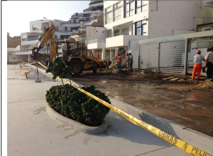
VACEADO DE CONCRETO EN SARDINEL
