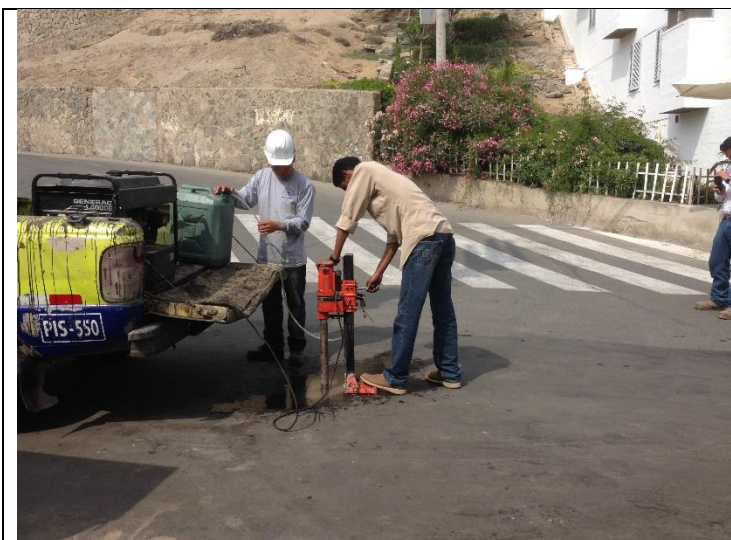
EXTRACCIÓN DE DIMANTINAS. PROG. 0+003
