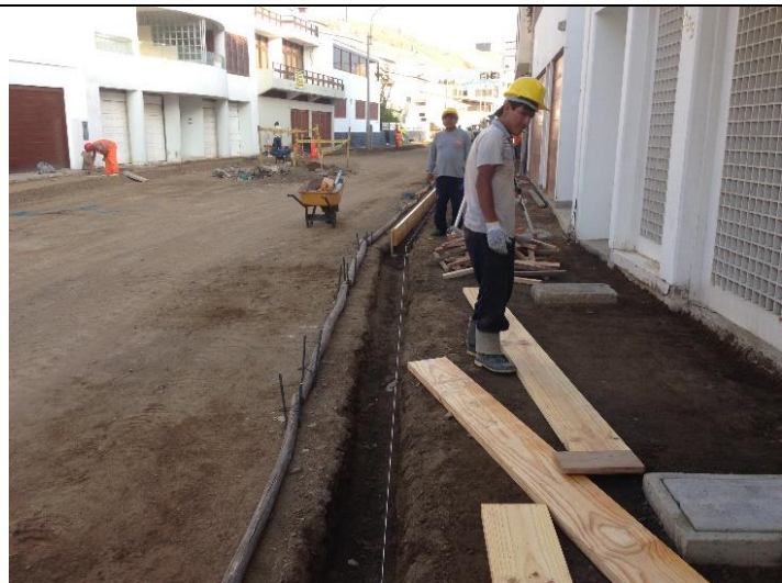
TRABAJOS DE ENCOFRADO DE SARDINEL
