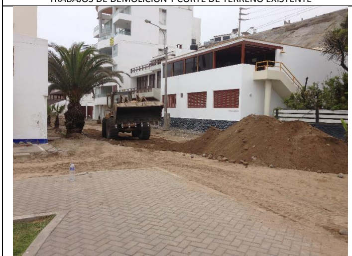
APILAMIENTO DE MATERIAL DE CORTE PARA SU POSTERIOR ELIMINACIÓN
