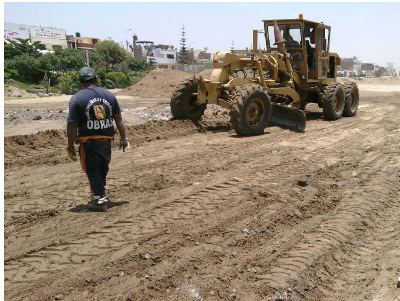
FIGURA N° 2-4: CONFORMACIÓN DEL TERRENO DE FUNDACIÓN
