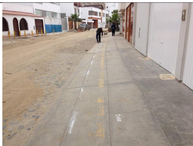
TERRENO NATURAL ANTES DE REALIZAR LAS DEMOLICIONES
