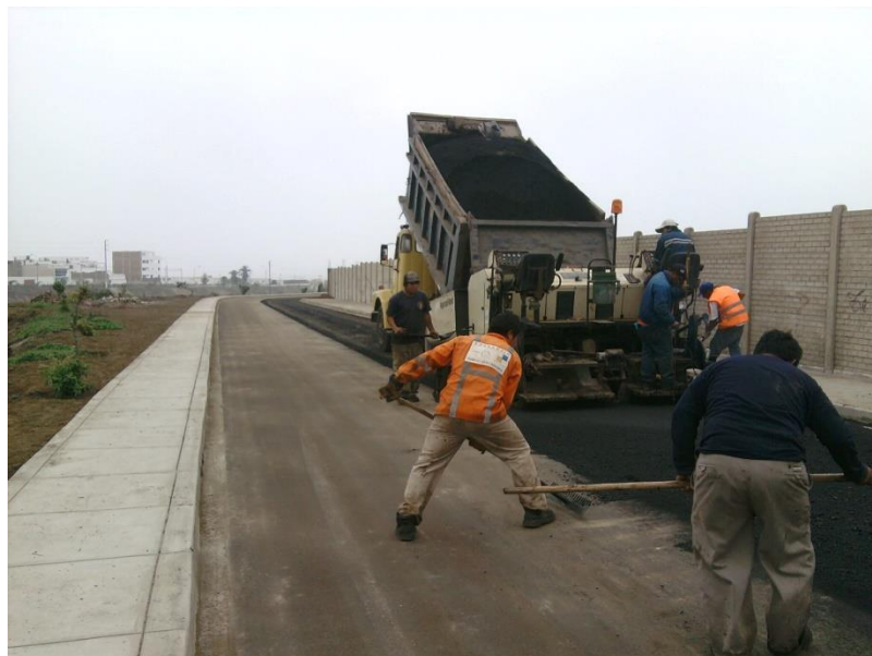
FIGURA N° 2-10: COLOCACIÓN DE CARPETA ASFÁLTICA
