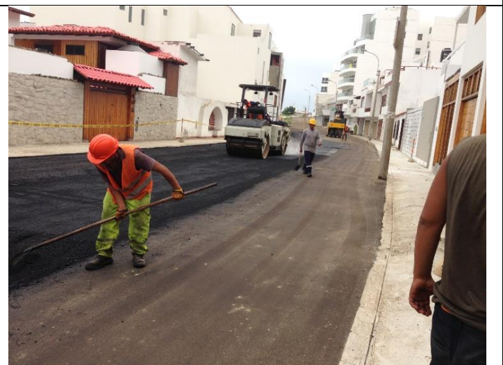
CONFORMACION DE LA CARPETA ASFALTICA
