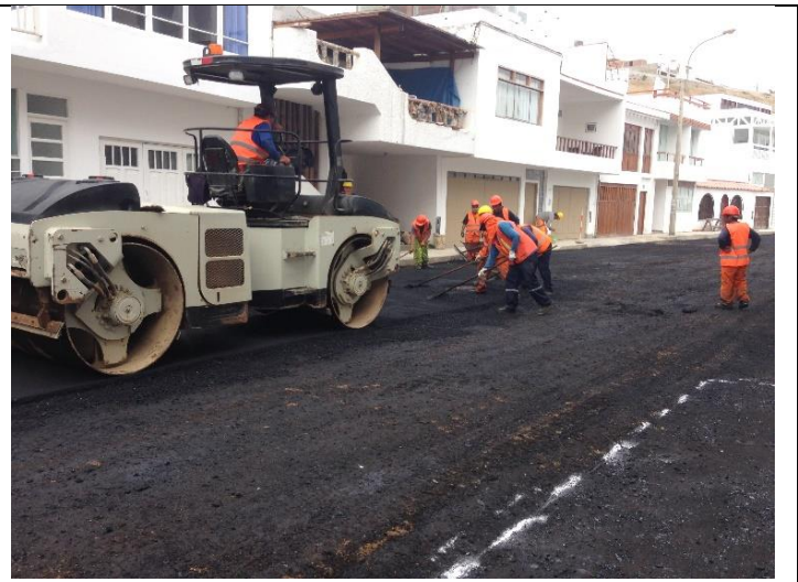
TRABAJOS DE COLOCACION DE LA CARPETA ASFALTICA
