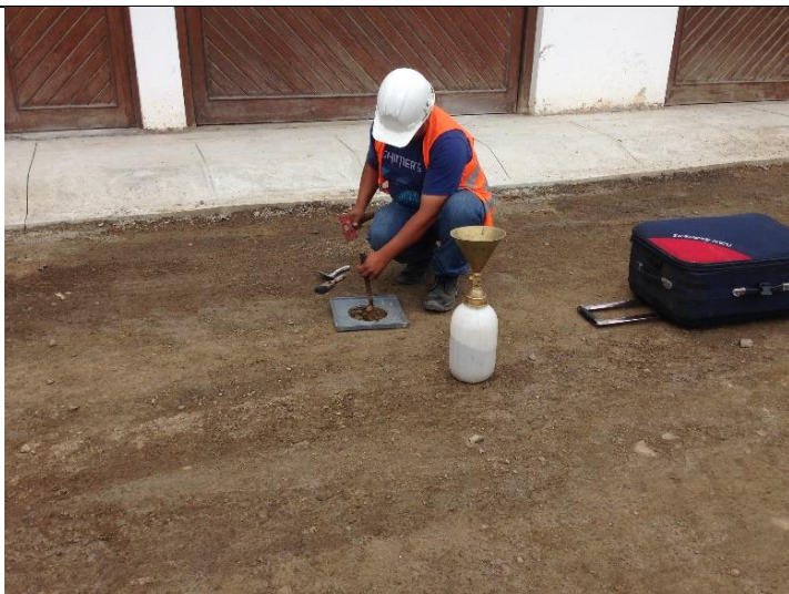
ENSAYO DE DENSIDAD DE CAMPO A LA CAPA DE BASE, PROG. 0+244
