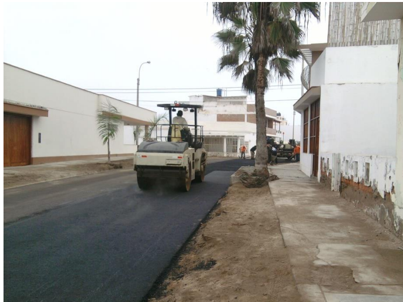
FIGURA N° 2-11: COMPACTACIÓN CON RODILLO LISO
