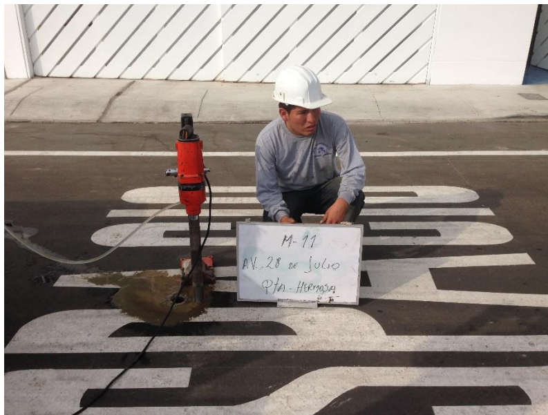
FIGURA N° 2-13: VERIFICACIÓN DE ESPESOR DE LA CARPETA ASFÁLTICA
