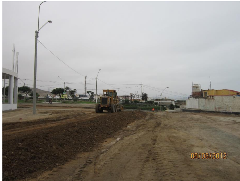
FIGURA N° 2-6: EXTENSIÓN Y PERFILAMIENTO DEL MATERIAL GRANULAR
