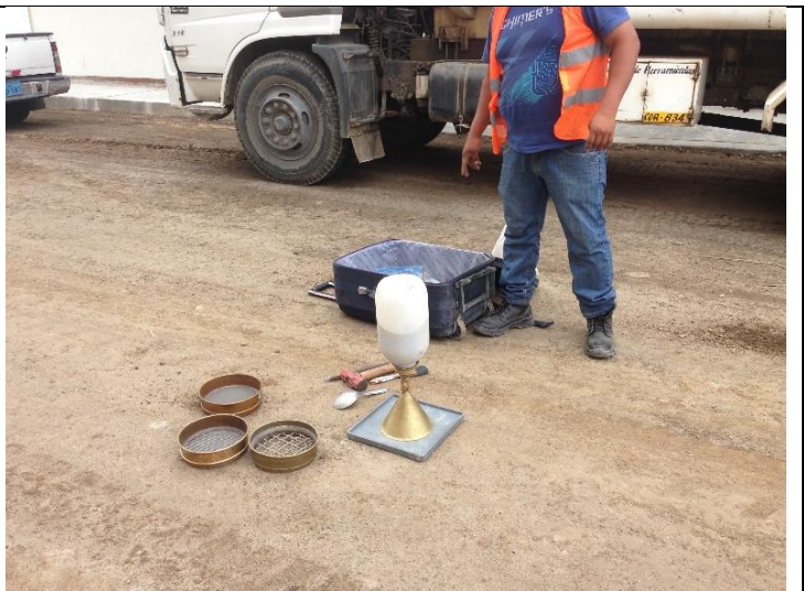
ENSAYO DE DENSIDAD DE CAMPO A LA CAPA DE BASE, PROG. 0+052
