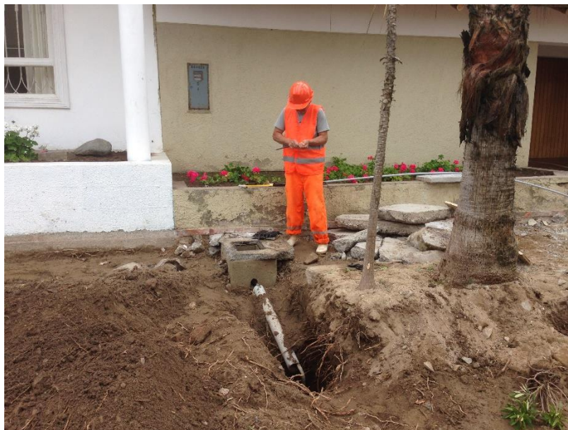
FIGURA N° 3-2: REPARACIÓN DE TUBERÍA
