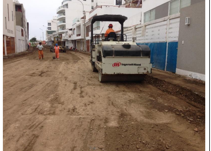
COMPACTACIÓN DE SUBRASANTE MEJORADA
