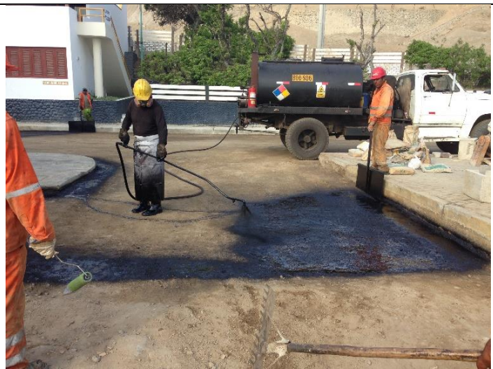
IMPRIMACION DEL AREA DE TRABAJO
