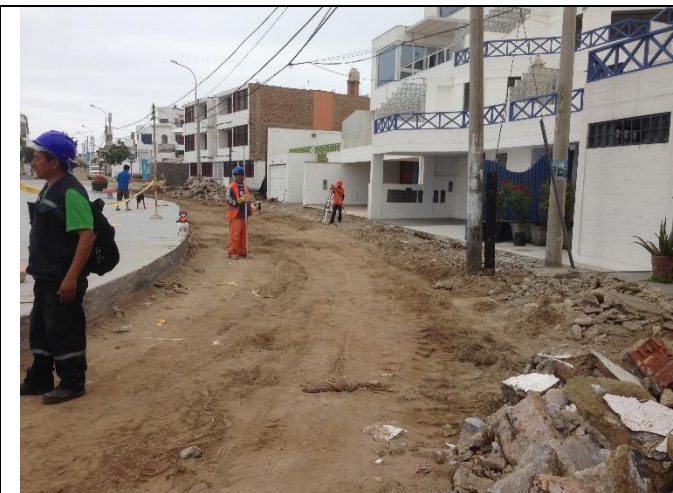
TRABAJOS DE TOPOGRAFIA A LA ALTURA DE LA PROGRESIVA 0+520
