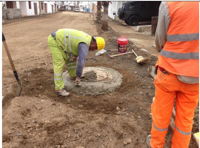
TRABAJOS DE NIVELACION DE BUZONES EXISTENTES
