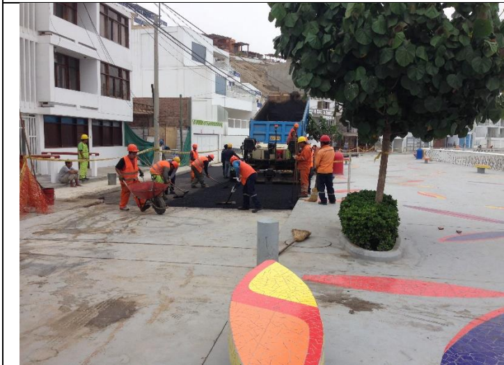
TRABAJOS DE COLOCACION DE LA CARPETA ASFALTICA
