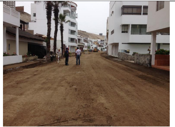
TRABAJOS DE VERIFICACION DE NIVBL DE CAPA DE BASE
