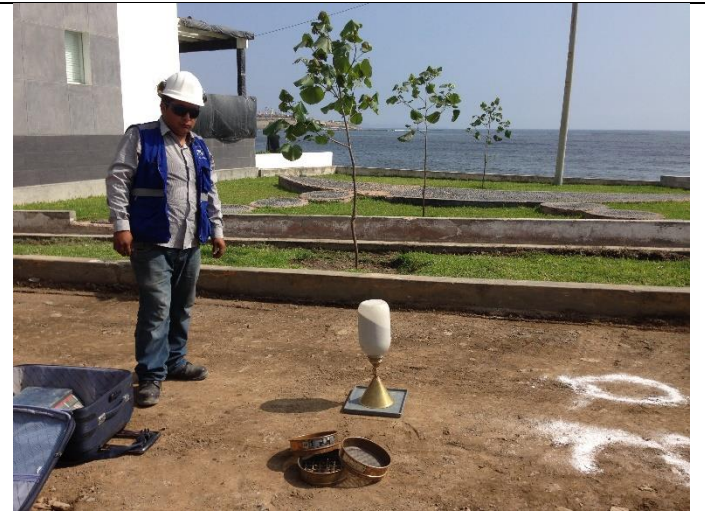
ENSAYO DE DENSIDAD DE CAMPO A LA SUBRASANTE MEJORADA, PROG. 0+303
