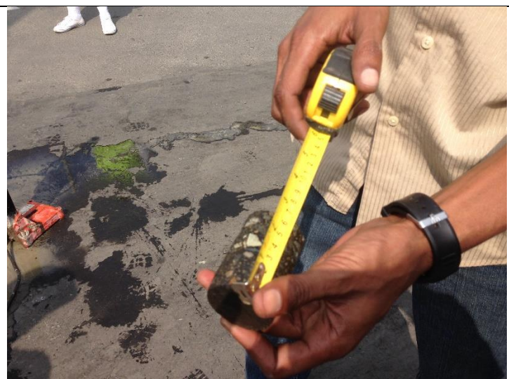
EXTRACCIÓN DE VDIMANTINAS. PROG. 0+150
