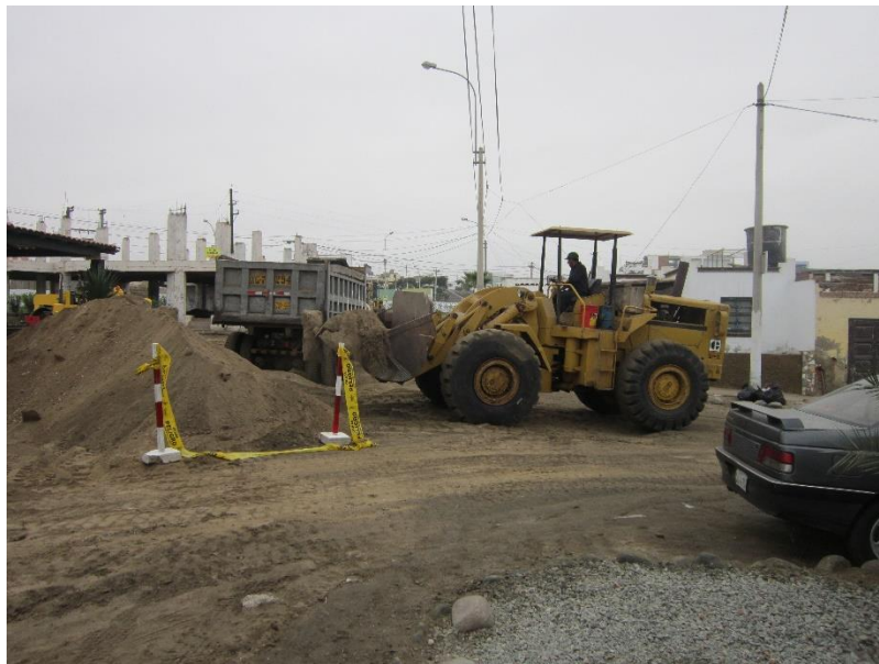
FIGURA N° 2-3: MATERIAL DE CORTE PARA ELIMINACIÓN
