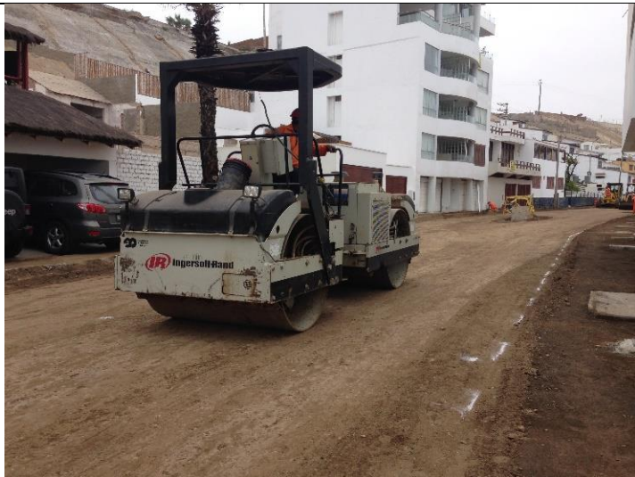
COMPACTACION DE CAPA DE BASE GRANULAR
