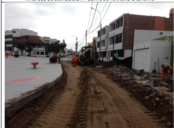
TRABAJOS DE DEMOLICIÓN Y CORTE DE TERRENO EXISTENTE
