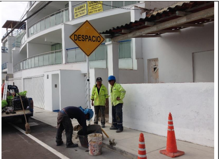
COLOCACION DE SEÑALIZACION VERTICAL
