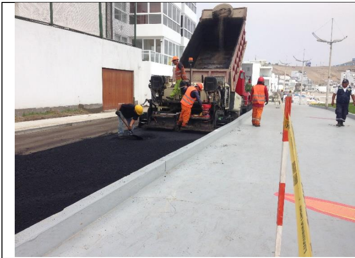
TRABAJOS DE COLOCACION DE LA CARPETA ASFALTICA
