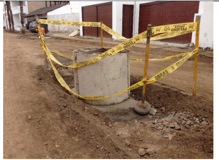
TRABAJOS DE NIVELACION DE BUZONES EXISTENTES
