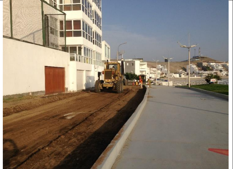
TRABAJOS DE CONFORMACION DE CAPA DE BASE, PROG. 0+280
