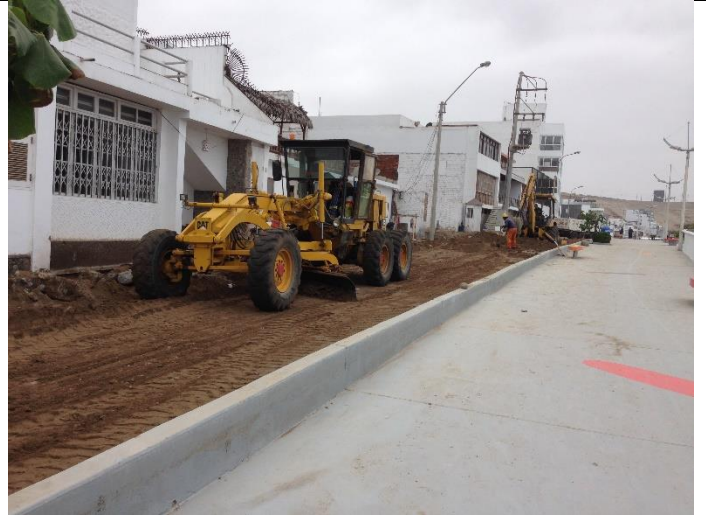
TRABAJOS DE EXTENDIDO DE MATERIAL GRANULAR PARA SUBRASANTE MEJORADA (e=0.10m), PROG. 0+360
