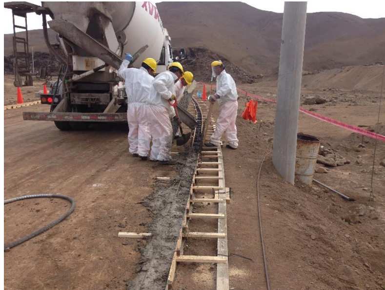
FIGURA N° 2-14: VACIADO DE CONCRETO A SARDINEL
