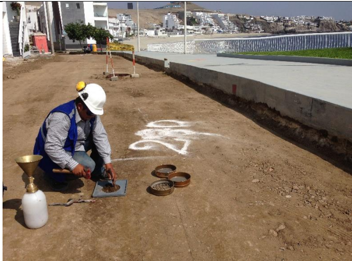
ENSAYO DE DENSIDAD DE CAMPO A LA SUBRASANTE MEJORADA, PROG. 0+353
