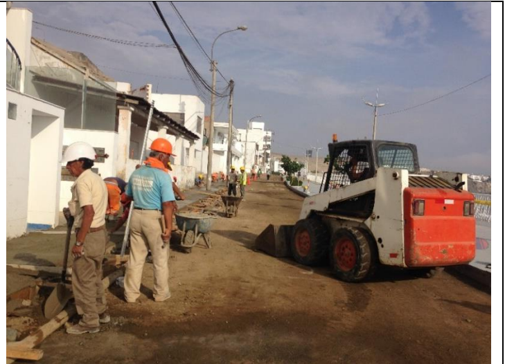
VACEADO DE CONCRETO EN SARDINEL
