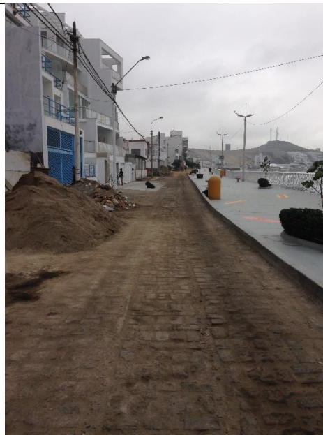
TERRENO NATURAL ANTES DE REALIZAR LAS DEMOLICIONES
