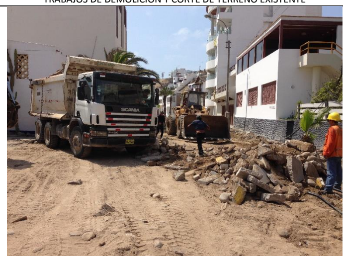
ELIMINACIÓN DE MATERIAL EN VOLQUETES DE 15 m 3
