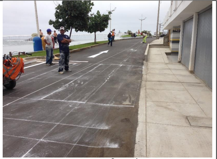
TRAZO PARA PINTADO DE SEÑALIZACIÓN HORIZONTAL
