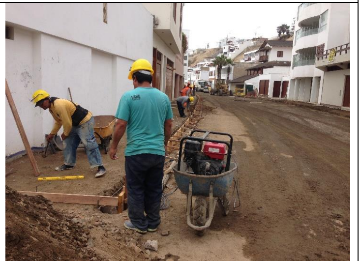
TRABAJOS DE ENCOFRADO DE SARDINEL
