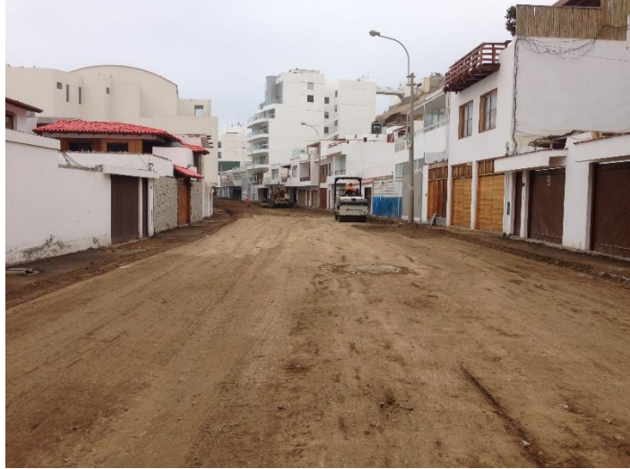
COMPACTACIÓN DE SUBRASANTE MEJORADA
