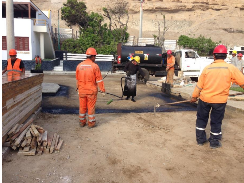
FIGURA N° 2-9: APLICACIÓN DE CAPA IMPRIMANTE
