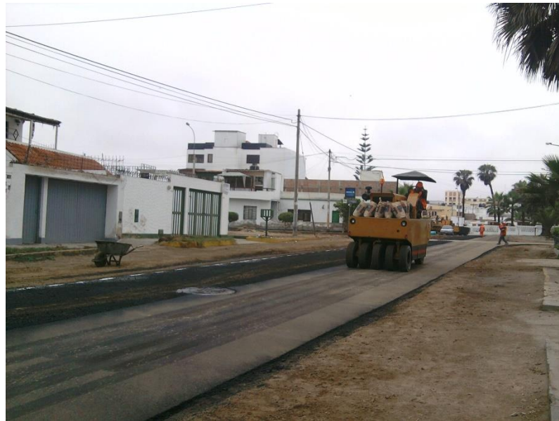
FIGURA N° 2-12: COMPACTACIÓN CON RODILLO NEUMÁTICO
