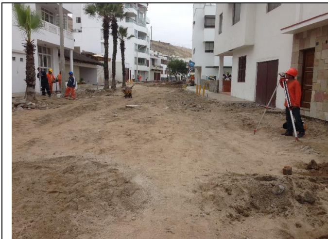
TRABAJOS DE TOPOGRAFIA A LA ALTURA DE LA PROGRESIVA 0+120
