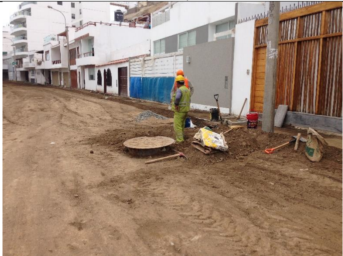
TRABAJOS DE NIVELACION DE BUZONES EXISTENTES
