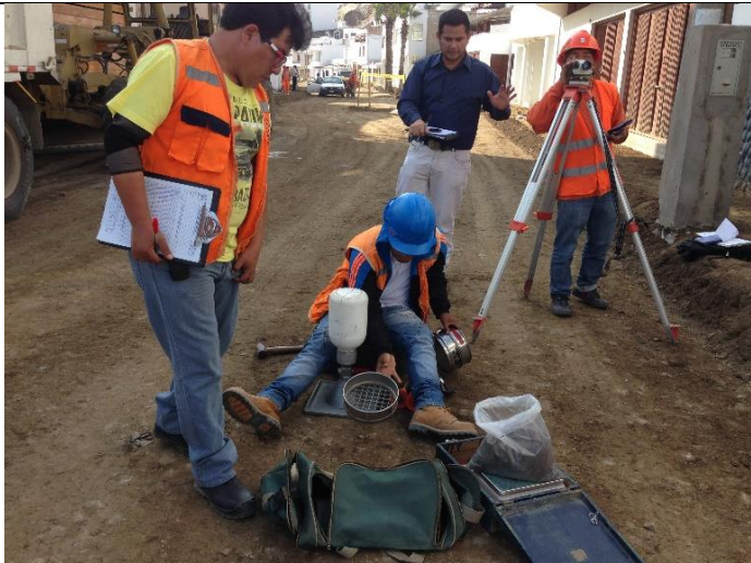
ENSAYO DE DENSIDAD DE CAMPO A LA SUBRASANTE MEJORADA, PROG. 0+047
