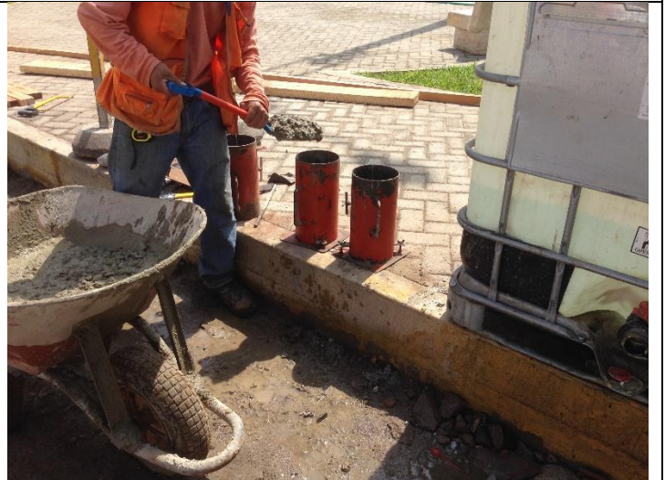
ELABORACION DE PROBETAS DEL CONCRETO PARA SARDINEL
