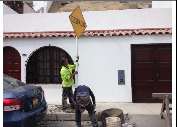
COLOCACION DE SEÑALIZACION VERTICAL
