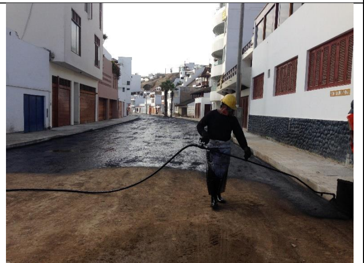
IMPRIMACION DEL AREA DE TRABAJO
