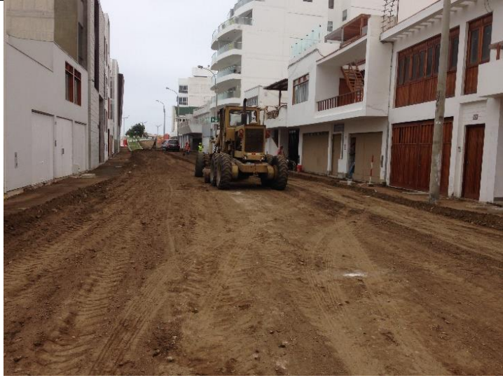
TRABAJOS DE CONFORMACION DE CAPA DE BASE, PROG. 0+220
