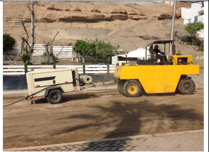
COMPRESORA UTILIZADA PARA LA LIMPIEZA DEL AREA DE TRABAJO
