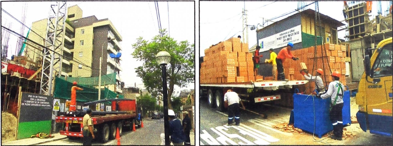
Figura N° 4.16 Trabajos de acarreo de materiales con el uso de la grúa torre.
