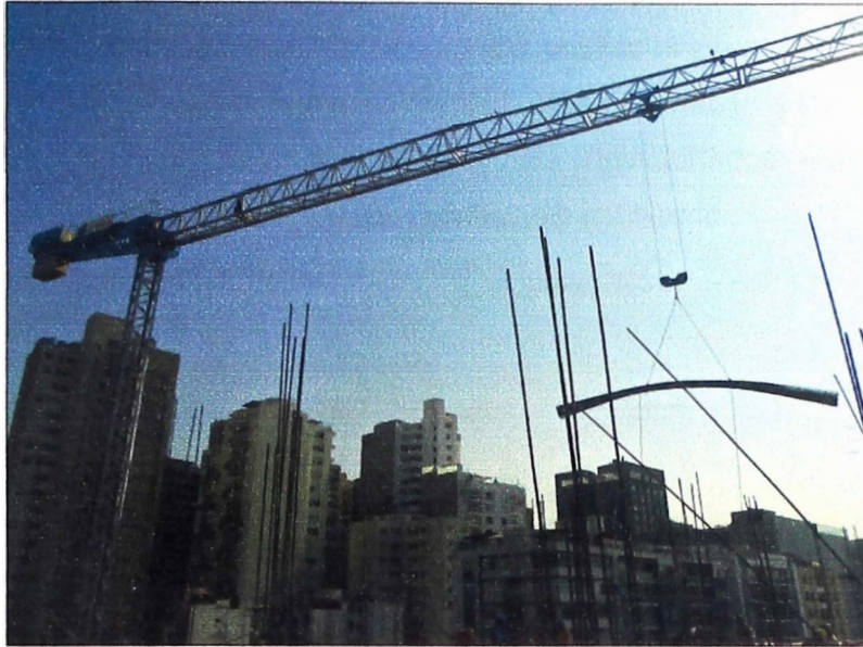
Figura N° 2.8 Acarreo de material.
