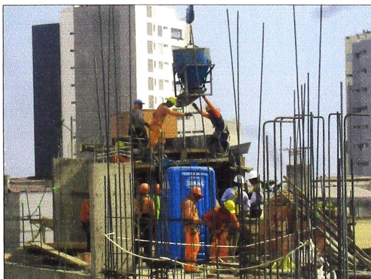
Figura N° 2.10 Vaciado de Concreto.
