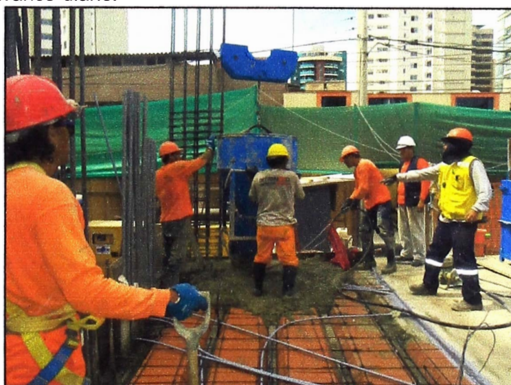
Figura N° 4.15 Vaciado de concreto en elementos horizontales con el uso de la grúa torre.
