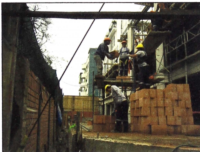
Figura N° 4.3 Trabajos de acarreo de materiales con una cuadrilla numerosa de trabajadores.
