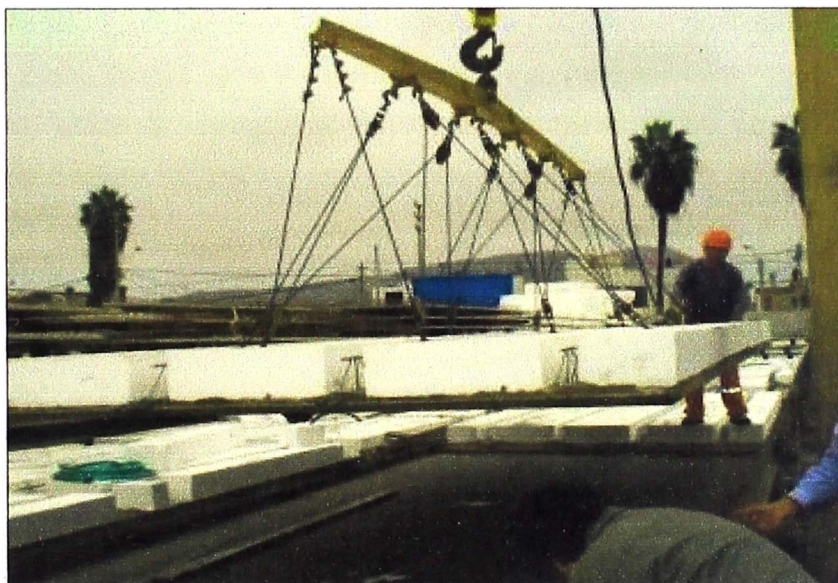
Figura N° 2.11 Acarreo de Pre losas.
