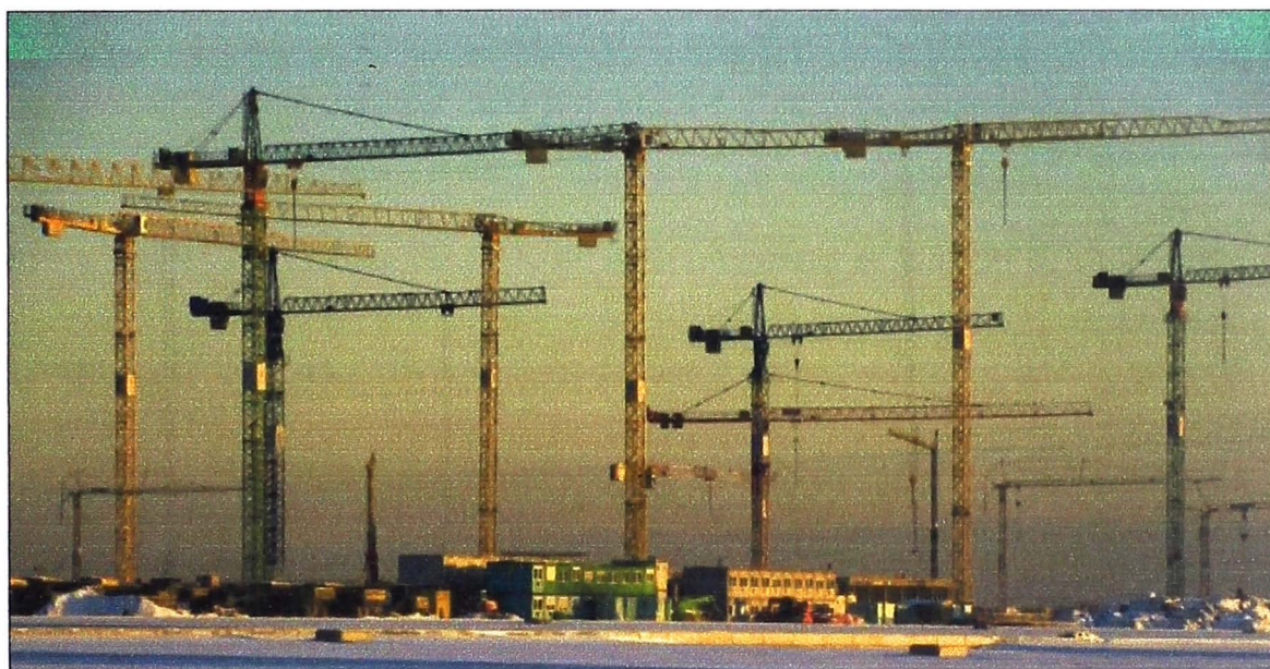
Figura N° 2.1 Imagen de Grúas Torre.
