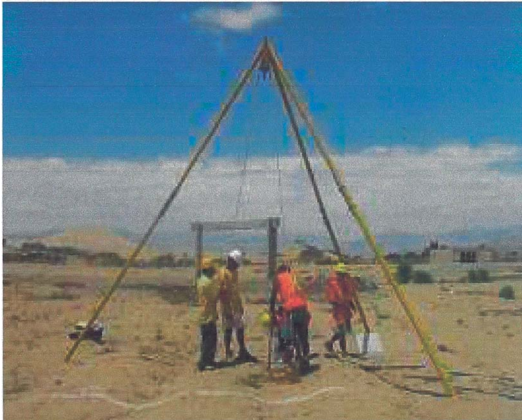
Figura. N° 7: Ejecución del Ensayo de Penetración Estándar (SPT).
