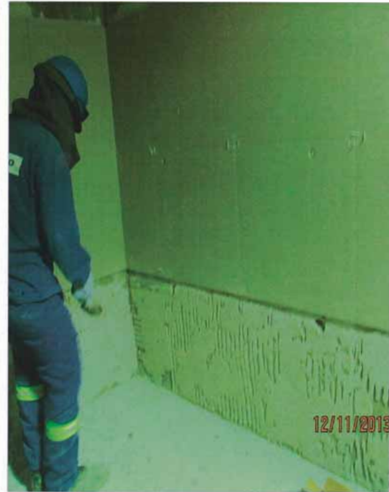
Figura N°37: Colocación de enchape sobre muro blanqueado
