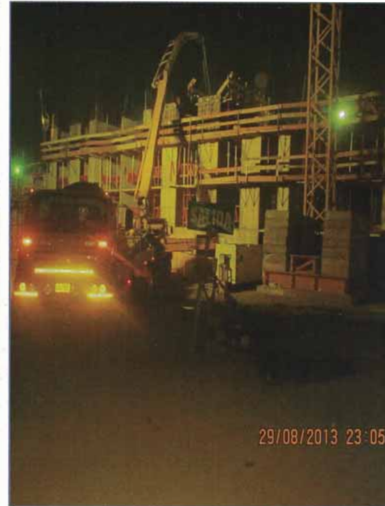
Figura N°59: Fotografía nocturna de vaciado
