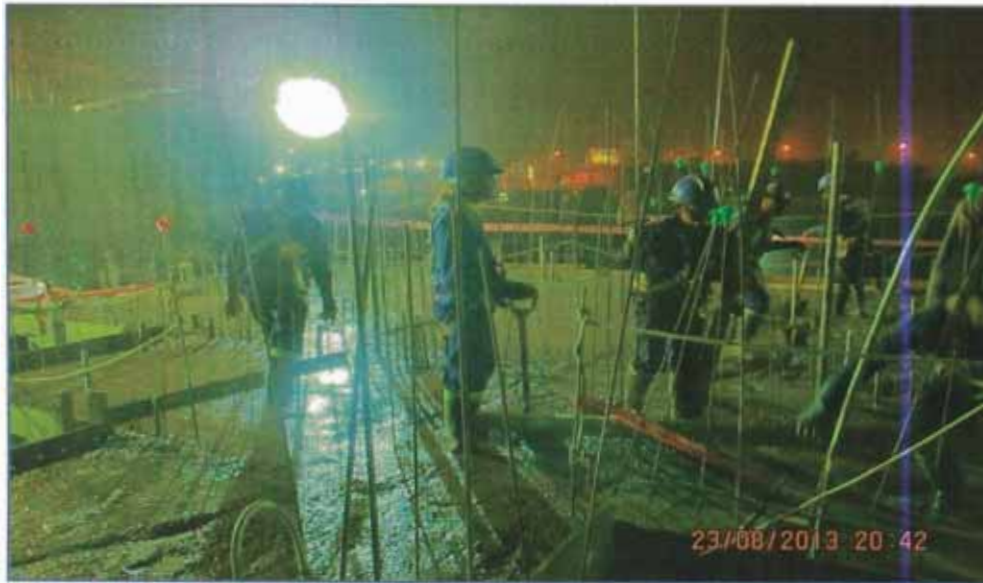
Figura N°58: Fotografía nocturna de vaciado
