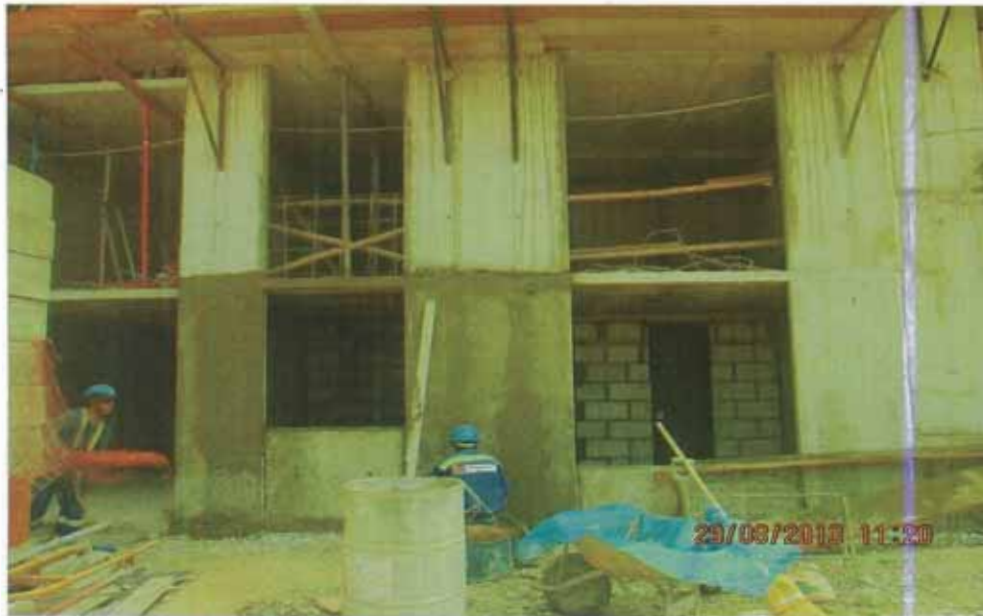
Figura N°42: Fotografía de tarrajeo en fachada
