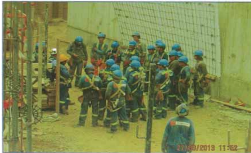
Figura N°31: Fotografía de re inducciones Fuente: JLV Consultores
