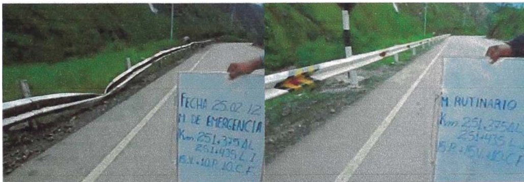
Figura 1.10. Reemplazo y repintado de Guardavías dañados.
