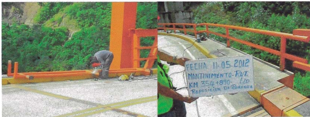
Figura 1.9. Reposición de baranda en puente otorongo.
