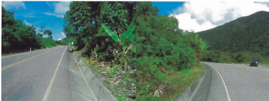
Figura 1.6. Derecho de vía, control de vegetación.
