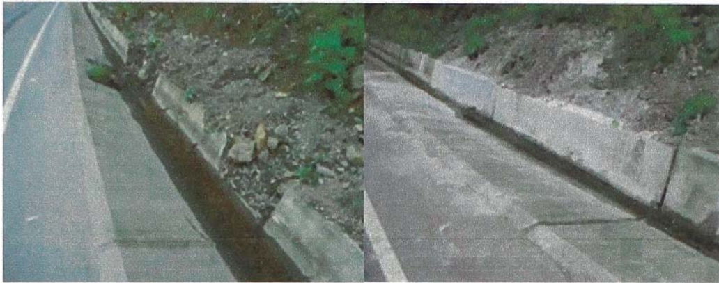
Figura 1.2. Reconstrucción de dos paños de cuneta
