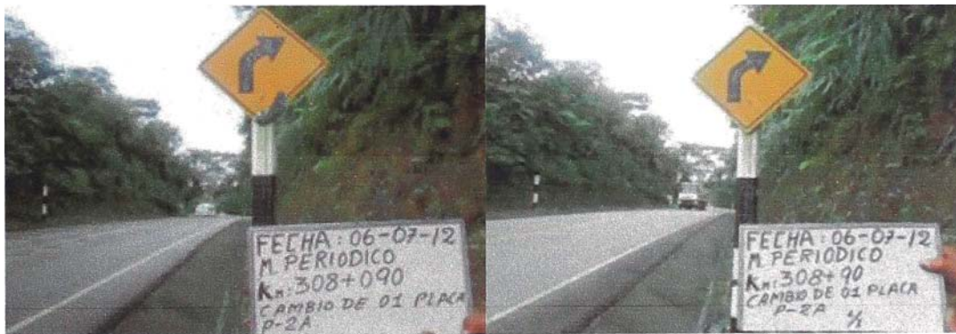
Figura 1.17. Reemplazo de señal vertical dañada.
