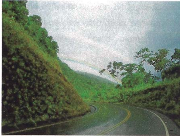
Figura 1.5. Vista del pavimento flexible en buenas condiciones.
