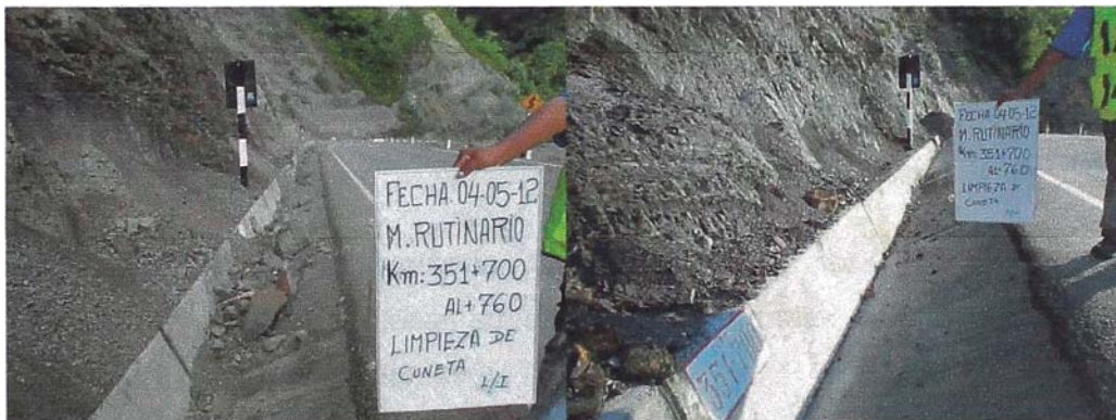
Figura 1.1. Limpieza del drenaje superficial.
