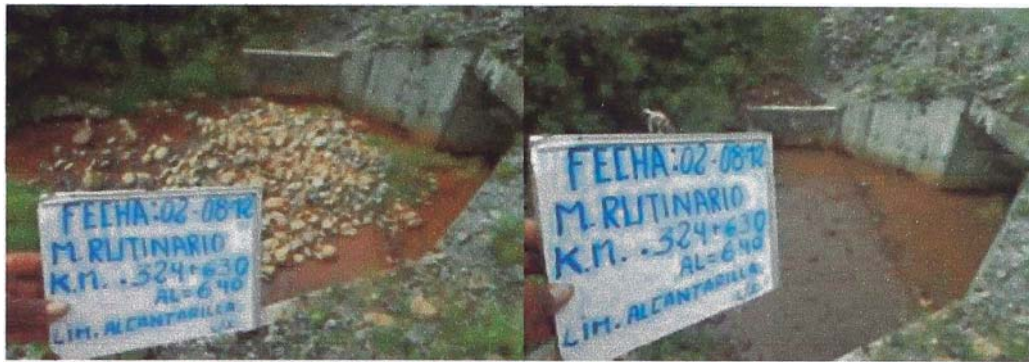
Figura 1.4. Limpieza de alcantarilla.
