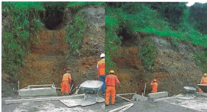
Figura 1.3. Reconstrucción de alcantarilla y aliviadero.
