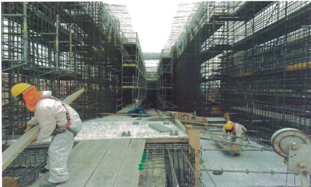
Figura N°3.12. Construcción faja 5 (Fuente Proyecto Matarani)
