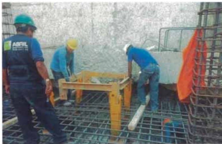
Figura N°2.2. Pie de empotramiento de la grúa torre en los cimientos de la edificación.
