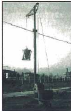
Figura N°1.1 Elevador de carga con pilote y brazo. Fuente: Tesis "Grúa Torre" Cartes Cossio Mariela.
