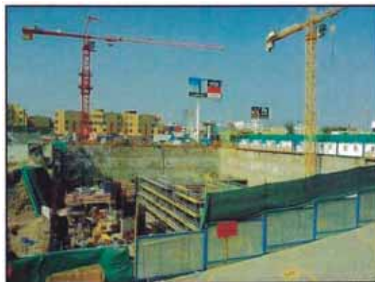
Figura N°1.5 Uso de Grúas Torre en la construcción de la Nueva sede del Banco de la Nación en el distrito de San Borja (Imagen de Junio 2014)
