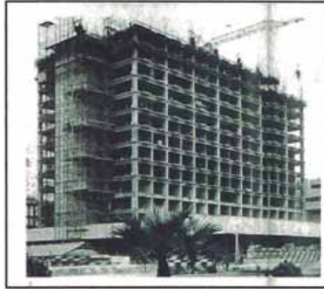
Figura. N°1.4 Uso de Grúa Torre en la Construcción del Hotel Shératon.
