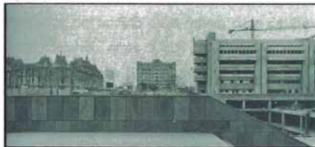
Figura N°1.3 Grúa Torre en la Construcción de la Torre del Centro Cívico vista 2.
