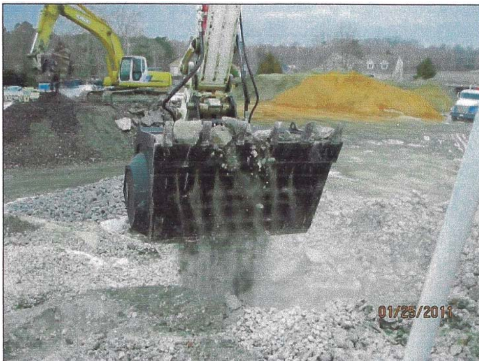
Figura N° 3.6: Proceso de chancado in-situ. Fuente: MB Crushing
