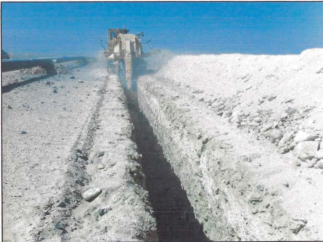
Figura N° 2.6: Fotografía de método alternativo de excavación con equipo zanjadora (Gasoducto troncal Ica-Nazca)
