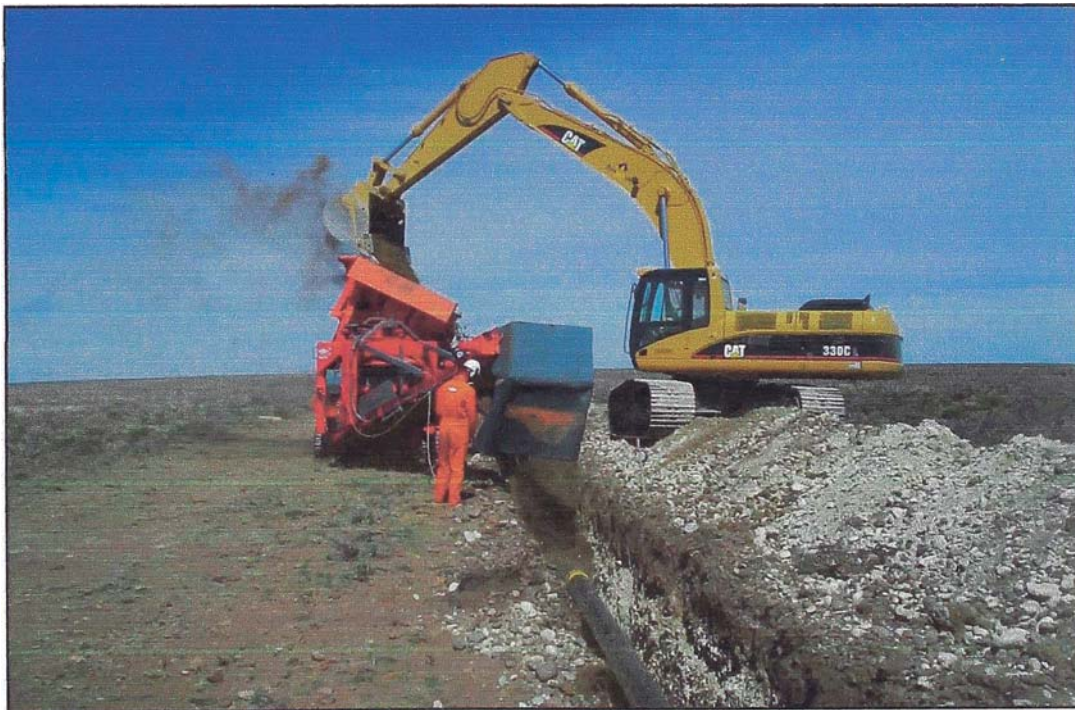
Figura N° 2.8: Método alternativo de producción de material para rellenos in-situ Fuente: Presentación página Web de equipos Terex Finlay
