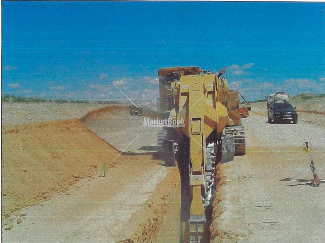
Figura N° 3.3: Equipo zanjadora tipo Trencor 1260.
