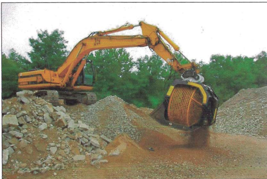
Figura N° 3.7: Proceso de zarandeo in situ.
