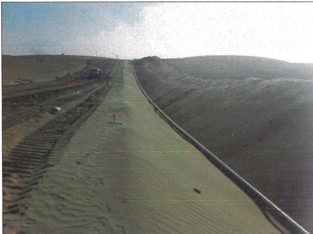
Figura N° 2.2: Fotografía de derecho de vía, plataforma de trabajo (Gaseoducto ramal Humay - Pisco)
