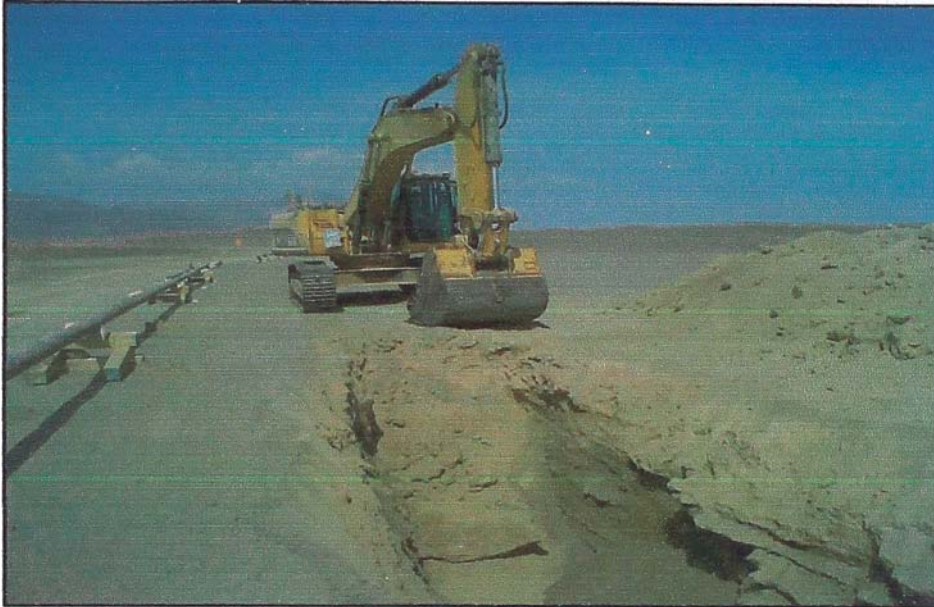
Figura N° 2.3: Fotografía de trabajos de excavación tradicional (Gaseoducto ramal Ica)
