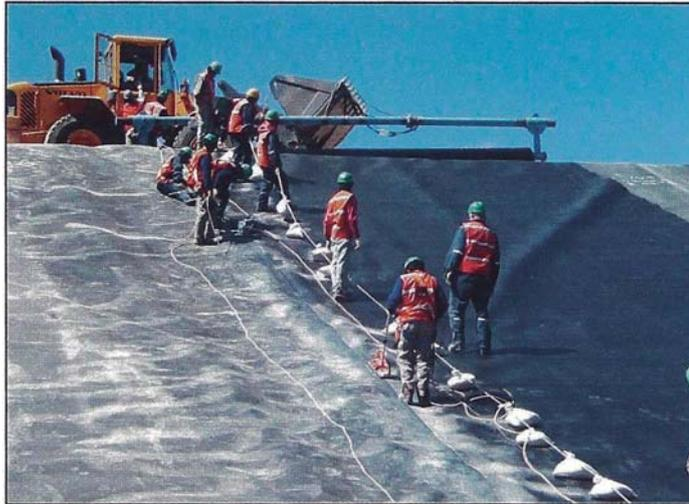
**Figura N° 54.- Sistema de revestimiento.**
