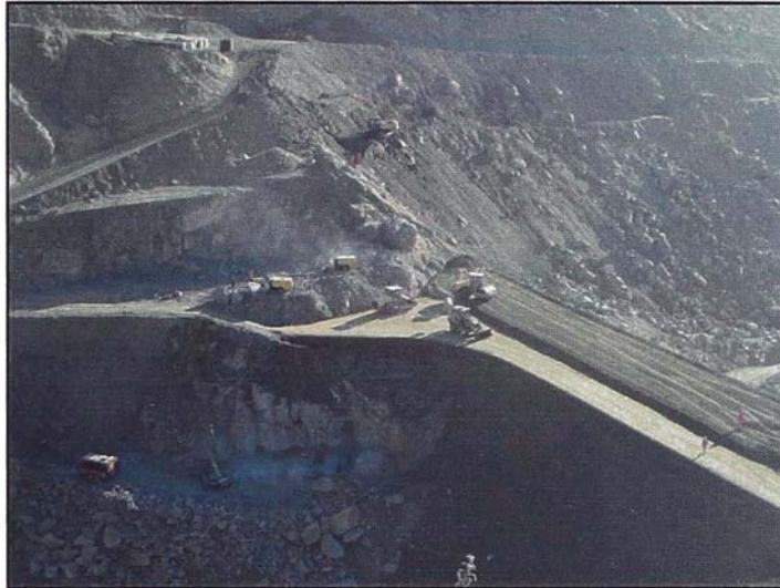
**Figura N° 52.- Material de relleno en diques.**
