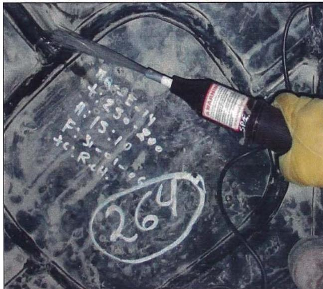
**Figura N° 60.- Sellado de la geomembrana por extrusión.**
