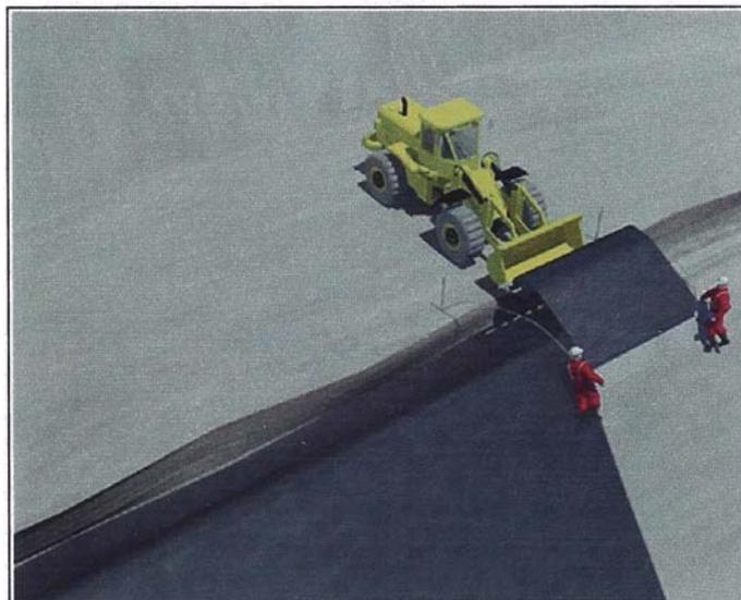
**Figura N° 58.- Colocación de los geosintéticos.**
