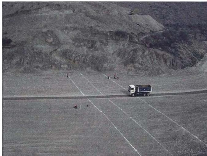
**Figura N° 47.- Trazo y replanteo**
