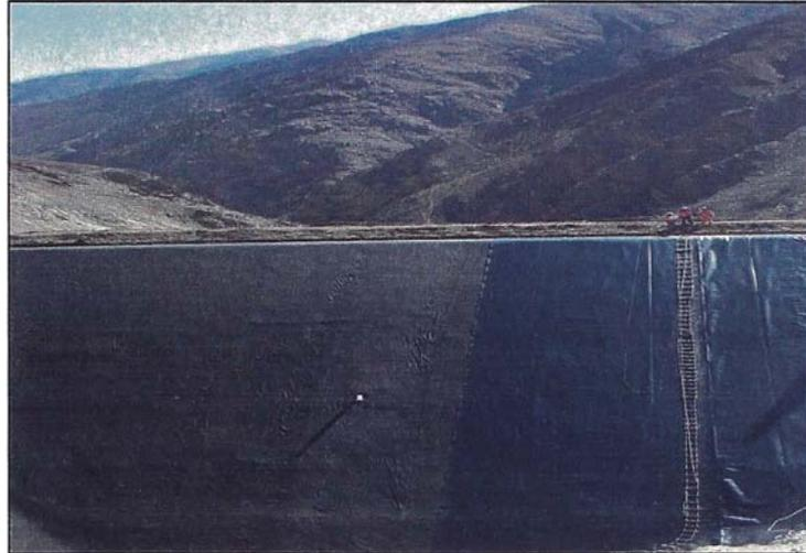
**Figura N° 55.- Revestimiento en diques.**
