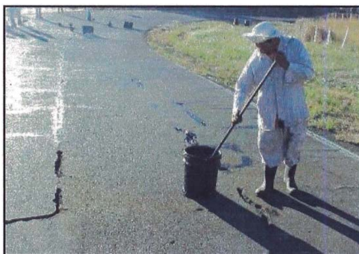
Figura 3.28 - Tratamiento de Fisuras
