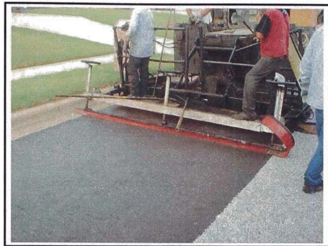
Figura 3.30 - Esparcido uniforme del mortero asfáltico
