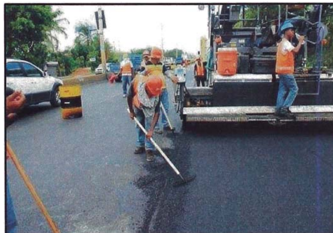
Figura 1.4 – Aplicación del Mortero asfáltico en una avenida
