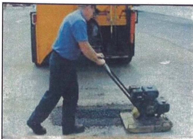
Figura 3.29 - Bacheo en frío
