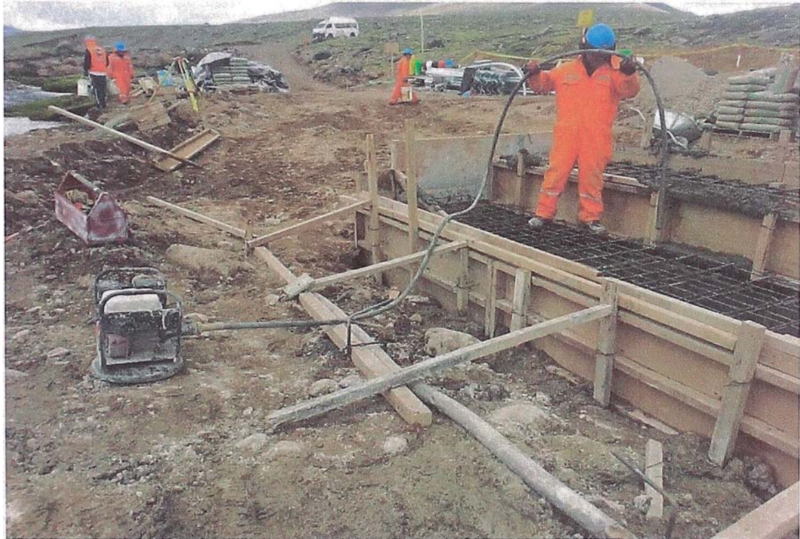
Figura N° 4.25 Vibrado del Concreto por Capas - Zapata Estructural
