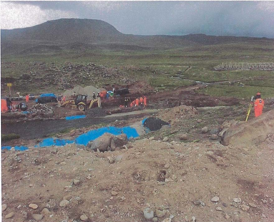
Figura N° 4.18 Seguimiento del Nivel del Vaciado - Falsa Zapata
