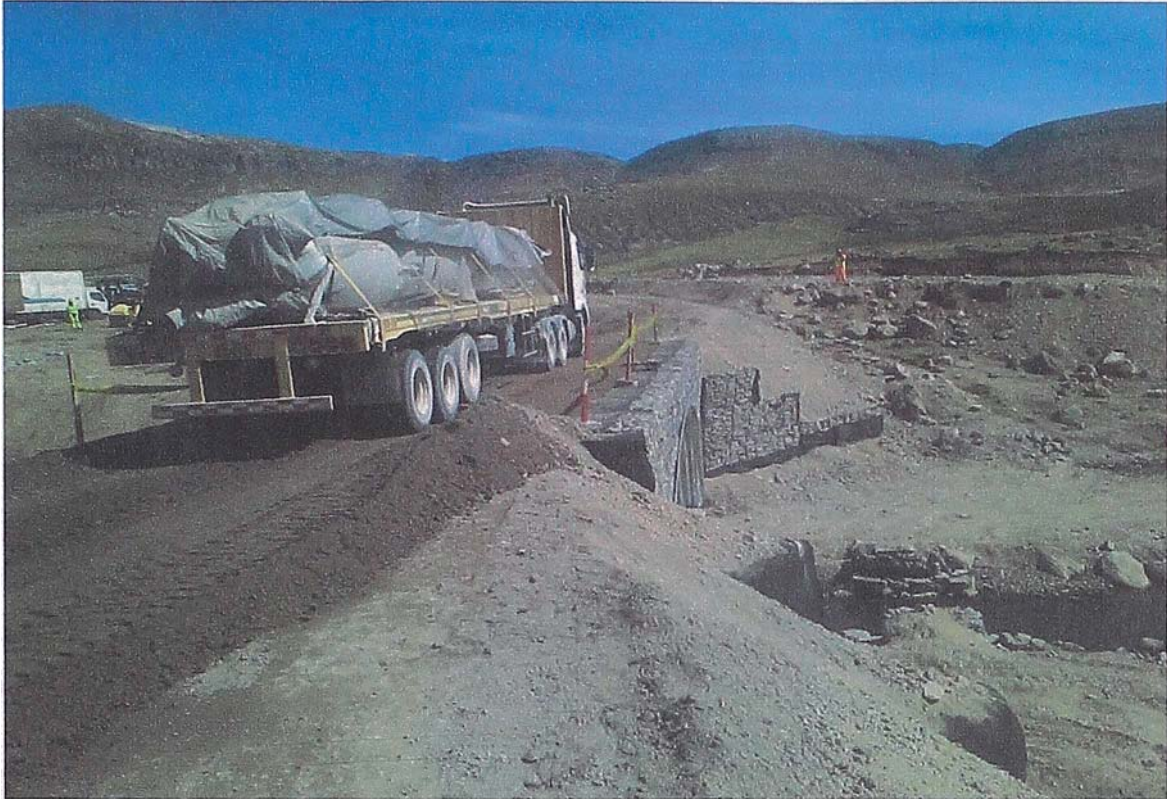
Figura N° 4.51 Prueba de Carga - Trailer Cargado N°2
