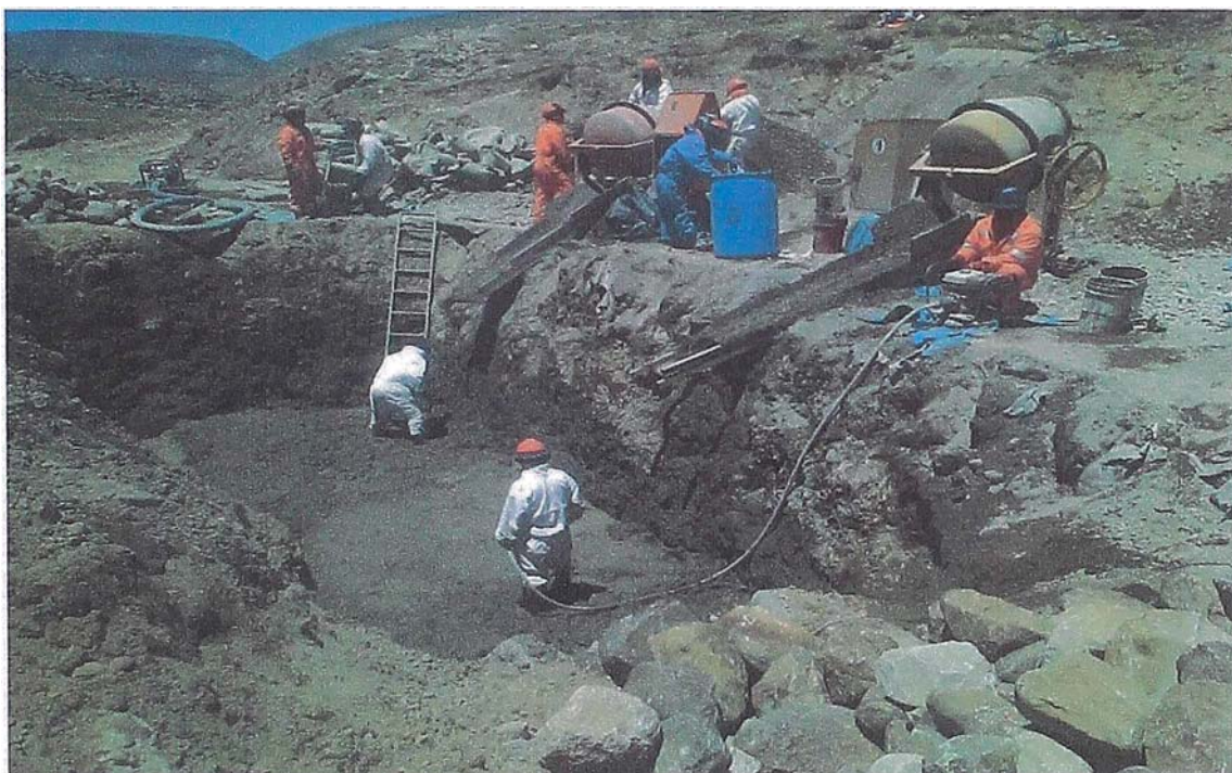
Figura N° 4.19 Vibrado de Concreto por Capas – Falsa Zapata
