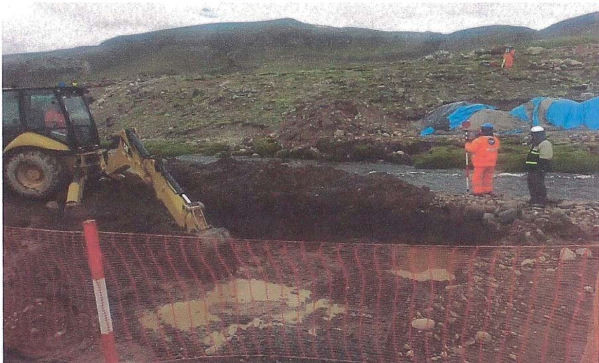
Figura N° 4.14 Excavación de Zanja – Presencia de nivel Freático
