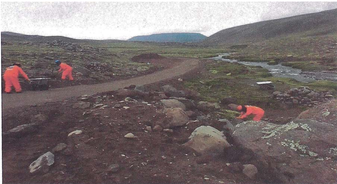
Figura N° 4.11 Acarreo de Piedras - Falza Zapata
