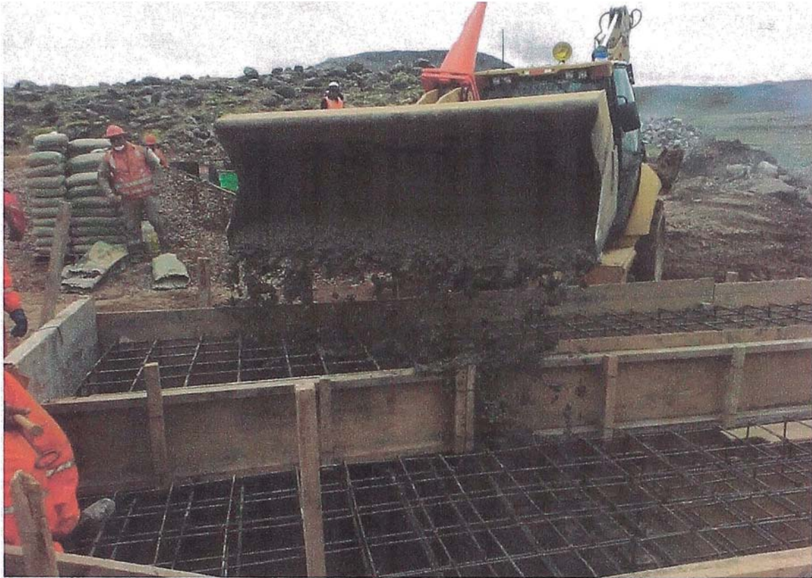
Figura N° 4.24 Vaciado de Concreto Con Retroexcavadora 420F – Zapata Estructural
