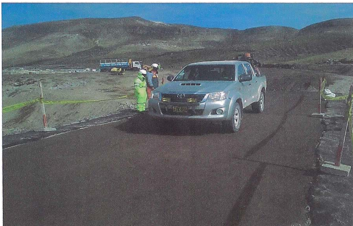
Figura N° 4.48 Prueba de Carga - Camioneta
