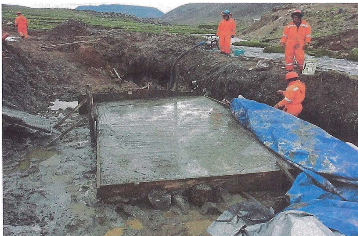
Figura N° 4.21 Nivel final del Vaciado - Falsa Zapata
