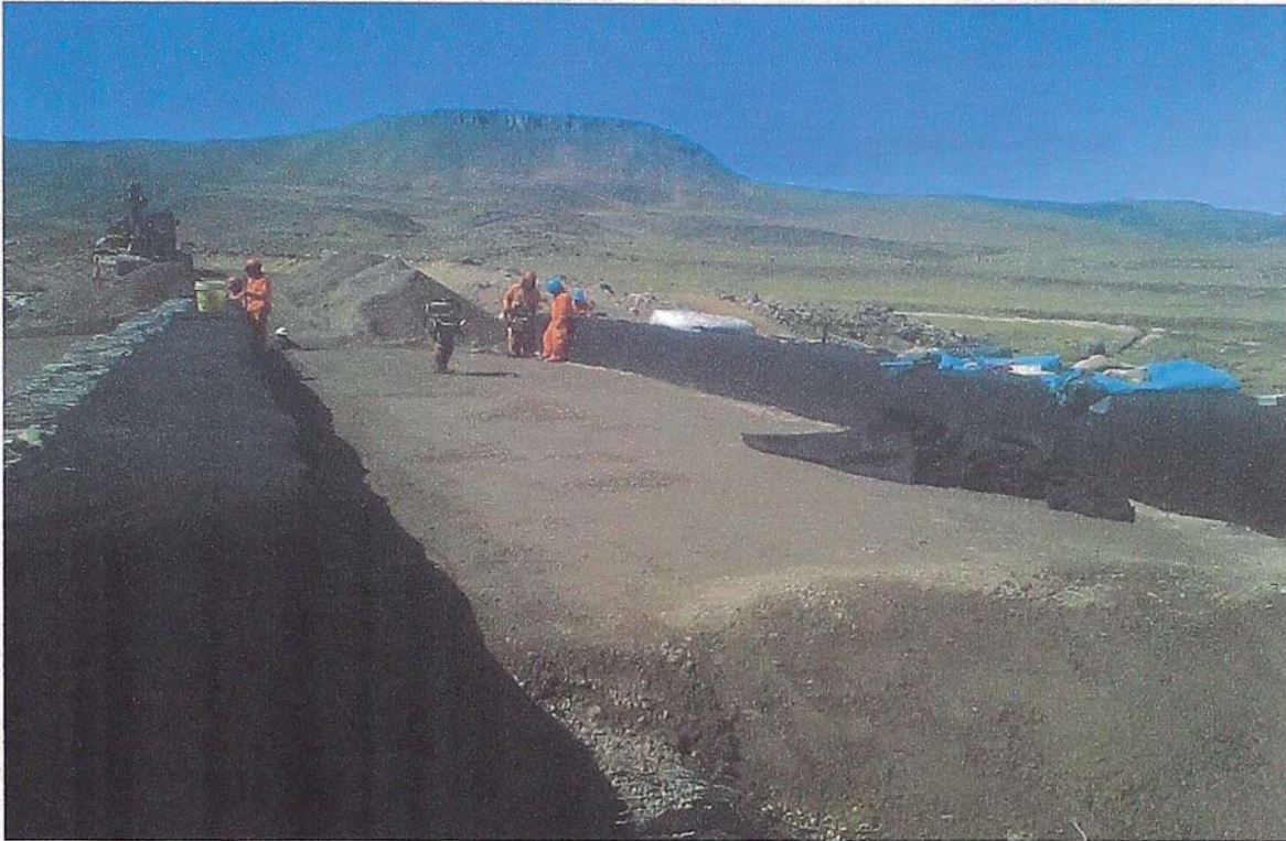
Figura N° 4.46 Compactación Manual por Capas en Eje del Puente
