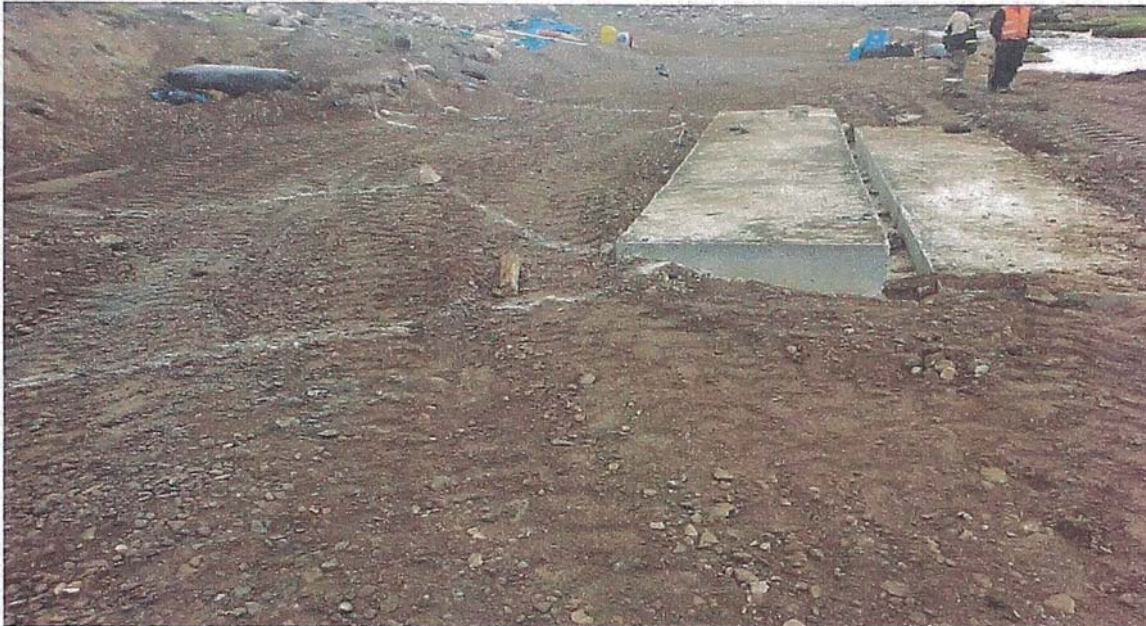
Figura N° 4.27 Desencofrado de Zapata Estructural - Nivelación y Trazado de Muros de Encausamiento
