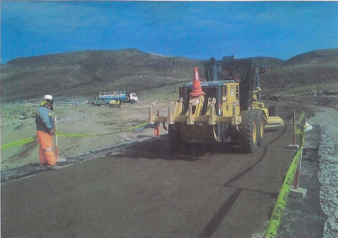
Figura N° 4.49 Prueba de Carga – Retroexcavadora
