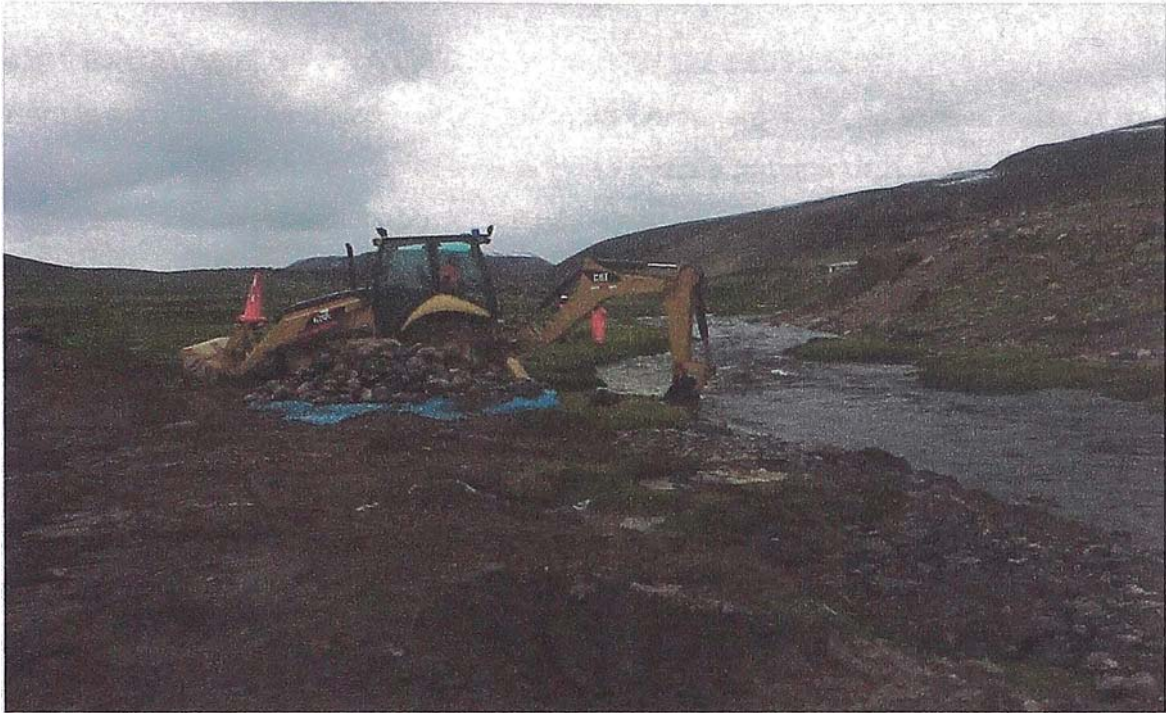
Figura N° 4.12 Acarreo de Piedras en el Rio - Falsa Zapata
