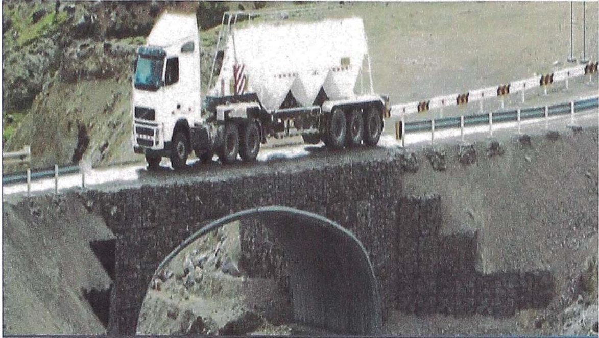
Figura N° 4.53 Prueba de Carga - Camión Cisterna Cargado
