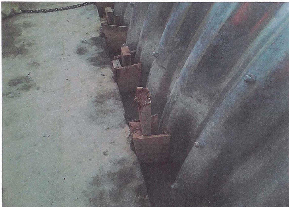
Figura N° 4.36 Vaciado del Grout en los Estribos para Fijación de la Superestructura
