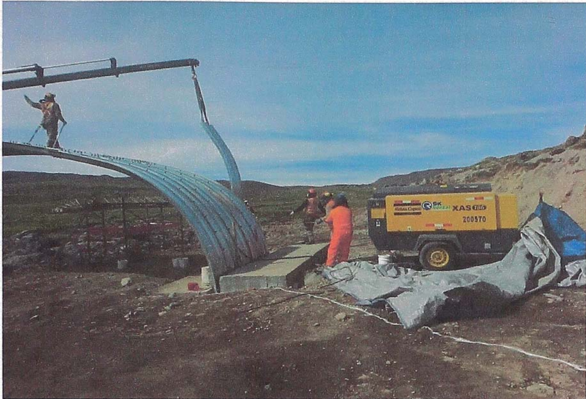
Figura N° 4.31 Ubicación de Placas al eje del Puente
