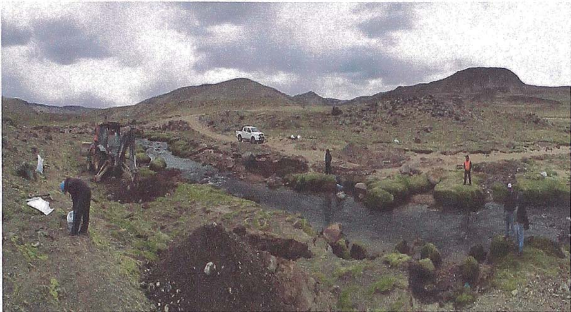
Figura N° 4.7 Vista panorámica de Ubicación de Calicatas
