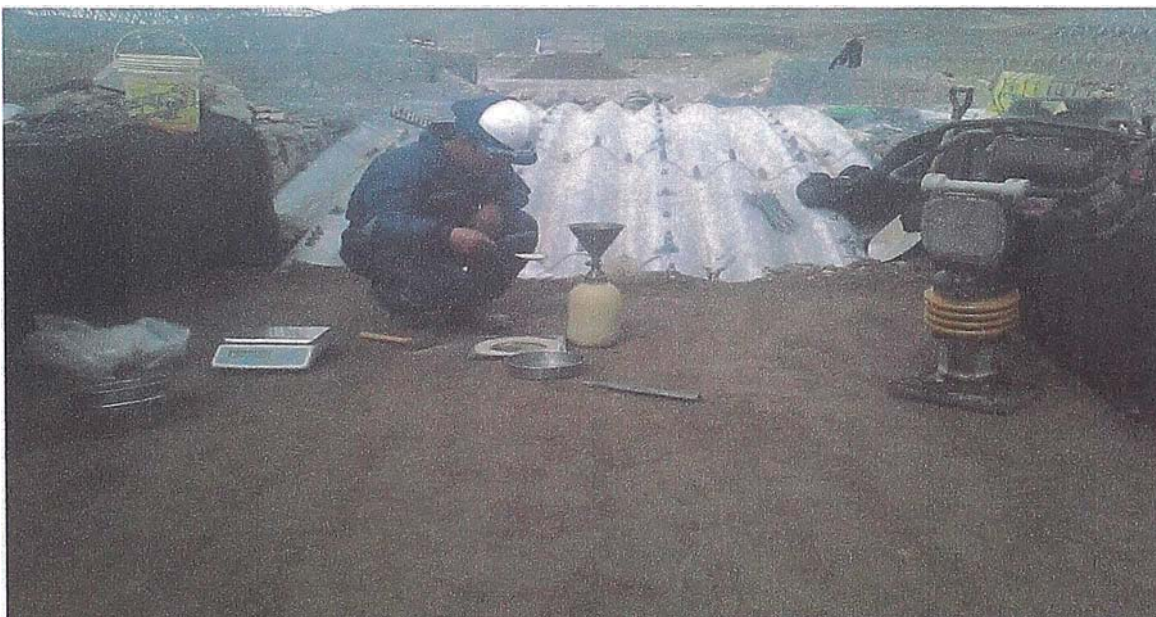
Figura N° 4.45 Ensayo Proctor Modificado
