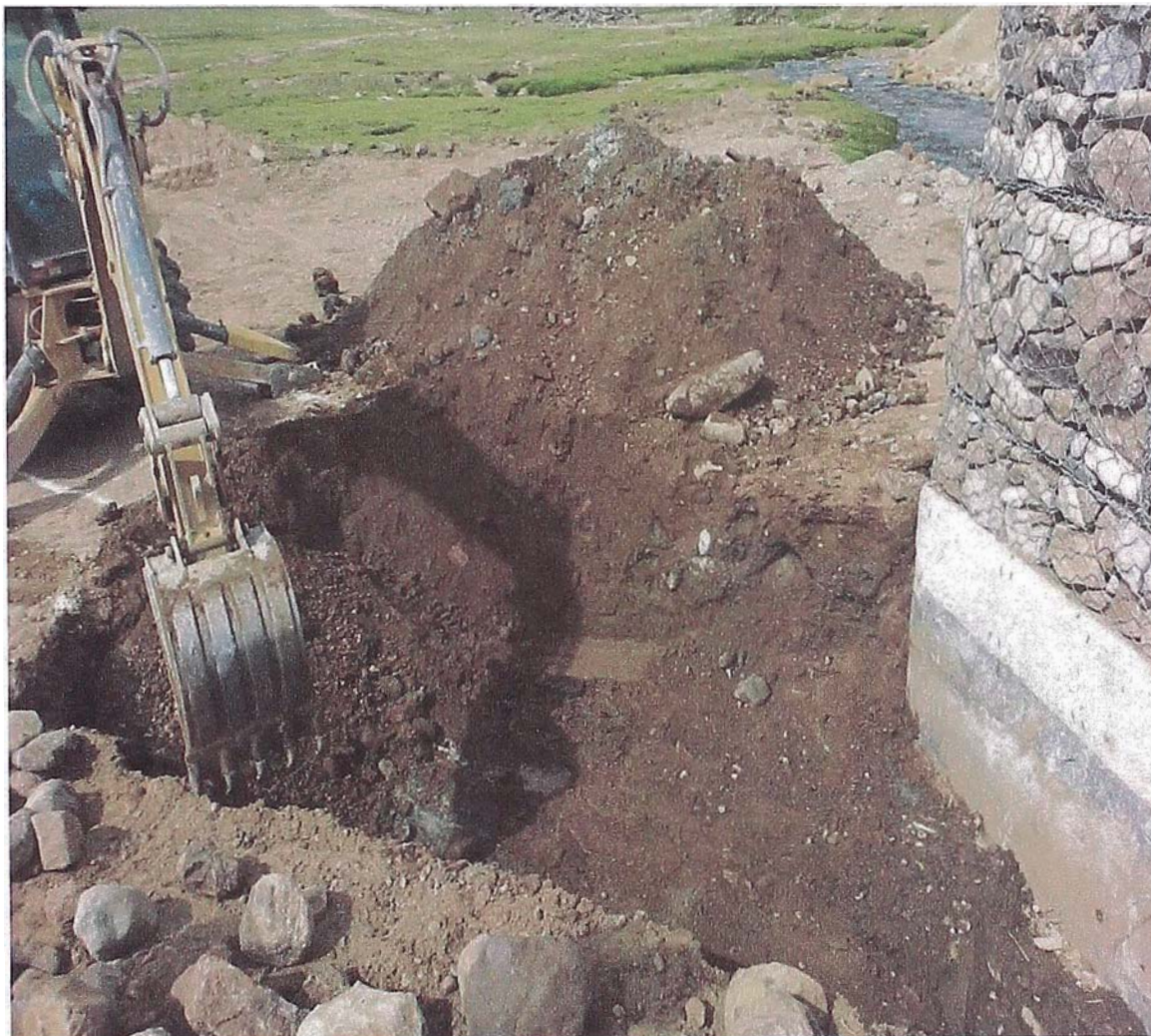
Figura N° 4.37 Excavación de Ubicación de Muros de Encausamiento
