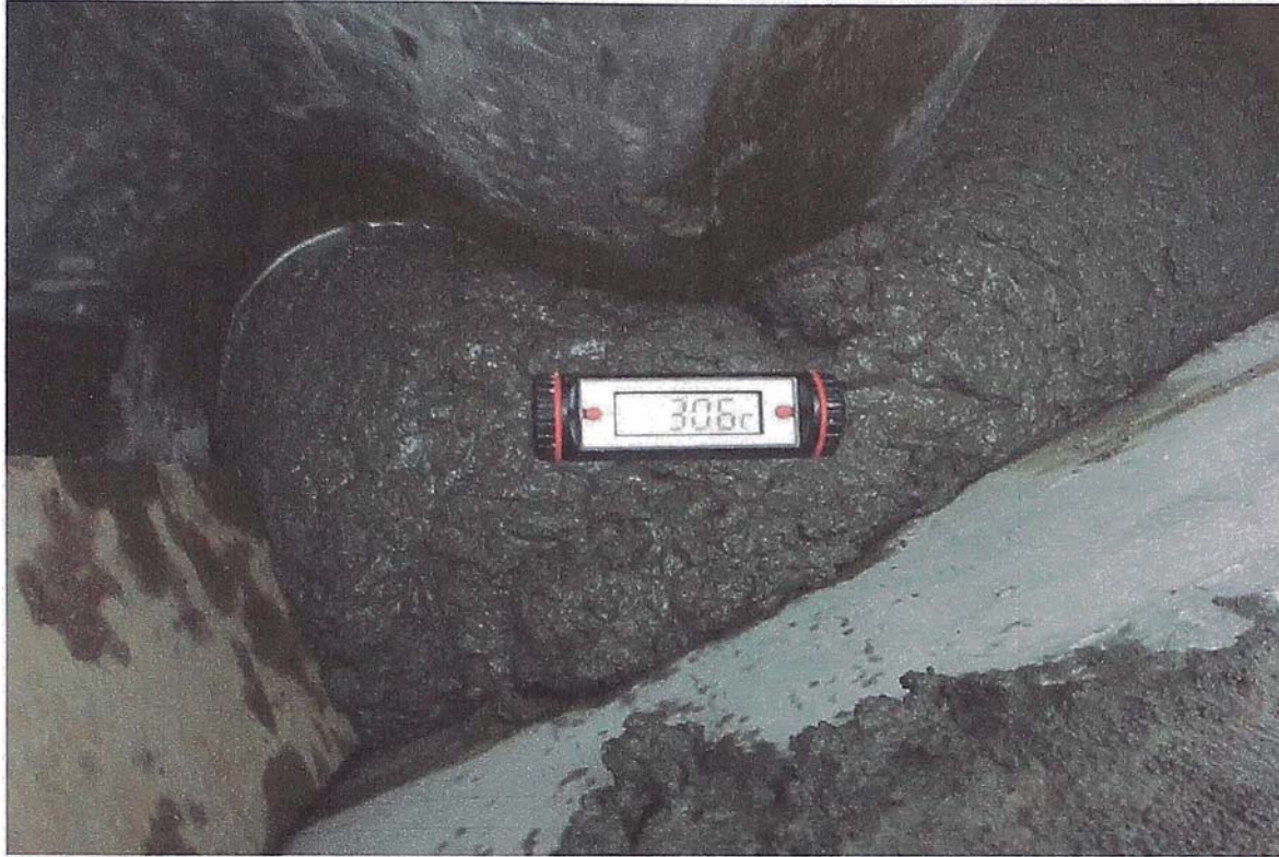
Figura N° 4.35 Verificación de Temperatura del Grout
