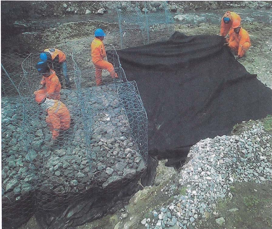
Figura N° 4.40 Colocación de Geotextil No tejido debajo del Muro de Encausamiento
