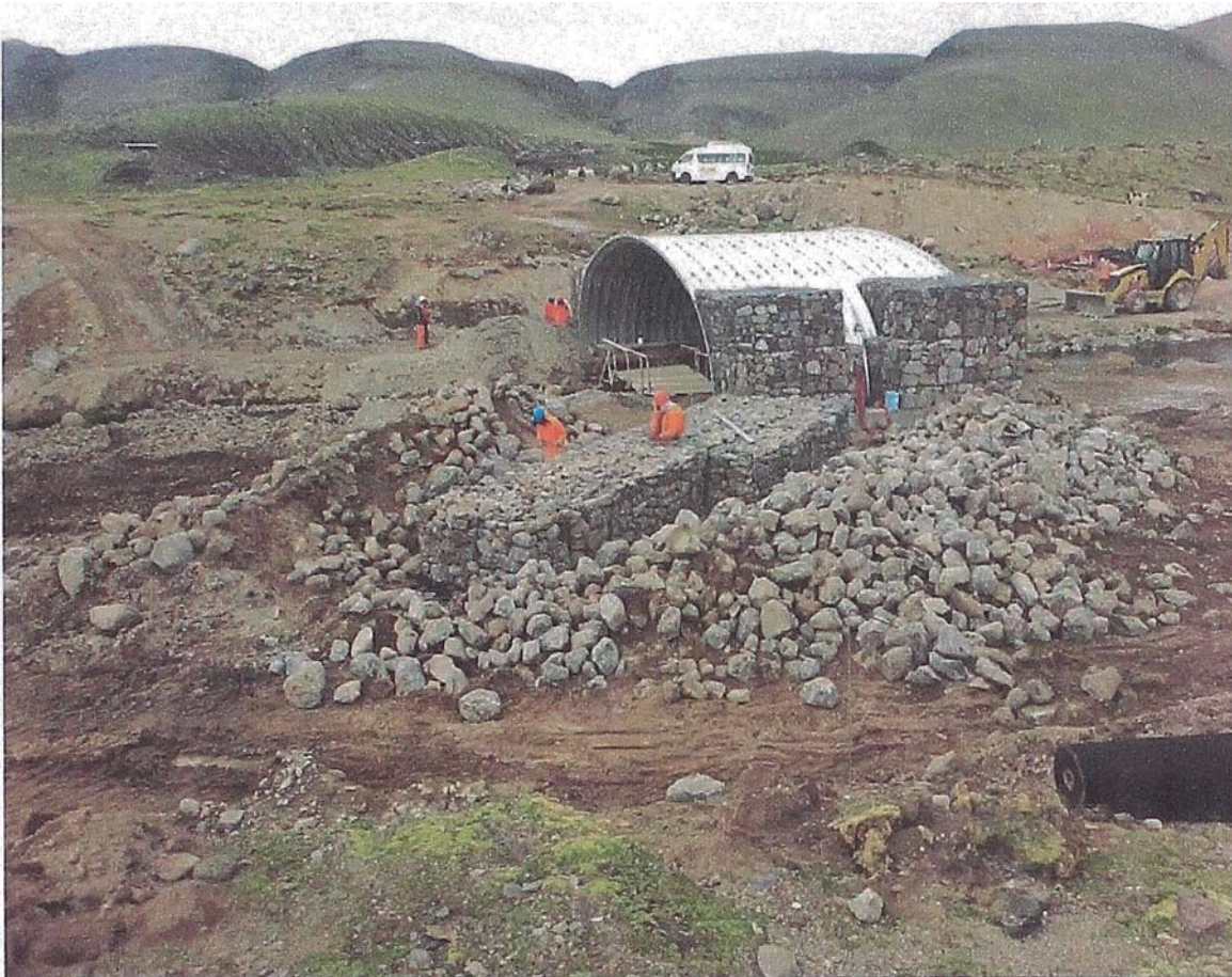
Figura N° 4.41 Rellenado de Piedra - Muro de Encausamiento
