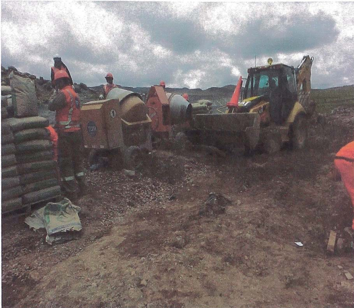
Figura N° 4.23 Distribución de Agregados, Materiales y Equipos - Vaciado del Concreto Zapata
