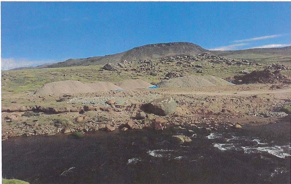
Figura N° 4.13 Agregados en los Estribos del Puente
