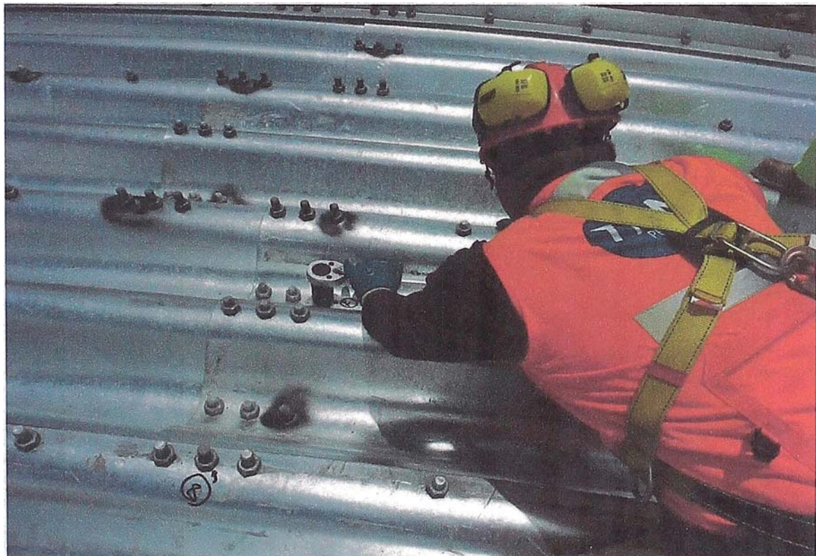
Figura N° 4.32 Unión de Placas con Torquimetro Sobre la Superestructura
