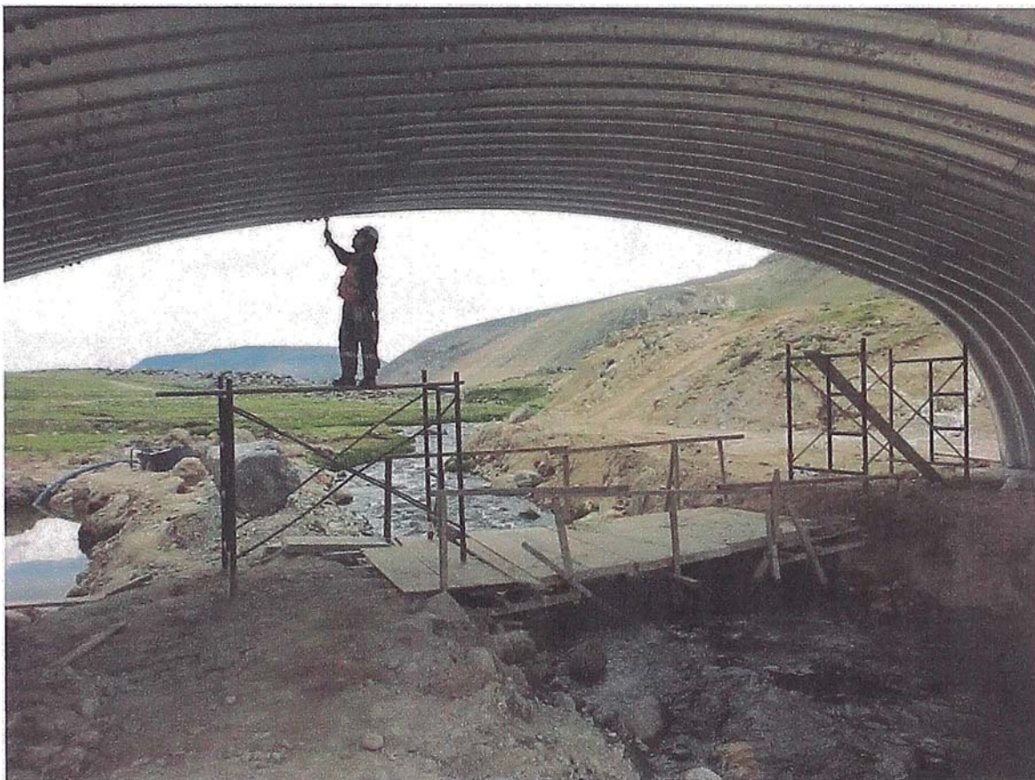
Figura N° 4.33 Unión de Placas con Torquimetro debajo de la Superestructura
