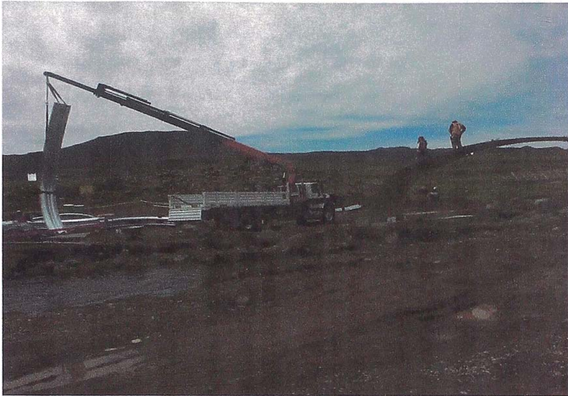
Figura N° 4.30 Izaje de Placa Estructural
