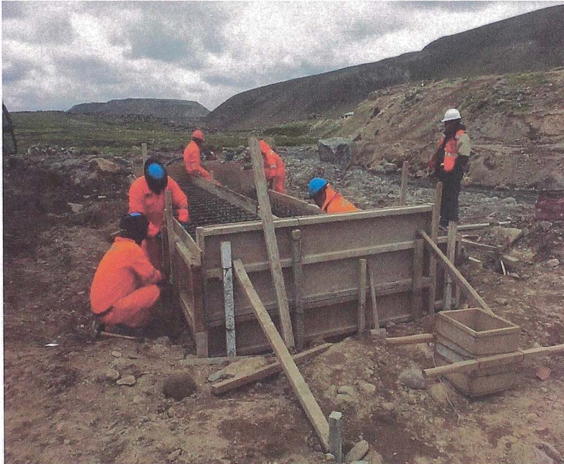
Figura N° 4.22 Encofrado de Zapata en los Estribos
