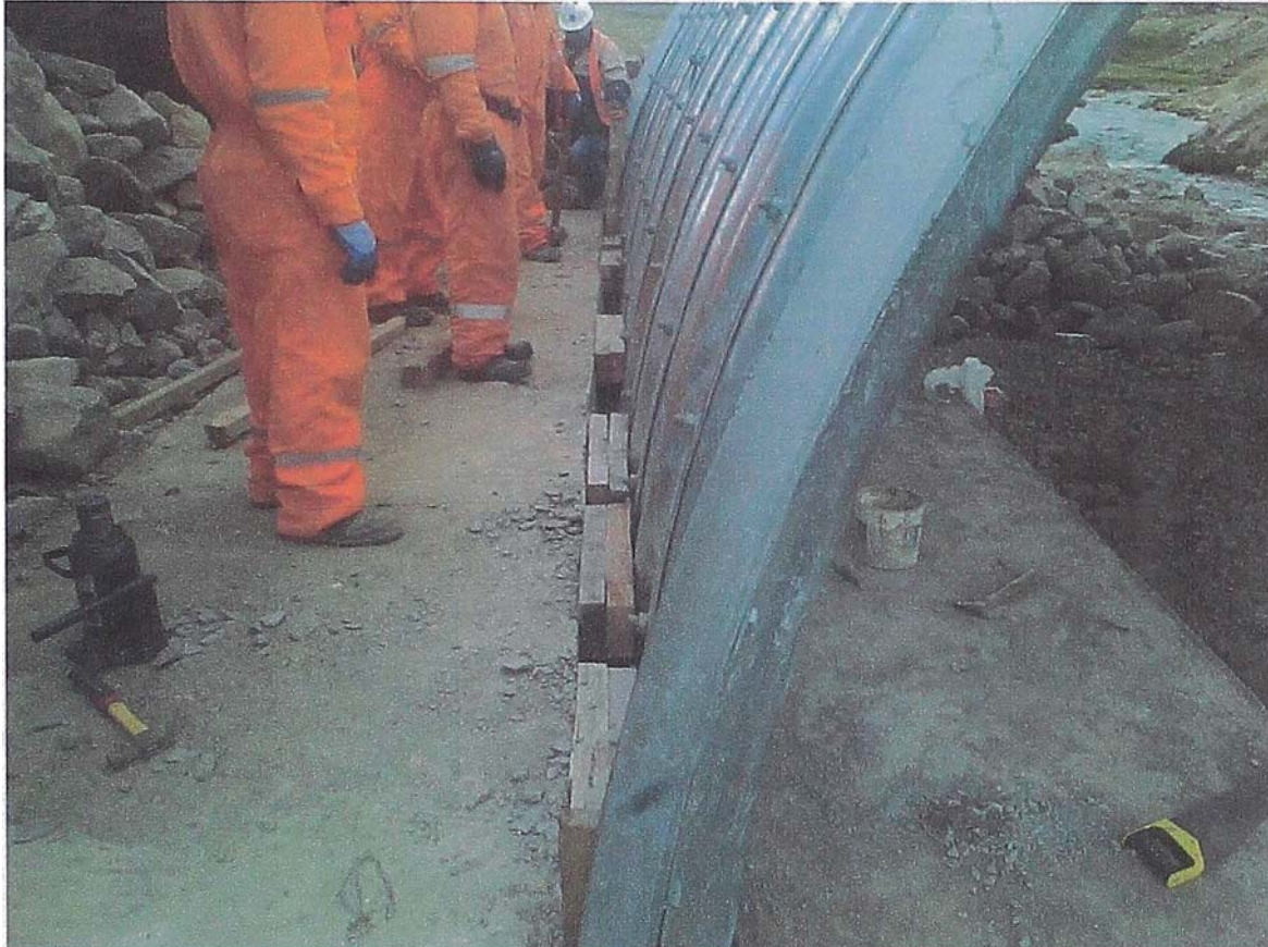
Figura N° 4.34 Fijación de Placa Estructural con Listones de Madera
