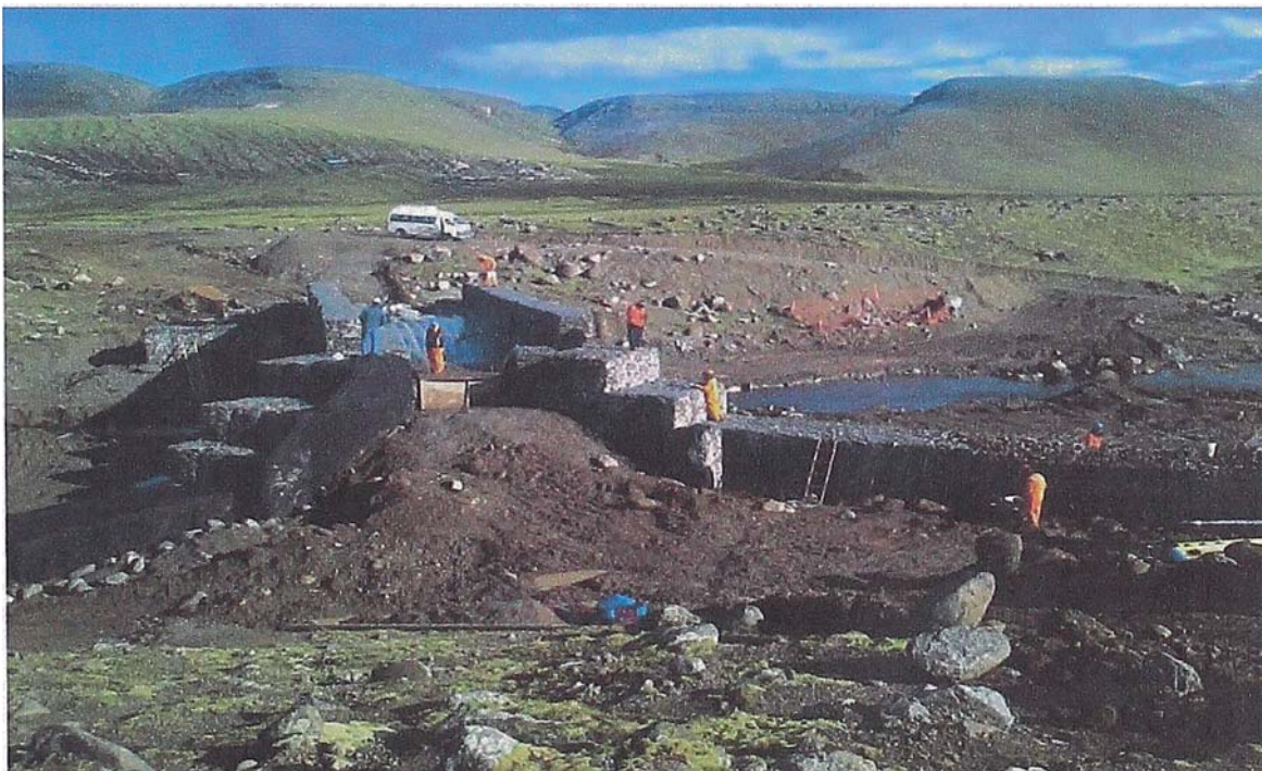
Figura N° 4.43 Rellenado de Piedra - Sistema Terramesh en el eje del Puente
