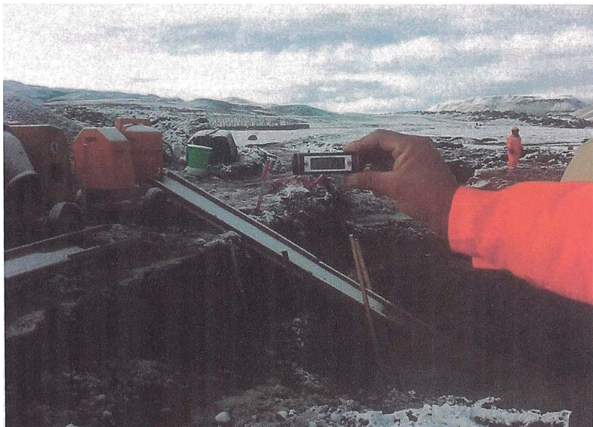
Figura N° 4.16 Mal tiempo para el Vaciado del Concreto - Temperatura menor a 5 °C
