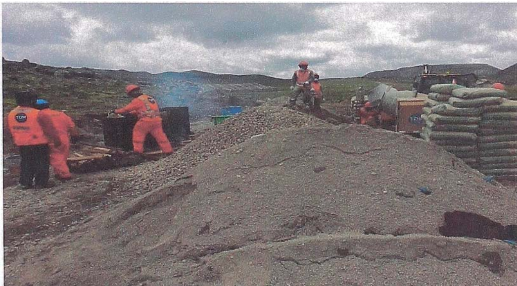
Figura N° 4.17 Distribución de Agregados, Materiales y Equipos - Vaciado del Concreto Falsa Zapata
