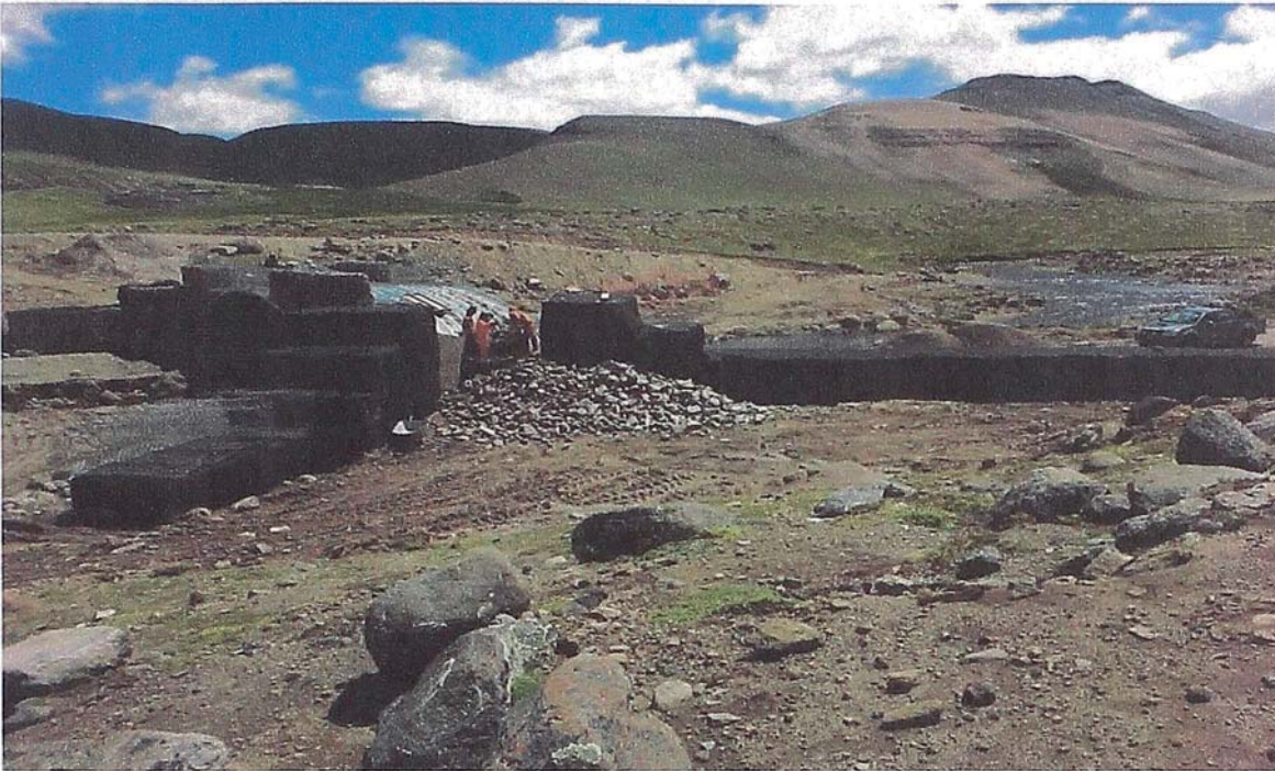
Figura N° 4.42 Traslado de Piedra de Sistema Terramesh
