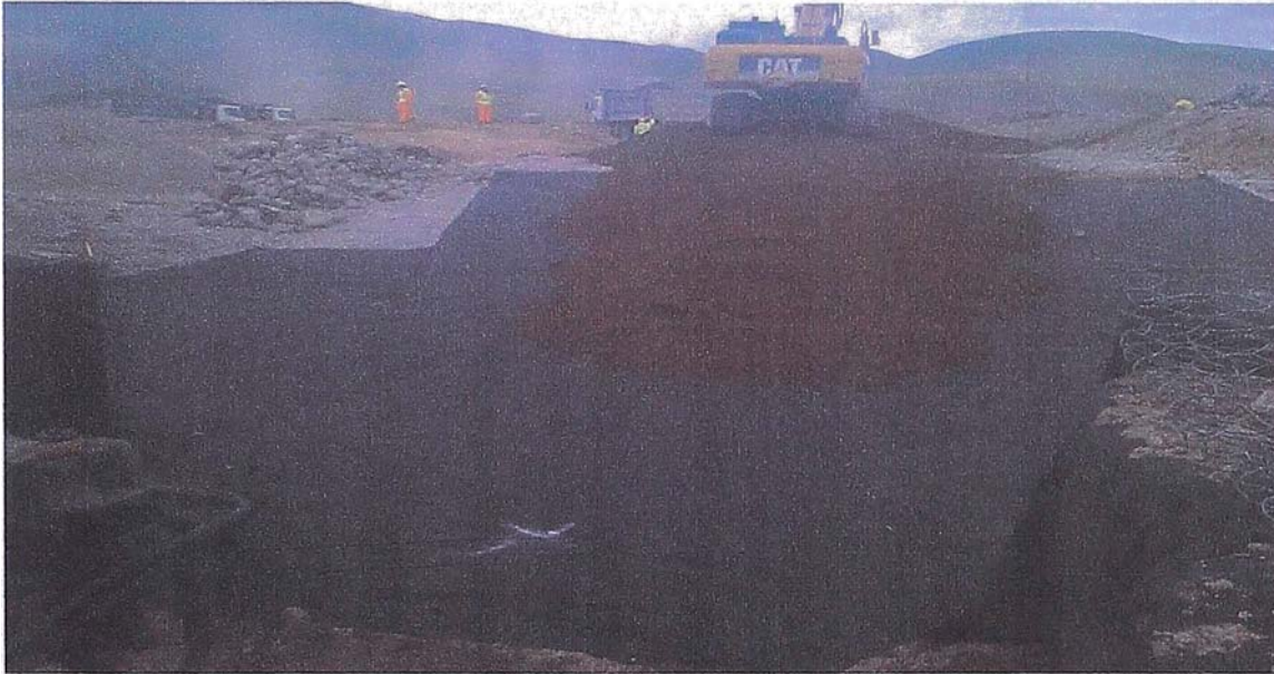
Figura N° 4.44 Relleno de Afirmado sobre Geotextil No Tejido
