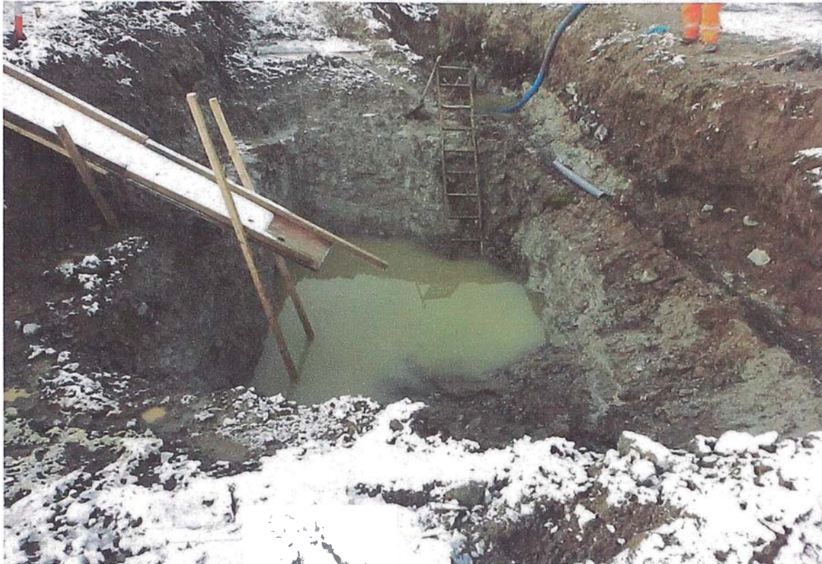
Figura N° 4.15 Nivel de Excavación de Falsa Zapata
