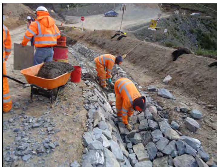
Fotografía N° 2 – Construcción del canal de derivación
