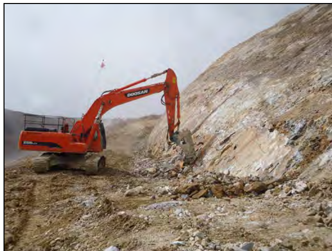
Fotografía N° 17 – Corte de talud con ayuda de picotón
