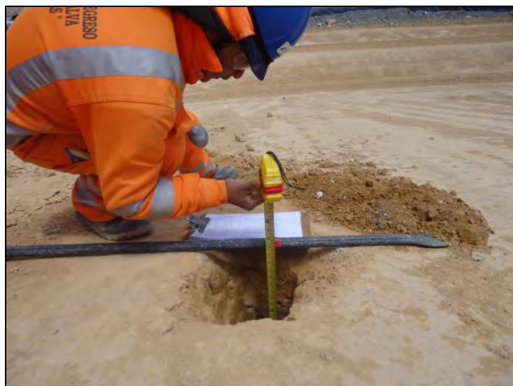
Fotografía N° 12 – Medición de espesor de arcilla e=30\text{cm}
