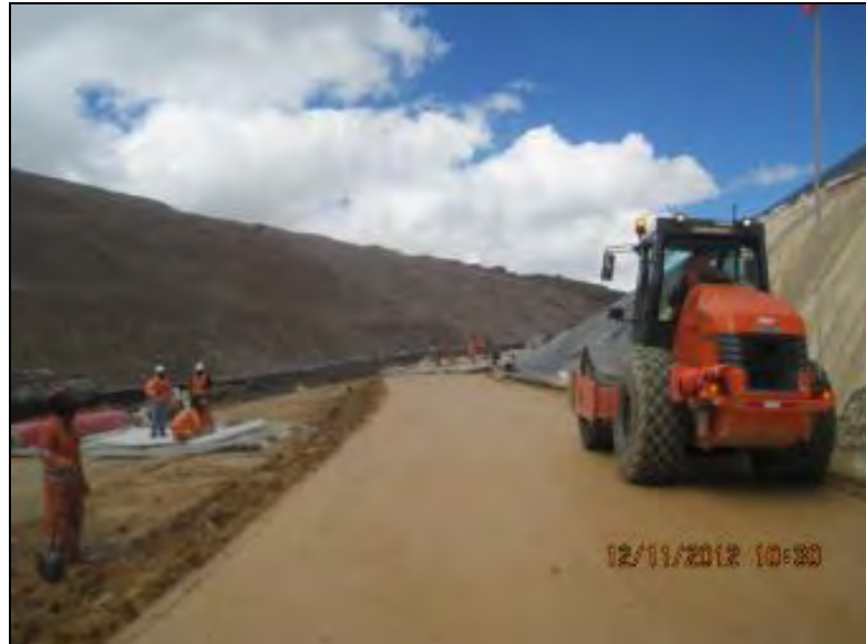
Fotografía N° 14 - Compactación de arcilla en taludes horizontales
