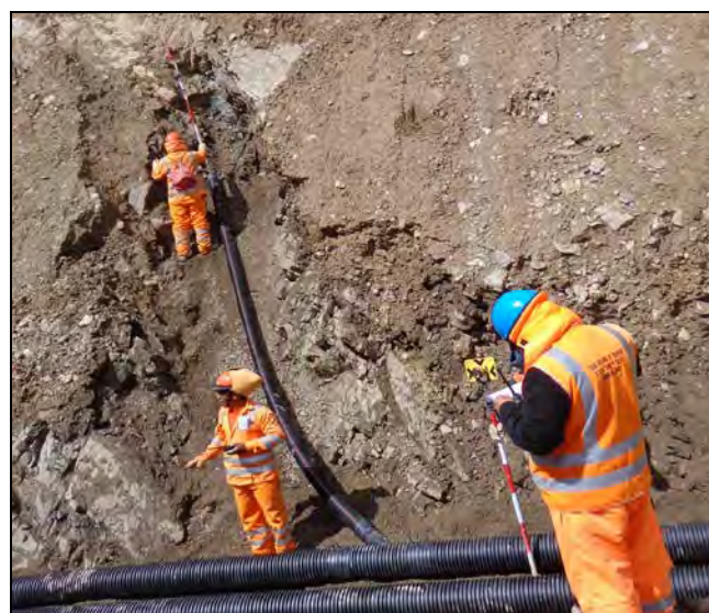
Fotografía N° 26 – Imagen de colocación de tubería de 100mm
