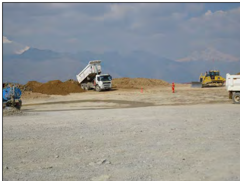
Fotografía N° 1 – Volquete descargando material en botadero
