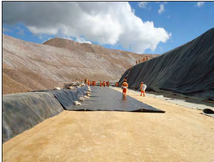
Fotografía N° 13 - Superficie de arcilla compactada
