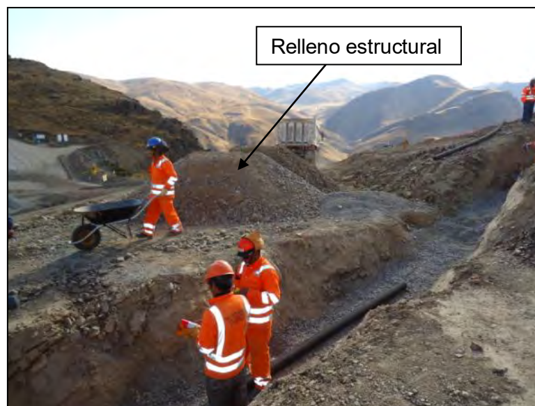
Fotografía N° 6. – Acumulación de relleno estructural
