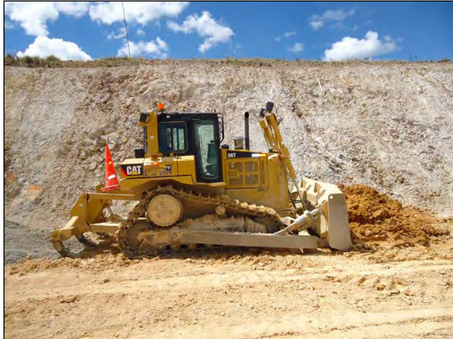
Fotografía N° 9- Conformación de suelo de baja permeabilidad
