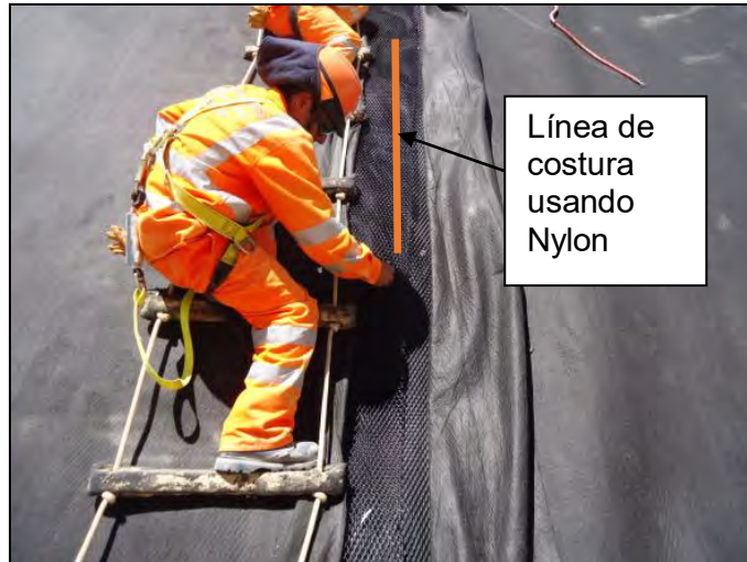
Fotografía N° 18 - Costura de geocompuesto
