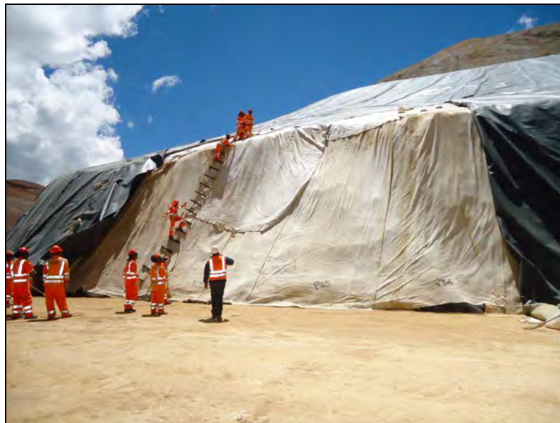
Fotografía N° 19 - Colocación de GCL en talud empinado
