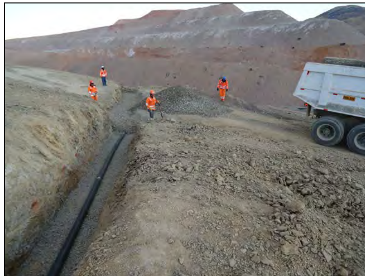
Fotografía N° 3: Relleno de zanja con grava de 1/2 pulgada
