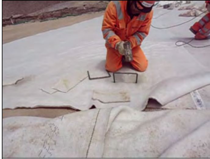
Fotografía N° 20 - Colocación de grapas de acero corrugado de 1/2 pulgada
