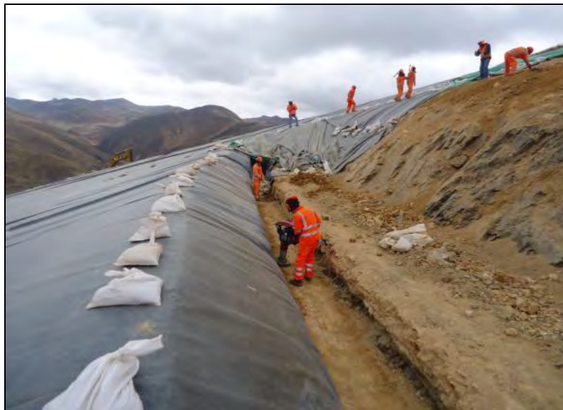
Fotografía N° 23 - Compactación de zanja para trinchera de anclaje
