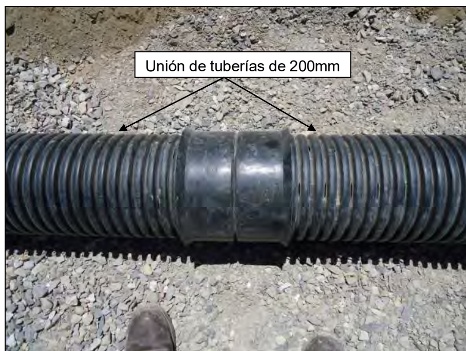
Fotografía N° 8 - Unión típica de tuberías perforadas de HDPE D=200mm (Ver plano 200-03 y 200-10, en Anexo D)
