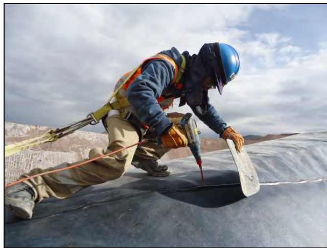
Fotografía N° 22 – Prueba de descarga disruptiva en parches
