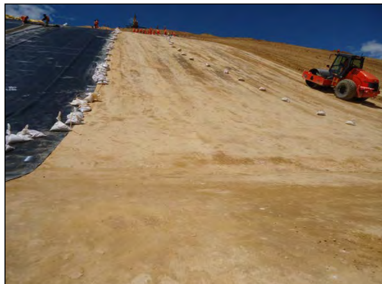
Fotografía N° 15 - Compactación de arcilla en taludes inclinados
