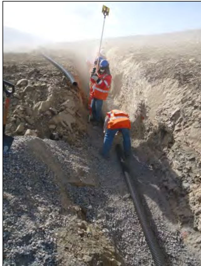
Fotografía N° 5 – Levantamiento toográfico de la instalación de tuberías
