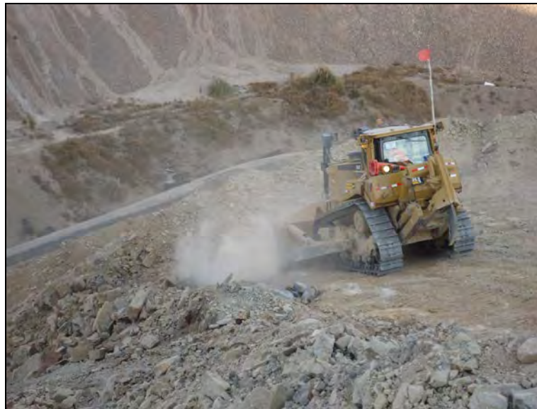
Fotografía N° 24 – Excavación y desquincho del terreno natural
