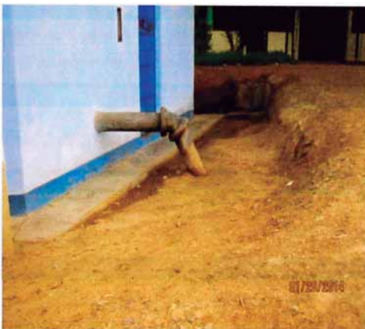
Foto: 1.3.- Tubería de impulsión que va a reservorio N° 1
