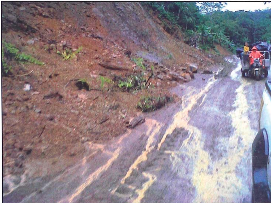
FIGURA N° 2.06.-Derrumbes en la carretera.
