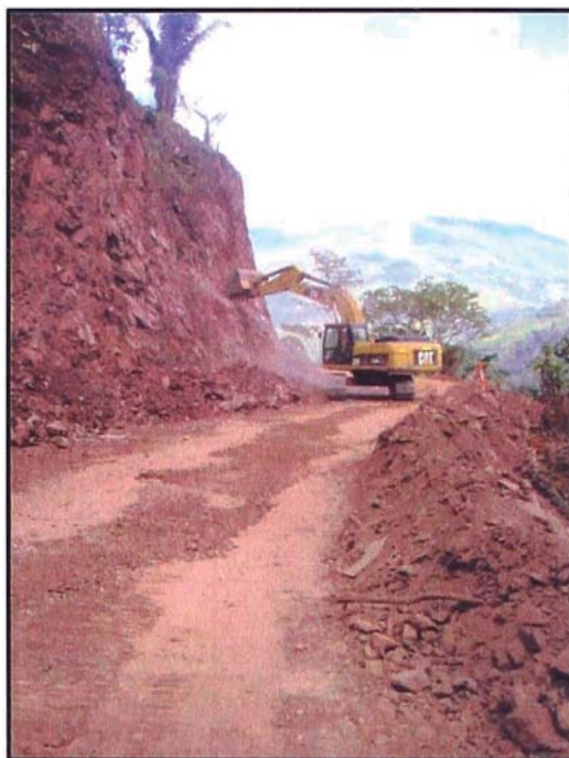
Figura N° 3.03.- Excavadora perfilando talud.
