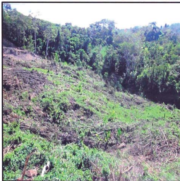
FIGURA Nº 2.08.- Terreno desbrozado para un DME.
