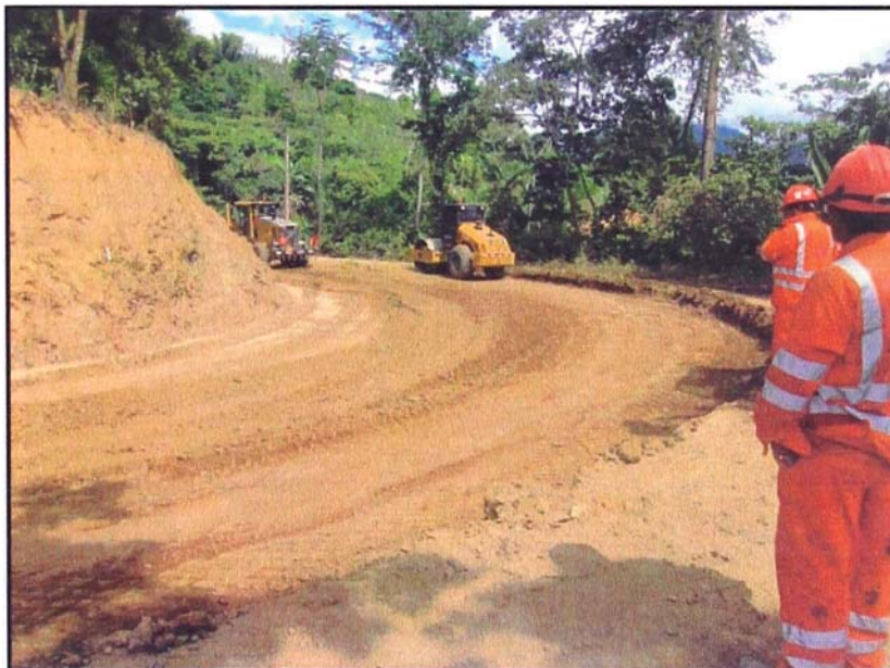
Figura N° 3.05.- Trabajos de mantenimiento con Motoniveladora y Rodillo liso.
