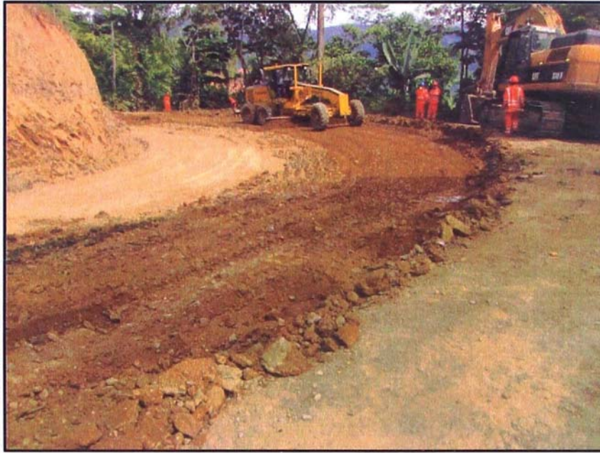
Figura N° 3.04.- Trabajos de mantenimiento con Motoniveladora.
