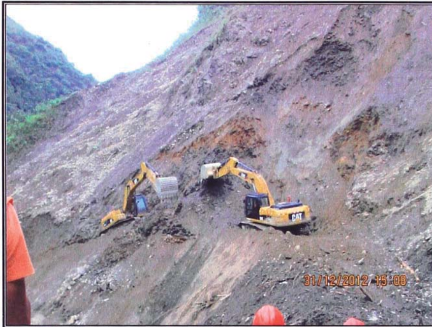
Figura N° 3.07.- Excavadoras aperturando una vía afectada por un derrumbe.
