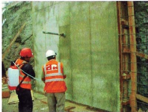
Figura N°1.10.- Procesos de curado con químicos
