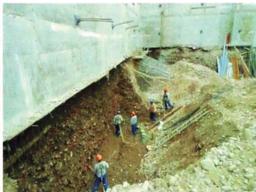
Figura N° 1.4.- Etapa de perfilado
