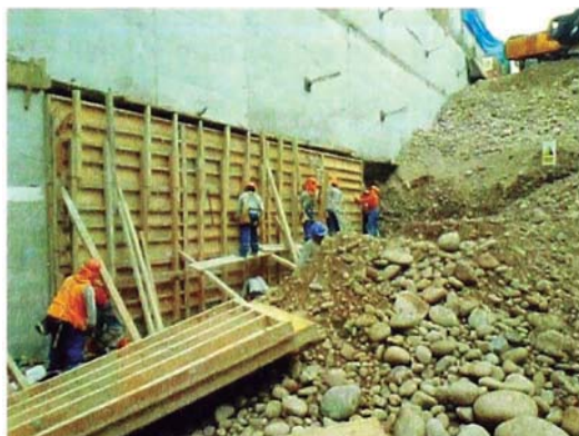
Figura N°1.7.- Procesos del encofrado del muro anclado
