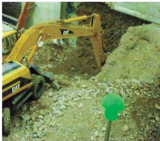
Figura N° 1.3.- Excavación de banqueta o excavación localizada
