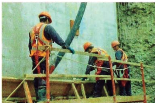
Figura N°1.9.- Vaciado del Concreto con Bomba "TK"
