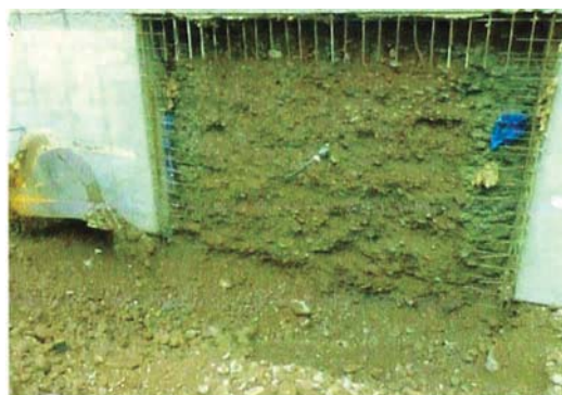
Figura N° 1.5.- Excavación de zanja para la colocación de empalmes
