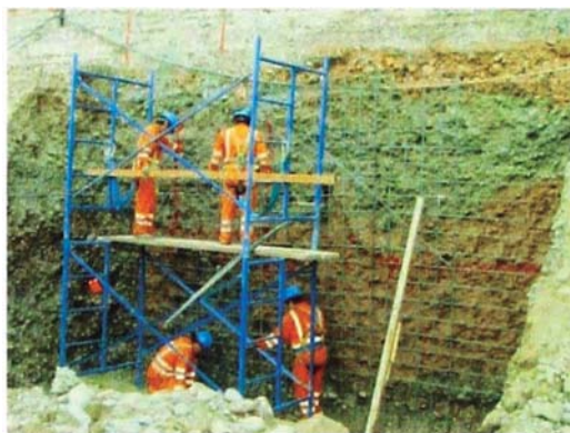
Figura N°1.6.- Colocación de acero y malla de refuerzo para el anclaje
