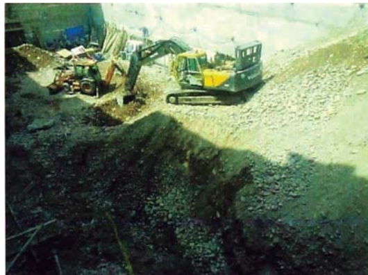
Figura N° 1.1.- Excavación masiva con Equipos
