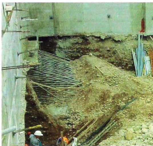
Figura N°1.8.- Colocación de puntales en el contrafuerte
