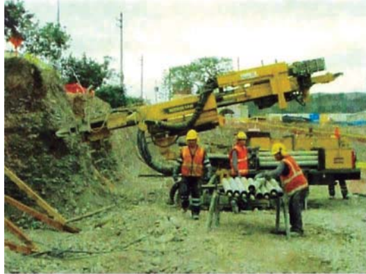
Figura N° 1.2.- Proceso de anclaje
