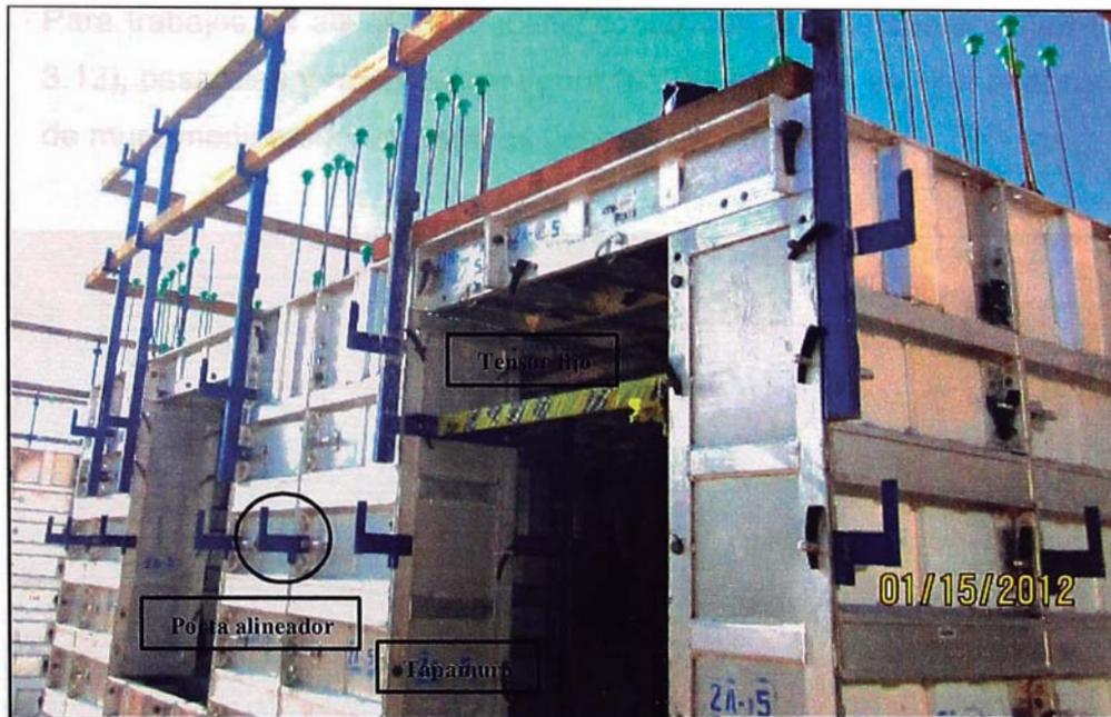
Figura 3.11 – Encofrado de vano de puerta - FORSA .
