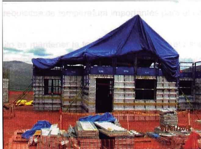
Figura 3.2 – Carpa de protección instalada en una vivienda tipo 1R.
