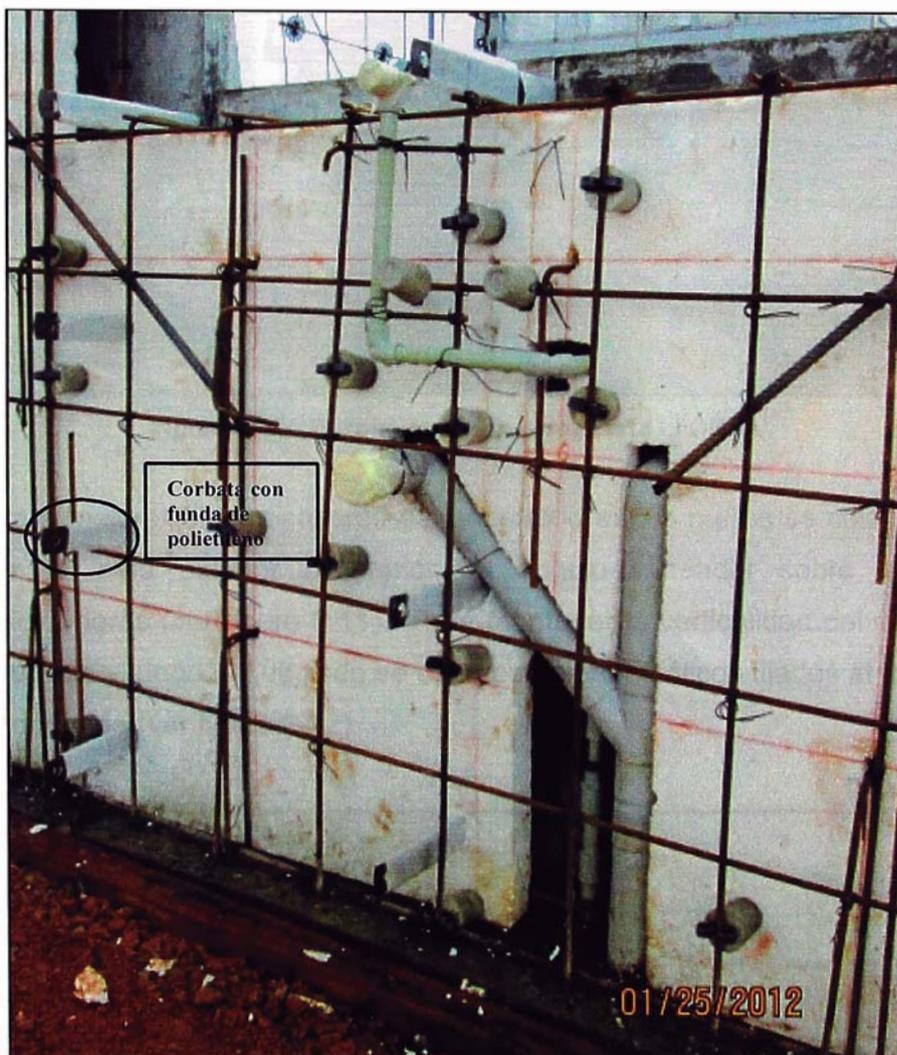
**Figura 3.10 – Colocación de tecnopor y corbatas.**
