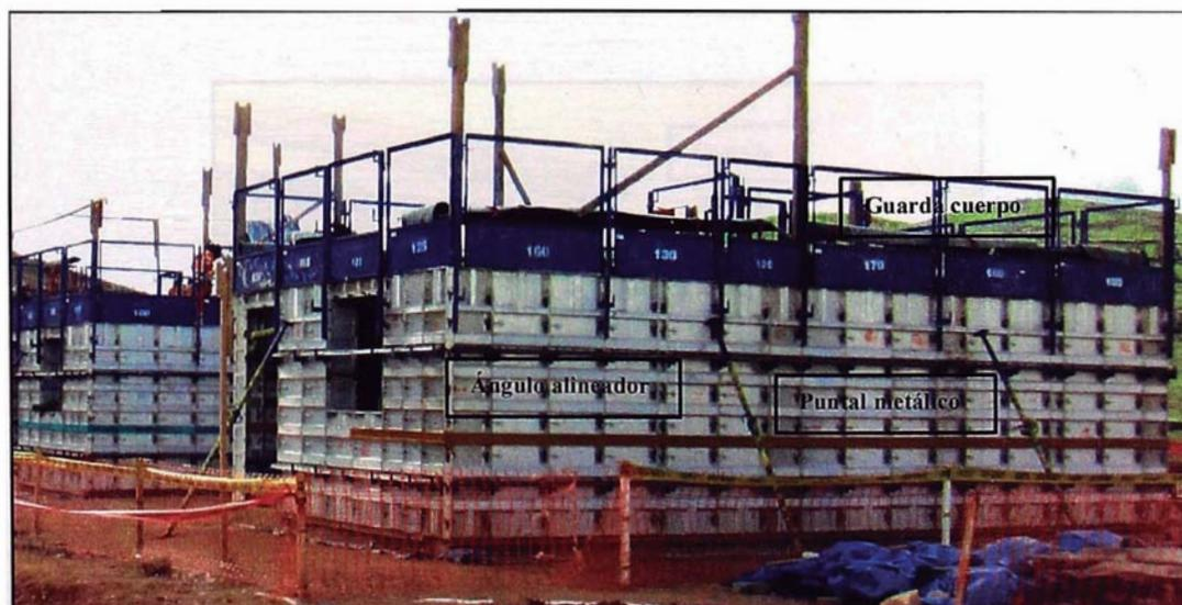
Figura 3.12 – Encofrado metálico FORSA – vista de ángulos alineadores.
