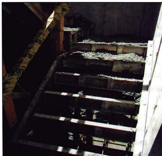
**Figura 3.19 – Encofrado de escalera.**
