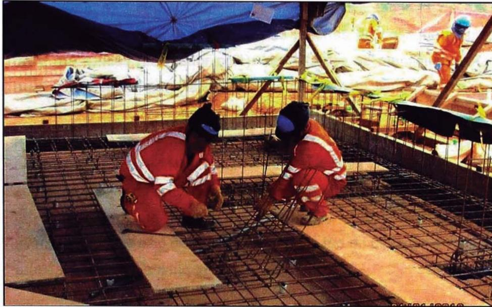
**Figura 3.5 – Colocación de acero en la platea de cimentación.**
