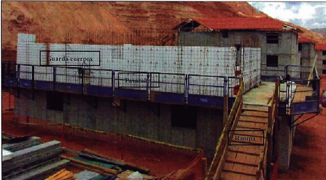
Figura 3.13 – Encofrado metálico FORSA – vista de pasarelas y rampa.
