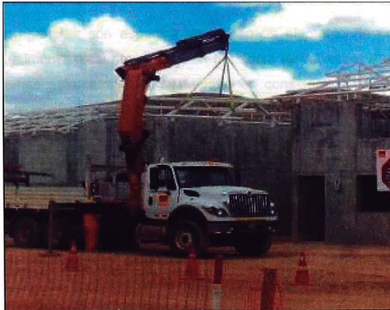
**Figura 3.20 – Montaje de estructura metálica del techo de la vivienda tipo 1R.**
