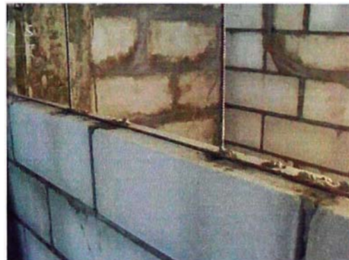
Figura 4.11: Colocación de varilla horizontal
