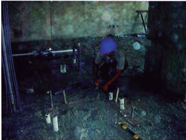
Figura 4.2: Trazado de la ubicación del tabique y del eje del muro a construir
