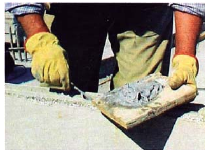
Fig. 2.7: Colocación del pegamento epóxico
