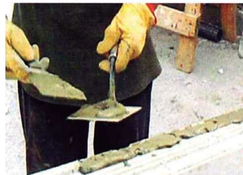
Fig. 2.11: Distribución de mortero de pega
