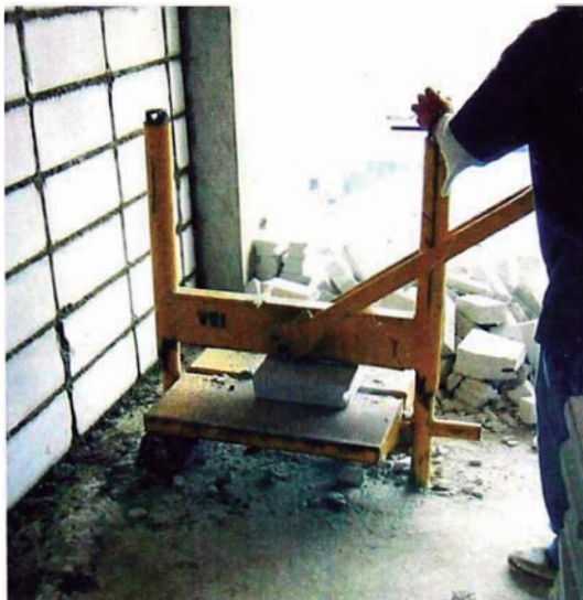
Figura 4.12: Cortes para terminaciones de los muros
