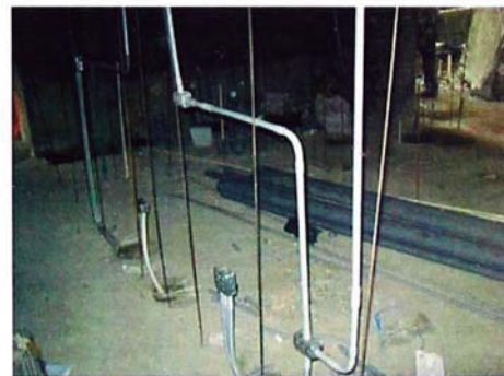
Figura 4.3: Detalles de instalaciones sanitarias y eléctricas
