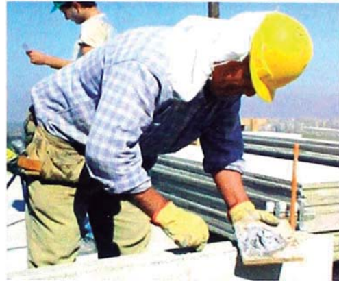
Fig. 2.9: Manipulación correcta del epóxico
