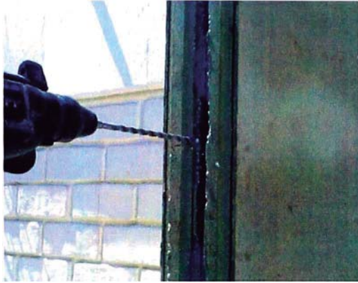
Fig. 2.8: Perforación para anclajes de acero
