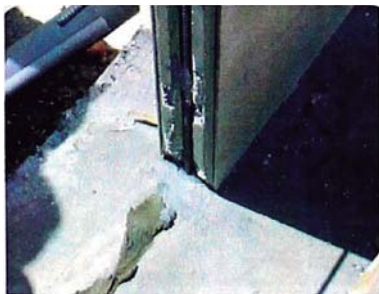
Fig. 2.6: Anclaje con epóxico de los paneles
