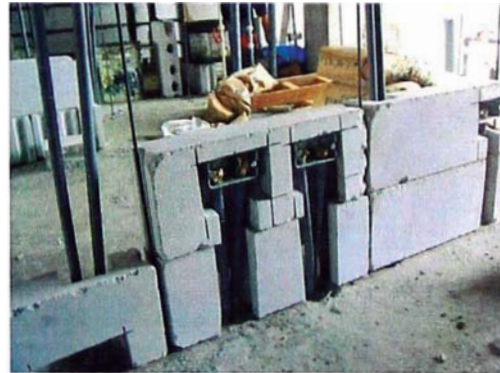
Figura 4.13: Cortes con amoladora para instalaciones sanitarias y eléctricas
