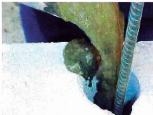
Figura 4.10: Colocación de concreto
