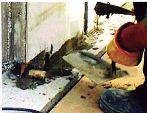
Fig. 2.14: Terminación con mortero de pega
