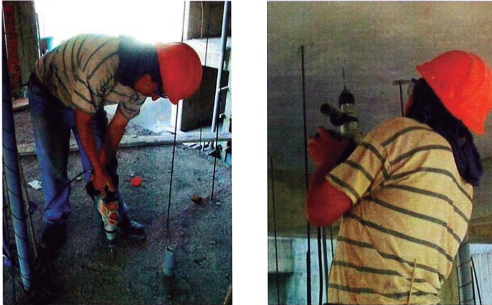
Figura 4.4: Perforaciones sobre el trazado del tabique.
