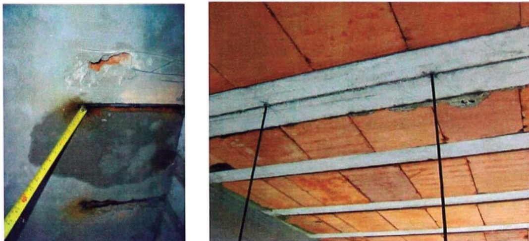
Figura 4.9: Detalles de anclaje paralelo
