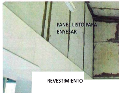
Fig. 2.15: Blanqueamiento de muros
