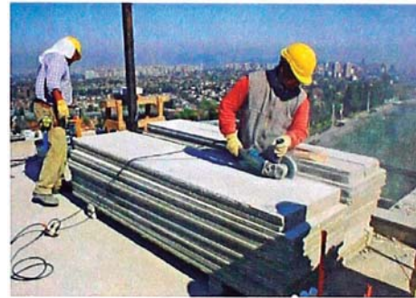
Fig. 2.5: Corte de los paneles
