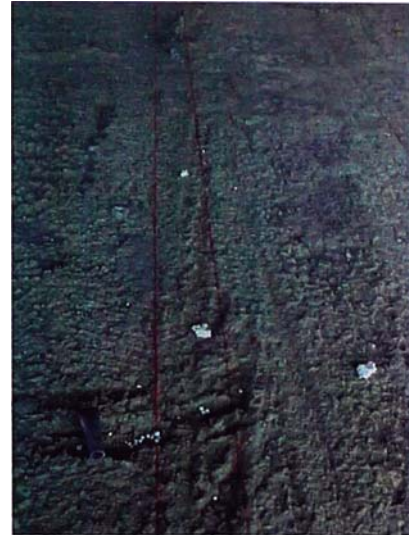
Figura 4.2: Trazado de la ubicación del tabique y del eje del muro a construir
