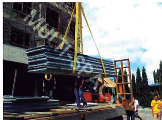
Figura 2.2: Transporte vertical con eslingas
