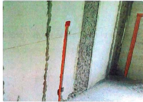
Fig. 2.13: Ranuras para instalación eléctrica
