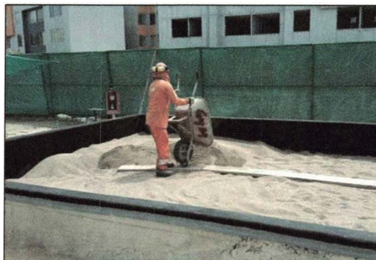
Figura N° 4.5. Colocación del sustrato de arena
