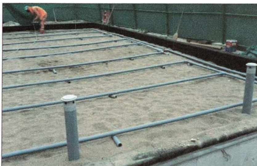
Figura N° 4.7. Colocación de la estructura de entrada
