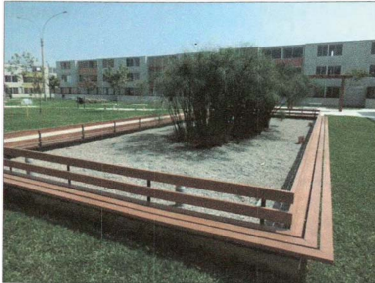
Figura N° 4.9. Vista del humedal final
