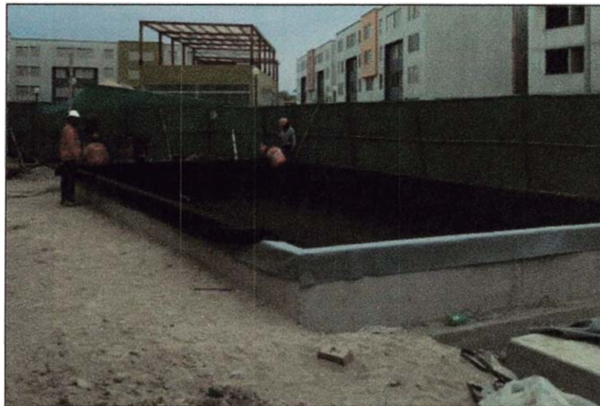
Figura N° 4.3. Colocación de geotextil de protección
