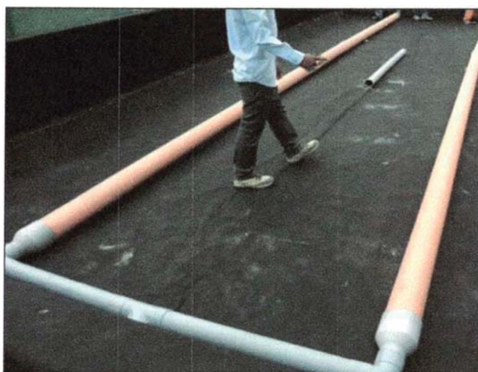
Figura N° 4.6. Colocación de la estructura de salida
