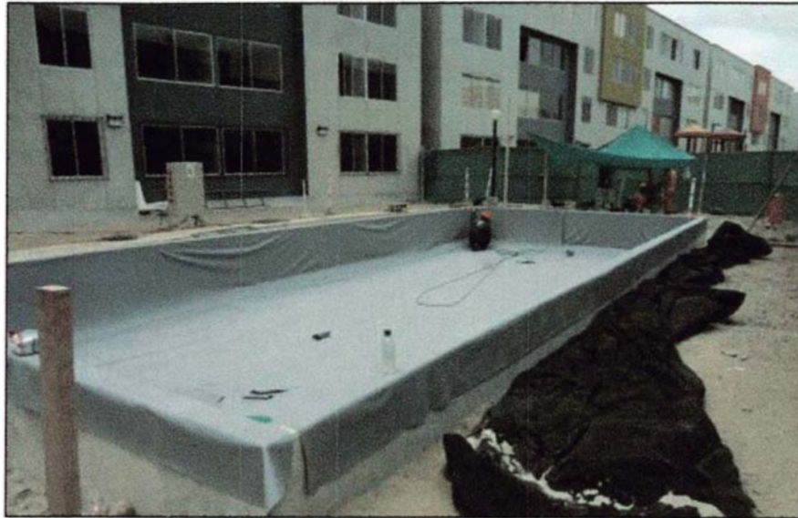
Figura N° 4.2. Colocación de geomembrana
