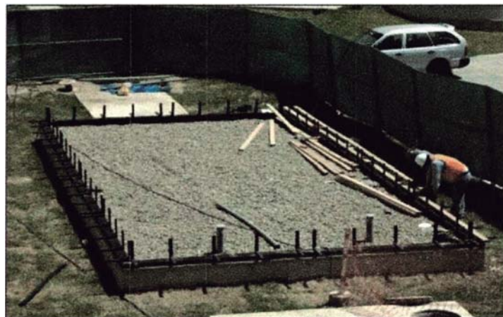
Figura N° 4.8. Colocación de bancas de madera
