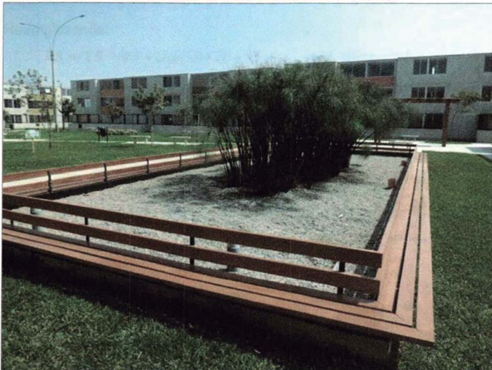
Figura N° 3.5. Humedal artificial de la primera etapa del proyecto “Los Parques de Carabayllo”
