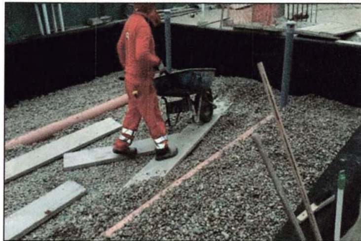
Figura N° 4.4. Colocación de confitillo de base
