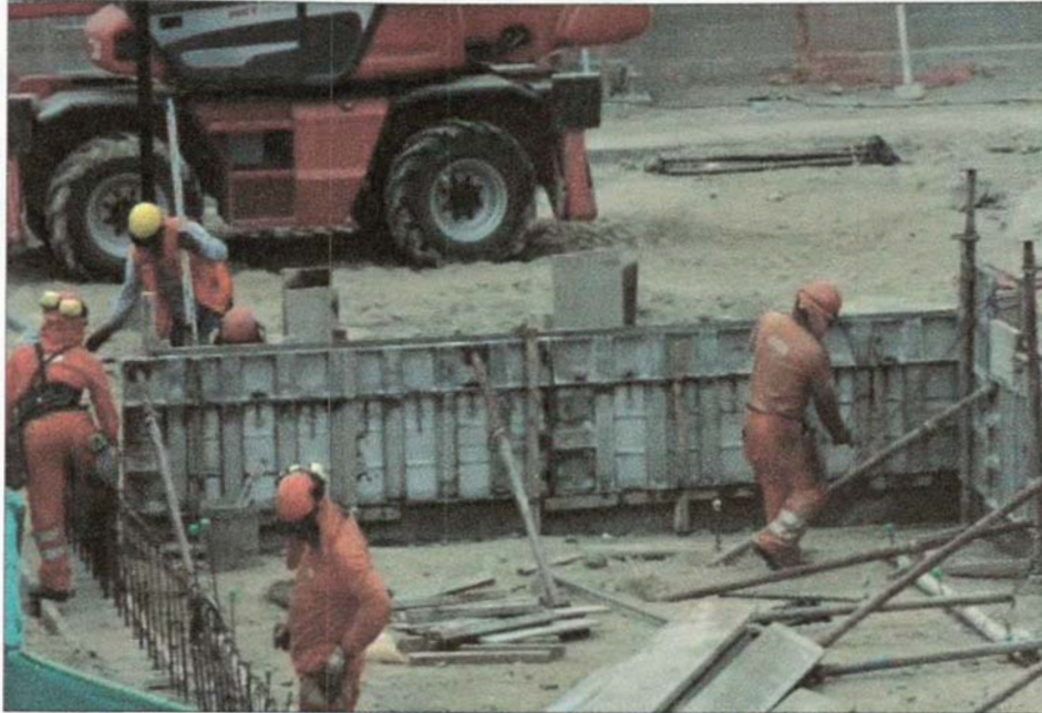
Figura N° 4.1. Encofrado del parapeto de la cubeta
