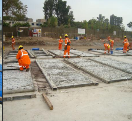
Desencofrado de prelasas
