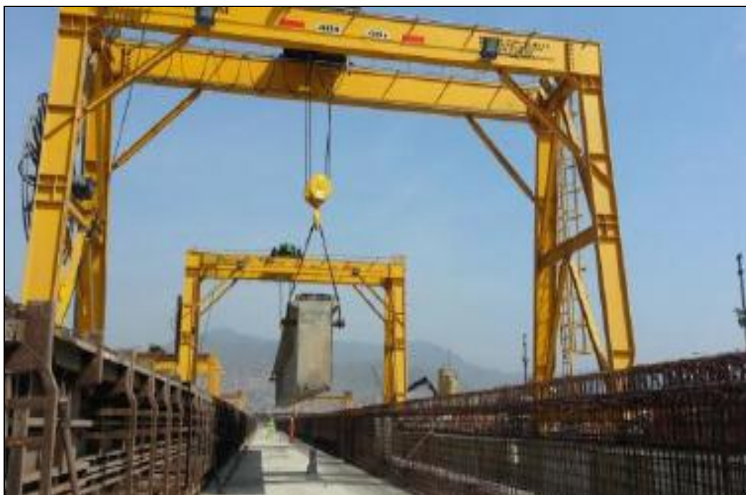
Fig. 132. Traslado de vigas al área de stock.
