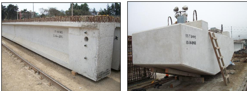
Fig. 19. Vigas pretensadas y Cabezales prefabricados.
