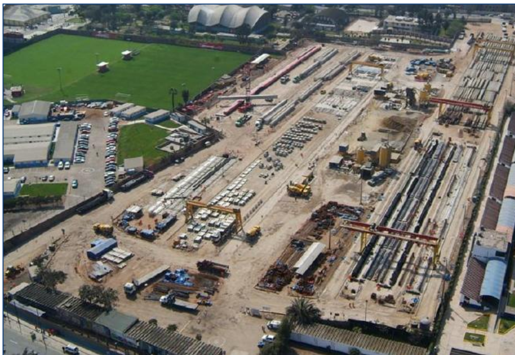
Fig. 9. Fotografía aérea - Planta de Prefabricados Tramo 1 –Línea 1.
