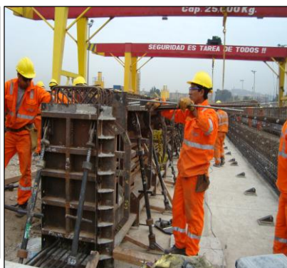
Encofrado de viga prefabricada
