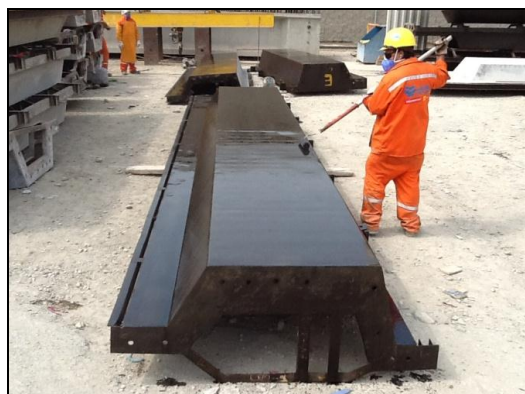
Fig. 54. Colocación de desmoldante a encofrados metálicos para vigas pretensadas.
