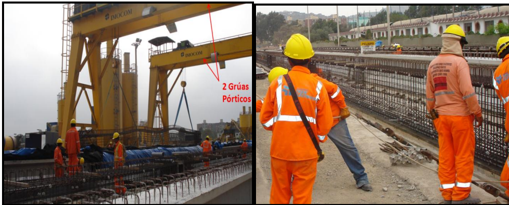
Fig. 53. Transporte mediante pórticos grúas
