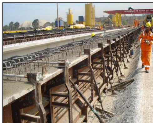
Fig. 125. En la planta de prefabricados del tramo 1 todas las líneas de producción de vigas estaban a la misma cota final.
