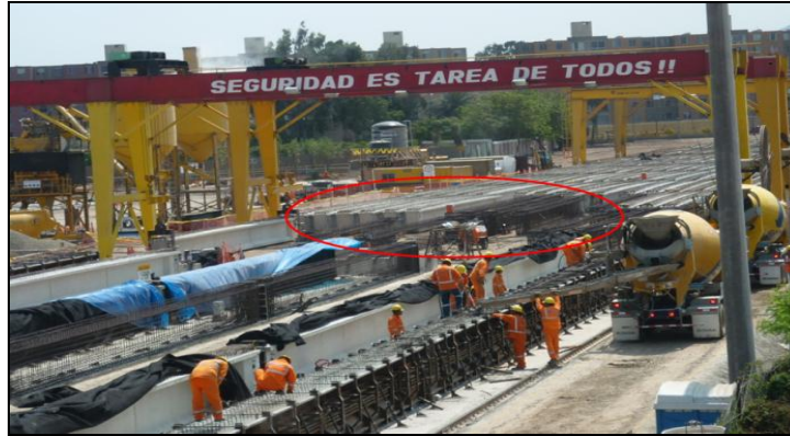
Fig. 52. Se muestra el stock de las armaduras
