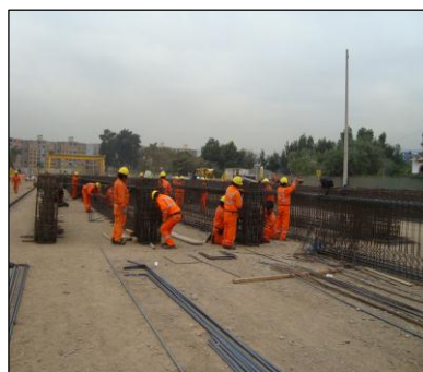
Habilitado y ejecución de armadura de viga prefabricada
