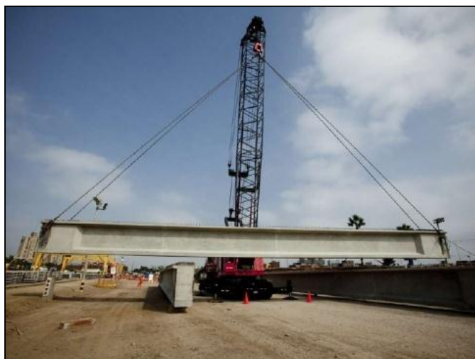
Fig. 36. Traslado de vigas prefabricadas desde su línea de producción al área de stock. Caso Tramo 1, Línea 1 de la construcción del viaducto del tren eléctrico.
