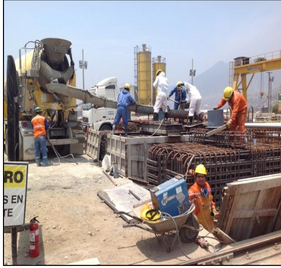
Fig. 122. Colocación de restricciones metálicas en armadura de viga cabezal y colocación de concreto.
