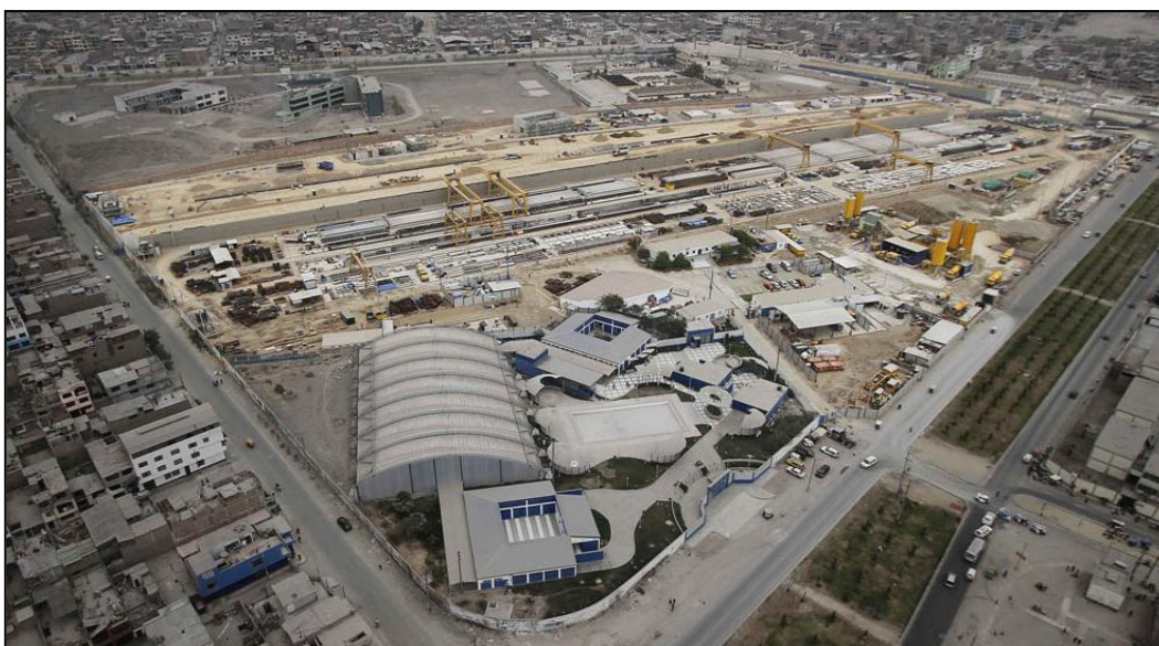
Fig. 11. Fotografía aérea - Planta de Prefabricados Tramo 2 –Línea 1.
