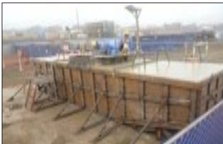
Fig. 86. Vaciado de concreto para viga cabezal prefabricado.
