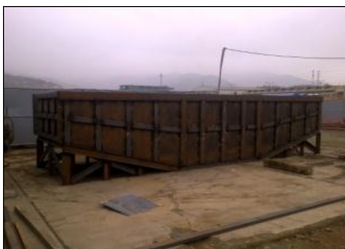
Fig. 85. Encofrado para viga cabezal prefabricado.
