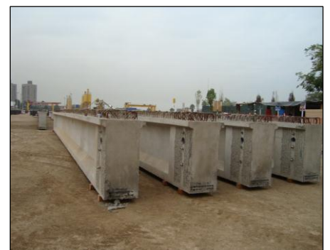
Vigas prefabricadas en área de stock
