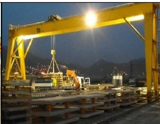
Fig.107. Carguío de pre losas
