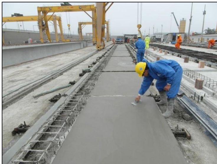
Fig. 69. Pulido y acabado de bordes típicos
