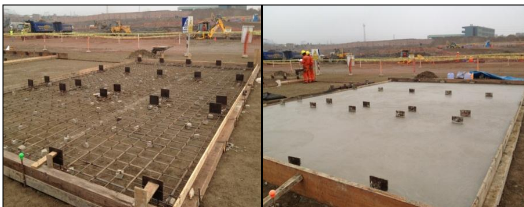
Fig. 110. Fotografía izquierda muestra encofrado de losa de apoyo para fabricación de bordes típicos. Fig. 111. Fotografía derecha muestra vaciado de losa de apoyo para fabricación de bordes típicos
