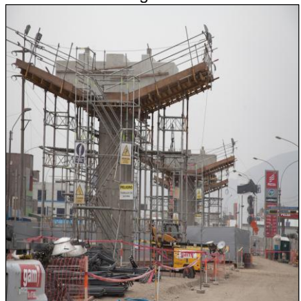
Viga cabezal in situ
