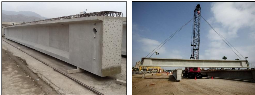
Fig. 42. Izquierda. Viga Pretensada. Fig. 43. Derecha. Izaje de viga pretensada
