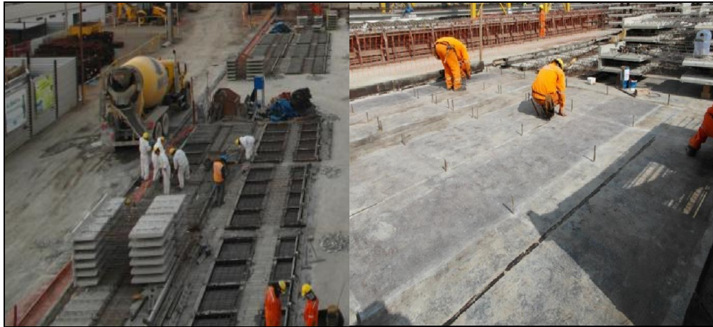
Fig. 104. Área de fabricación de pre losas y actividad de encofrado
