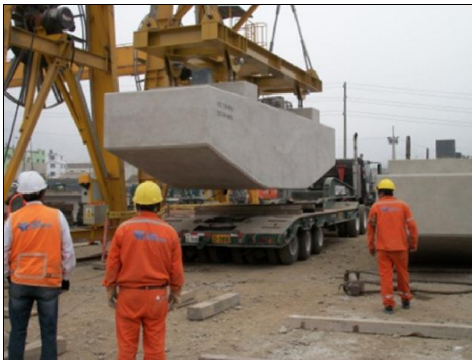
Fig. 91. Traslado de viga cabezal prefabricada a camión plataforma con apoyo de grúa tipo pórtico.
