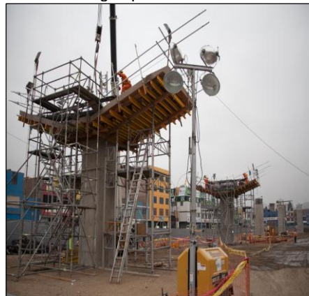
Encofrado de viga cabezal in situ
