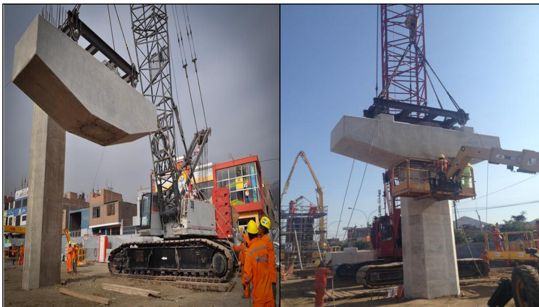
Fig. 123. Montaje de cabezal prefabricado
