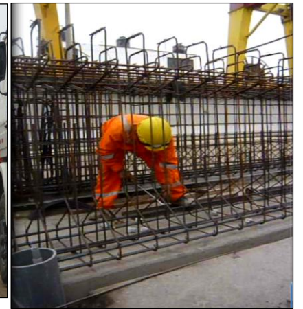
Video – Armadura de viga prefabricada
