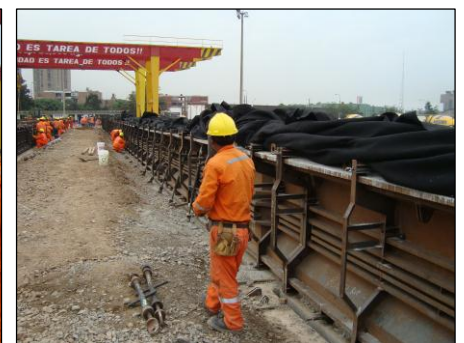
Curado de viga prefabricada
