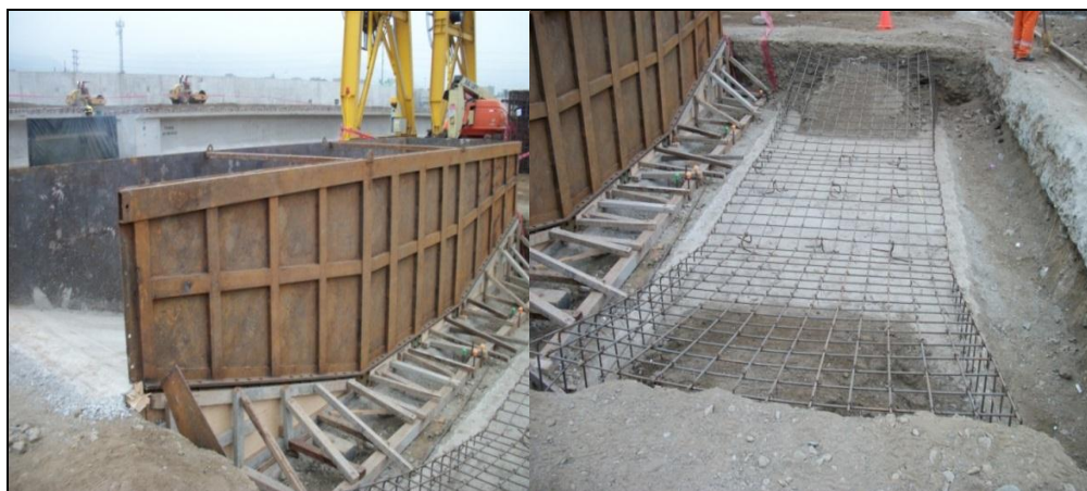
Fig. 89. Ejecución de plataforma para producción de viga cabezal prefabricado
