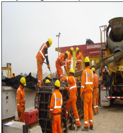
Vaciado de vigas prefabricada
