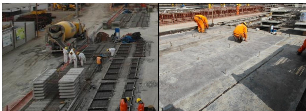
Fig. 64. Área de fabricación de pre-losas y habilitado de planchas metálicas
