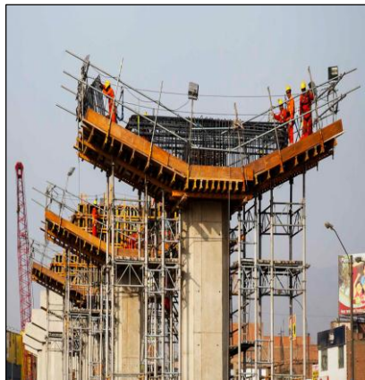
Armadura de viga cabezal in situ.
