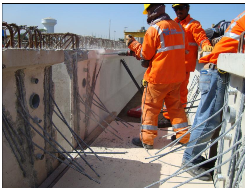
Fig. 58. Fotografía muestra la preparación de las zonas que formaran parte de las vigas diafragmas en el siguiente vaciado.
