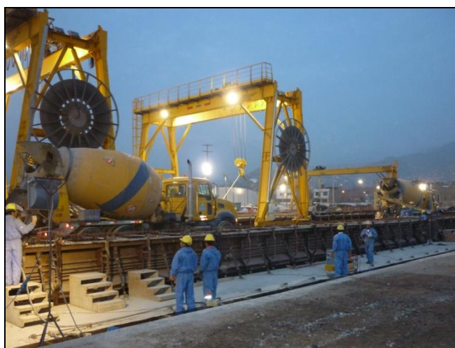
Fig. 56. Colocación de concreto de vigas pretensadas.
