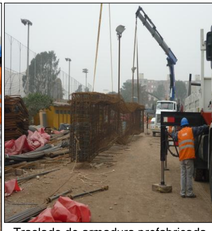
Traslado de armadura prefabricada
