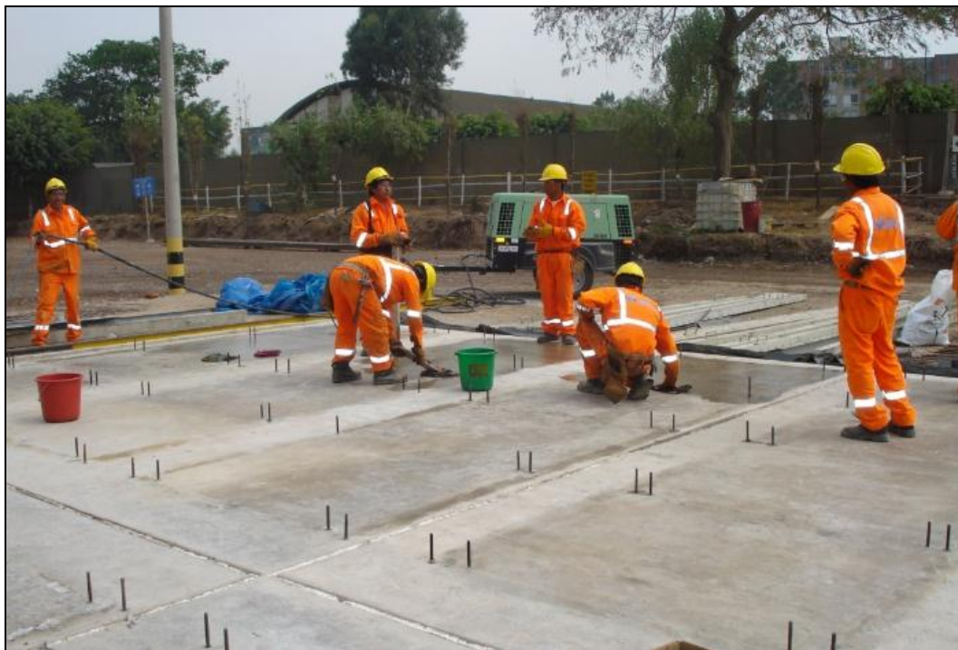
Fig. 94. Colocación de desmoldante en losa de apoyo para fabricación de prelosas.
