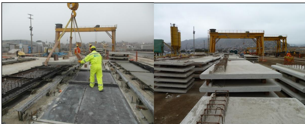
Fig. 70. Apilado de Bordes típicos
