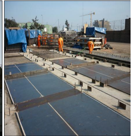
Encofrado para borde típico
