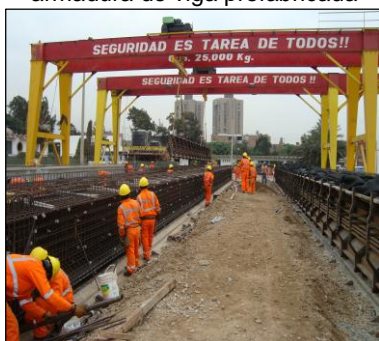
Encofrado de viga prefabricada
