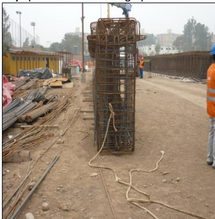
Armadura de viga prefabricada
