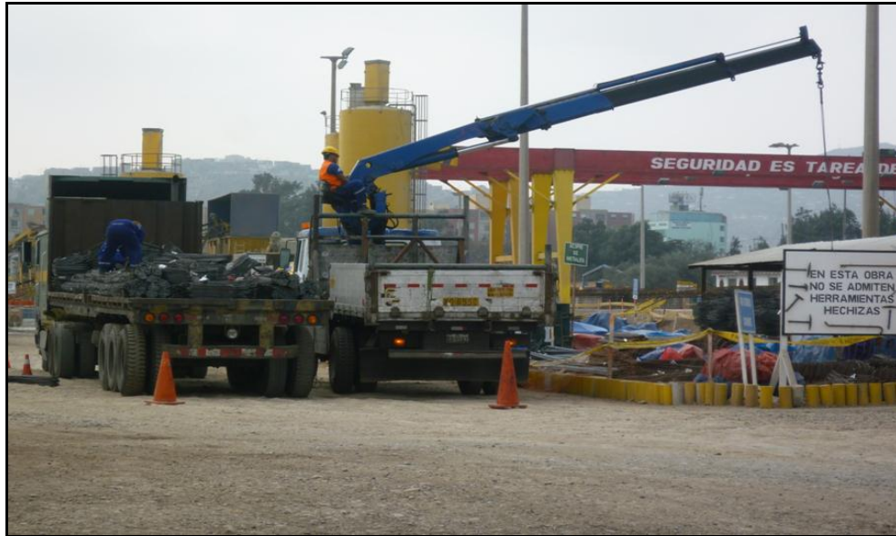
Fig. 47. Muestra la descarga de material en el taller de fierriería.
