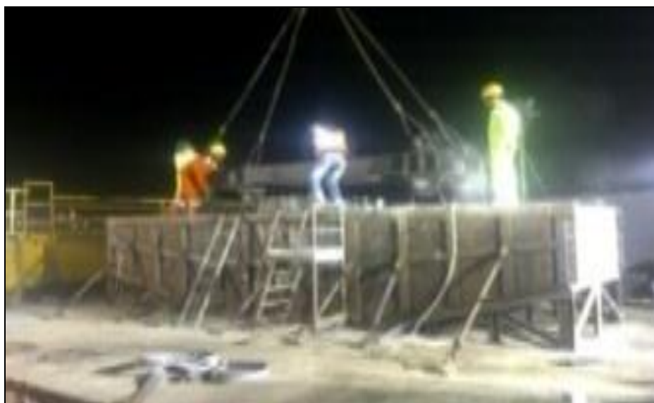
Fig. 87. Proceso de desencofrado de viga cabezal prefabricado.
