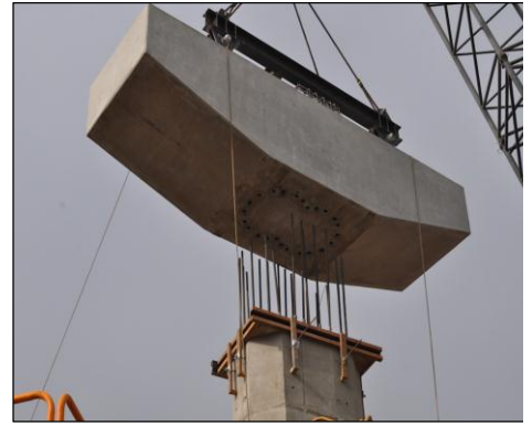
Montaje de viga cabezal prefabricado
