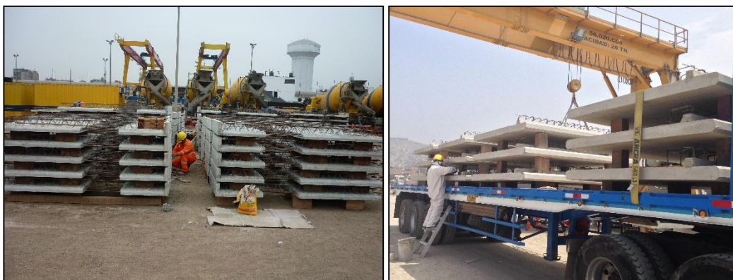
Fig. 20. Prelosas y Bordes Típicos prefabricados.
