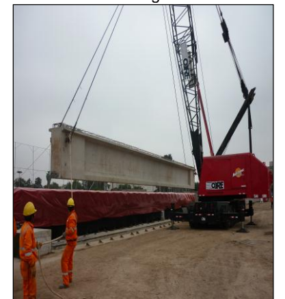
Traslado de viga prefabricada
