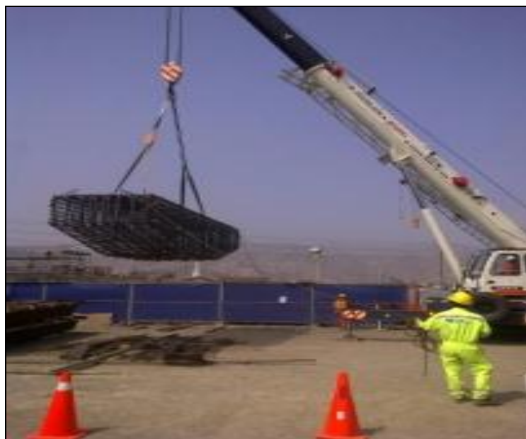
Fig. 84. Traslado de armadura de acero a encofrado.
