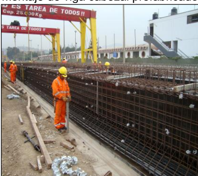
Colocación de dados de concreto a armadura de viga prefabricada
