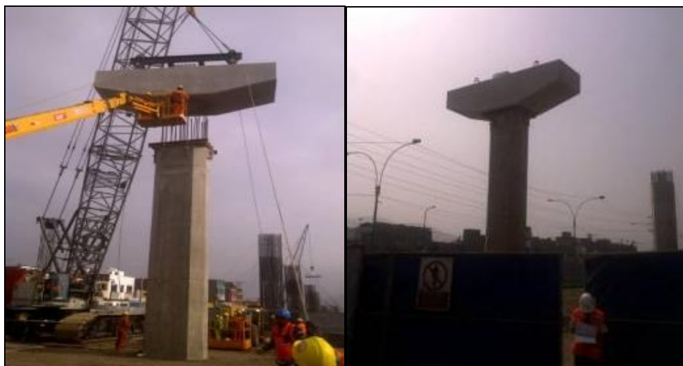
Fig. 88. Proceso de montaje y liberación de maniobra de viga cabezal prefabricado.
