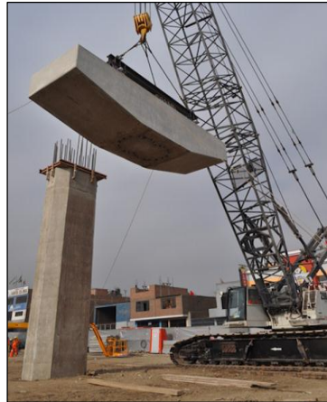
Izaje de viga cabezal prefabricado
