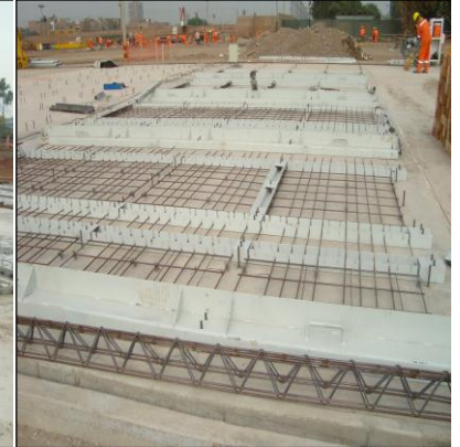
Encofrados de prelasas
