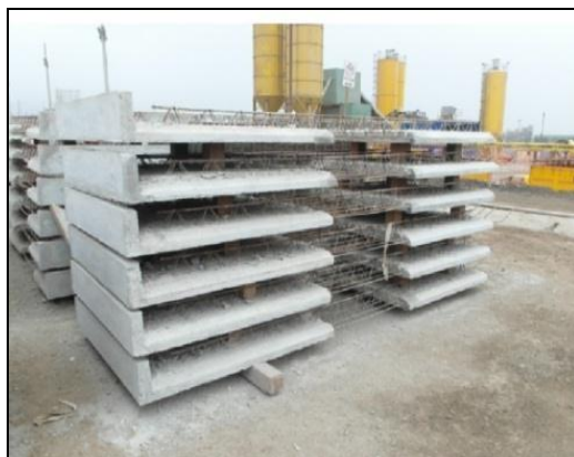
Fig. 106. Apilado de prelosas.
