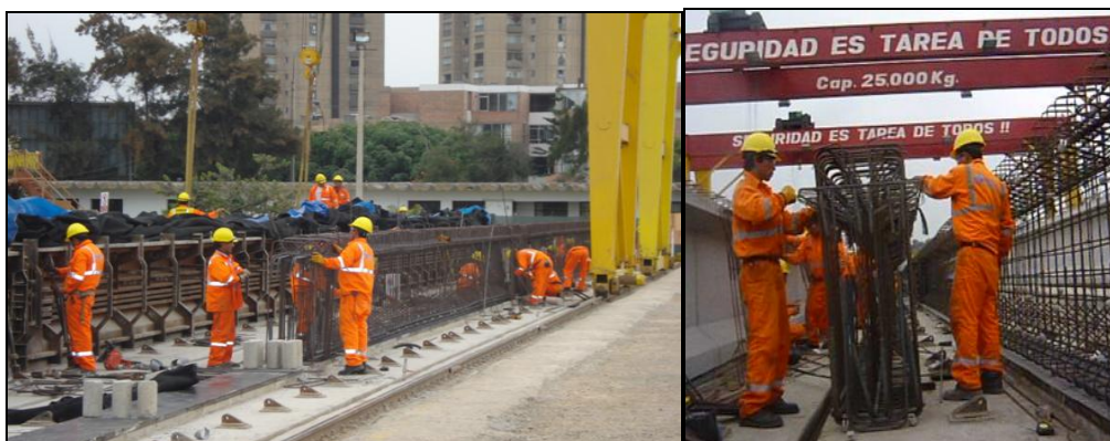
Fig. 51. Se muestra el armado en el mismo sitio donde será encofrado y fuera del lugar de encofrado.
