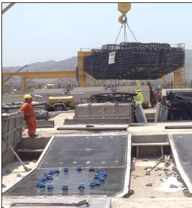
Fig. 90. Colocación de armadura en encofrado con apoyo de grúa tipo pórtico.
