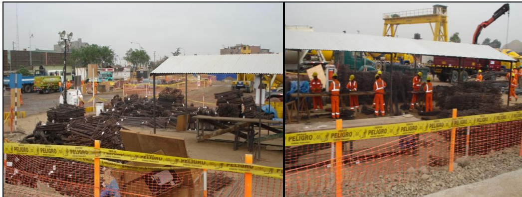
Fig. 49. Muestra el acopio del acero dimensionado y la mesa de trabajo para realizar el armado de estribos.
