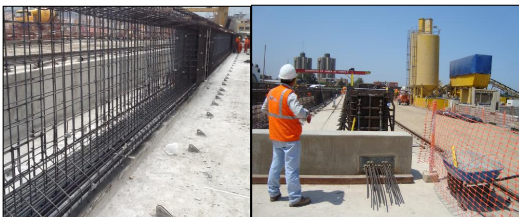
Fig. 55. Colocación de torones en armaduras de vigas pretensadas.
