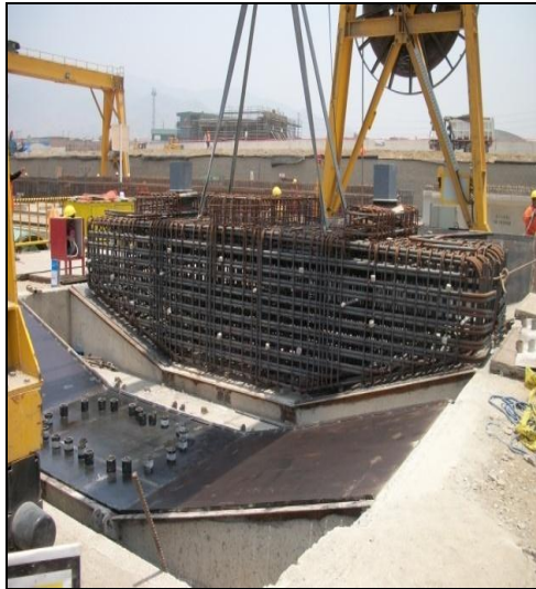
Fig. 121. Se utilizaron las 2 grúas pórtico de 40 t para el transporte de mallas, encofrado, armadura de viga cabezal, desencofrado, traslado y carguío de vigas cabezal.
