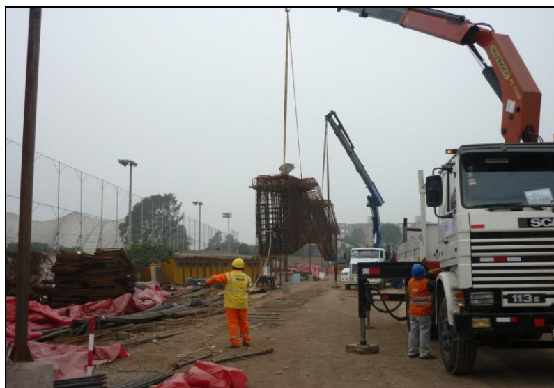
Fig. 129. En el tramo 1. Con la necesidad de realizar vigas atípicas de H = 1.80 m, se construyó un patio adicional para vigas, pero sin uso de pórticos grúas
