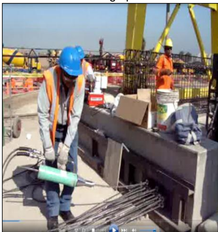
Video-tensado de torones en viga prefabricada.
