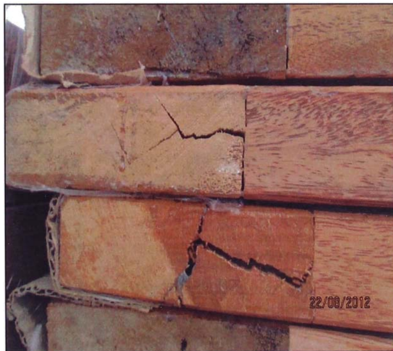
FIGURA N°. 10: PUERTAS DAÑADAS.
