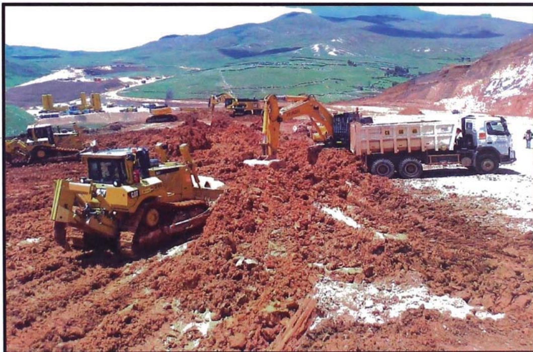
FIGURA N°. 2: MOVIMIENTO DE TIERRAS.
