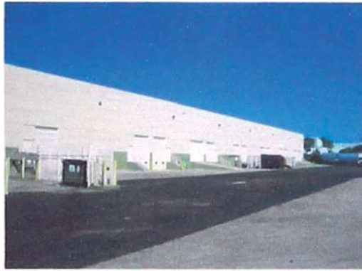
Back – Almacen doors. Carga/Descarga
