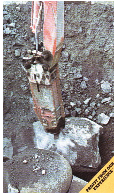
Fotografía N° 2-3: Martillo rompe bancos
