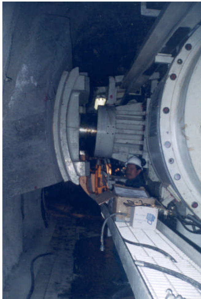
Fotografía N° 2-22: Gripper posterior izquierdo de la “TBM MK 12” fijado en la losa de arranque
