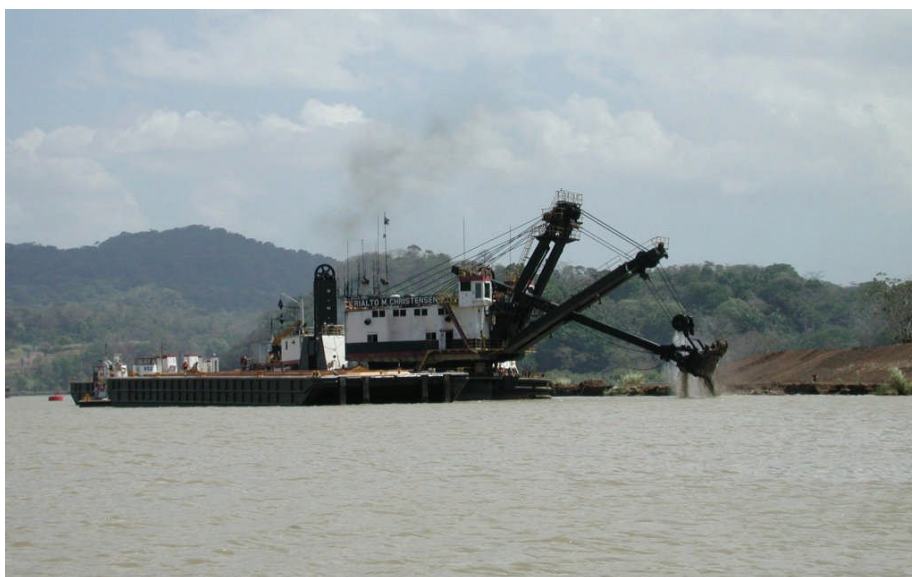
Fotogr. N° 2-9: Draga con simple cangilón profundizando el Canal de Panamá.
