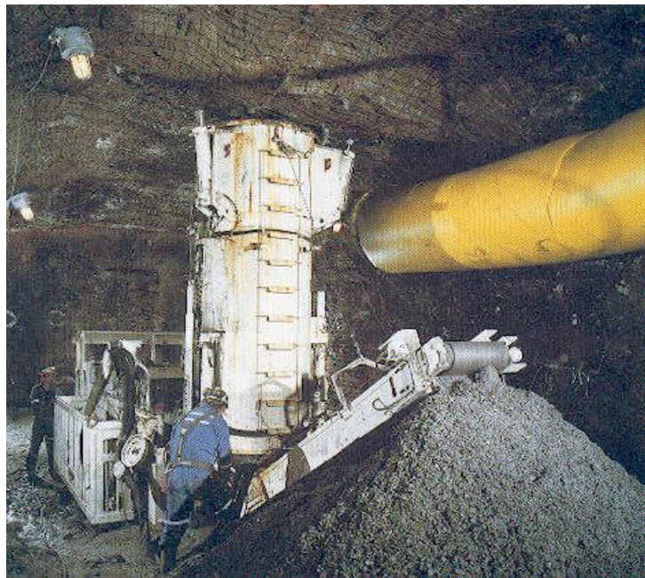
Fotografía N° 2-13: Borpak en proceso de excavación.
