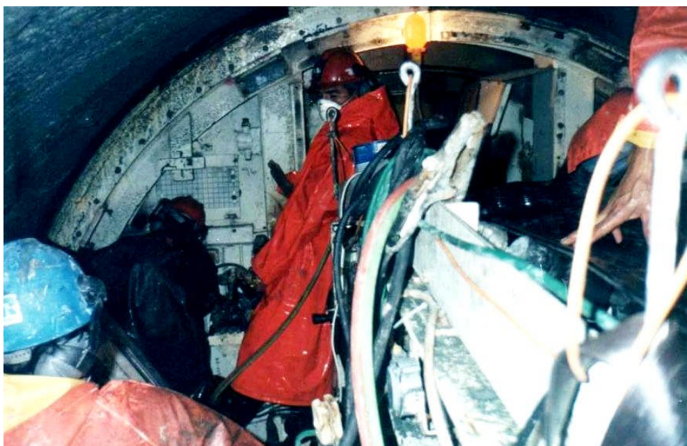
Fotografía N° 4-3: Tarjeta reticulada en la parte alta del costado izquierdo del escudo de polvo, para la alineación con el láser el curso de la "TBM".
