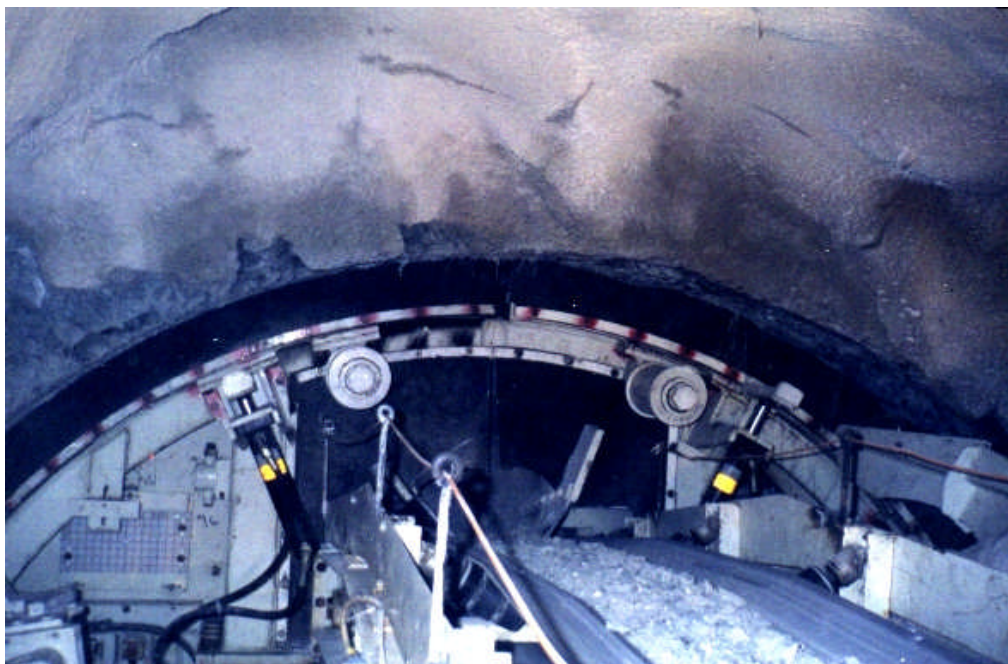
Fotografía 3-19: Escudo de polvo, mostrando además borde de Jebe, instalador de cimbras, tarjeta reticulada de alineación con laser y cordón de parada de emergencia.
