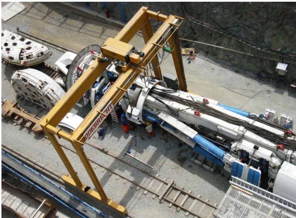
Fotografía N° 2-16: “TBM” de viga Principal “MB 200” en Olmos (Lambayeque – Perú).
