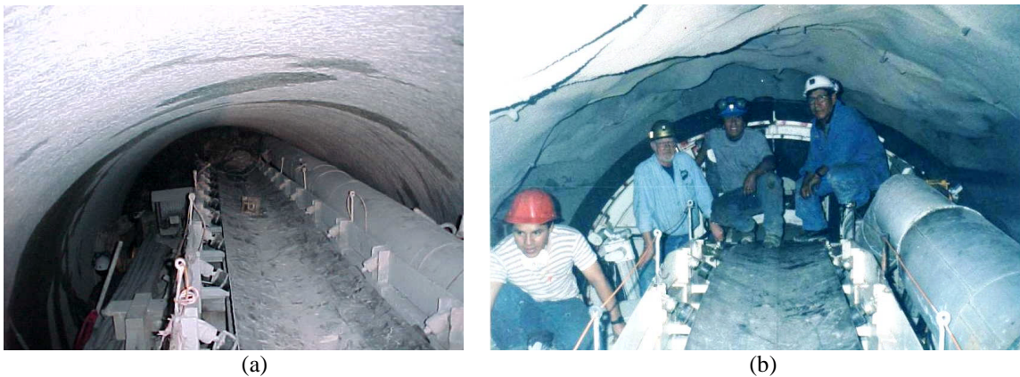
Fotografía N° 7-2: Contornos de la excavación. (a) Con “TBM”. (b) Con “P&V”, visto antes del inicio de la excavación con “TBM”.
