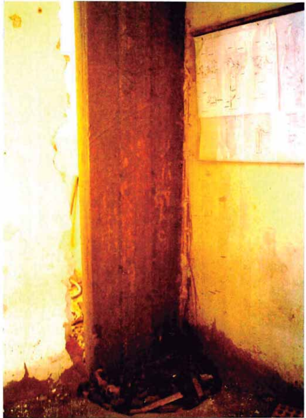
Columna nueva, se plantaron varias de estas para poder hacer el 2do piso
