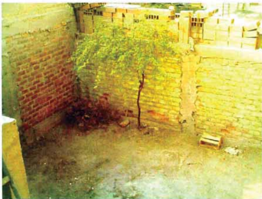
Patio posterior antes de la intervención
