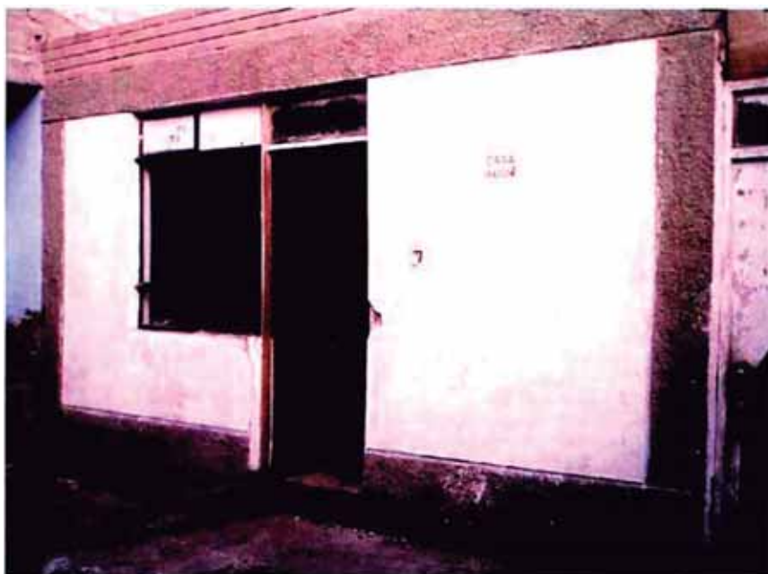
Fachada antes de la intervención
