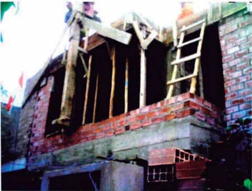
Construcción de la nueva fachada
