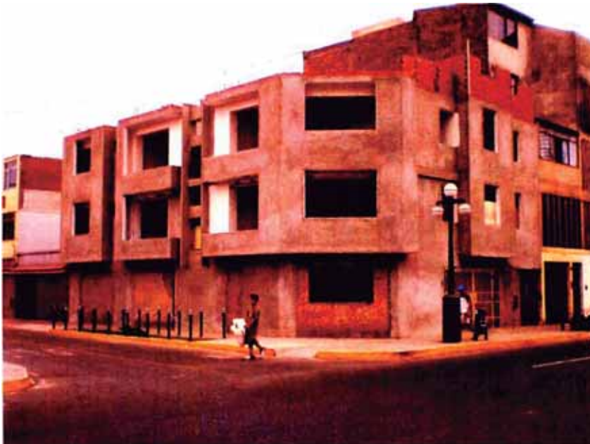
Avance de la obra
