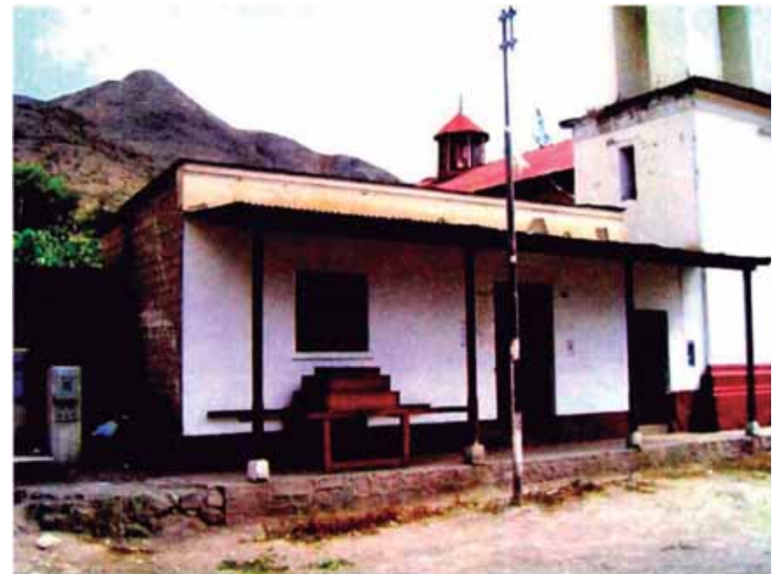
Foto de la fachada de la edificación a intervenir
