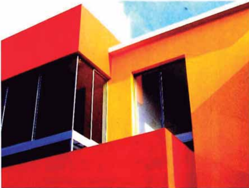
Detalle de la fachada
