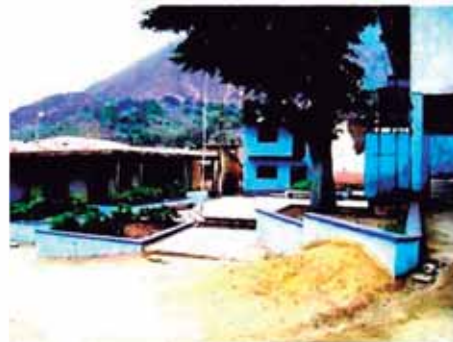
Estado actual de la plaza, ingreso principal
