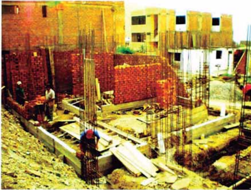
Foto del avance de la obra, el cimiento es con viga de cimentación
