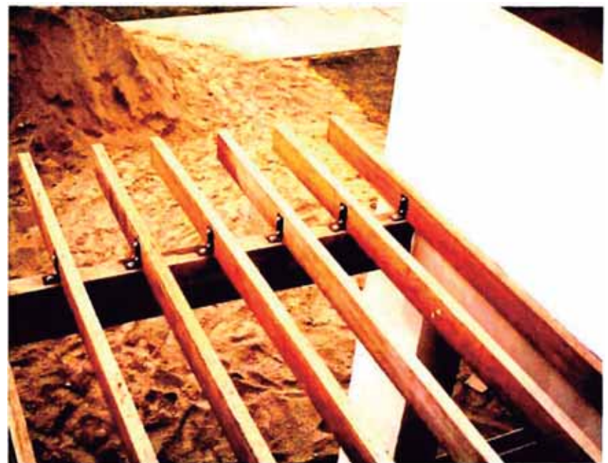
Detalle del techo de madera de la terraza que da a la calle
