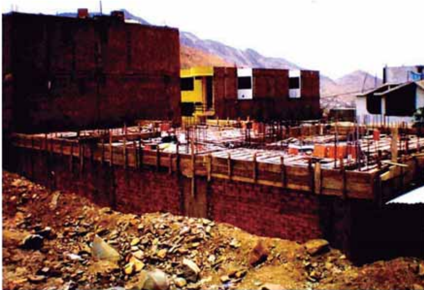
Foto de la armadura del techo
