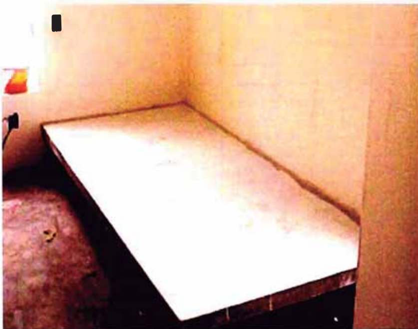
Cama de concreto
