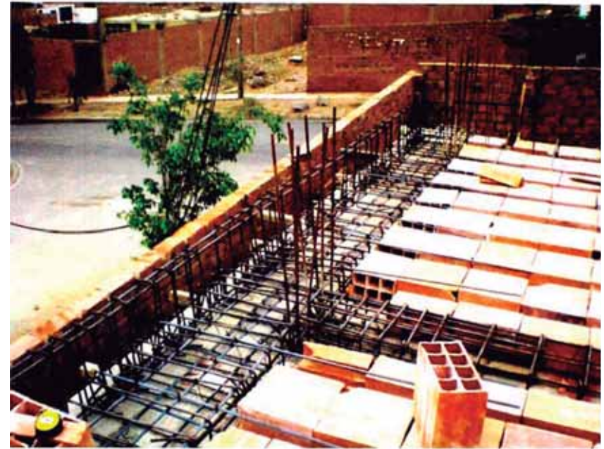
Detalle de vigas en el volado.
