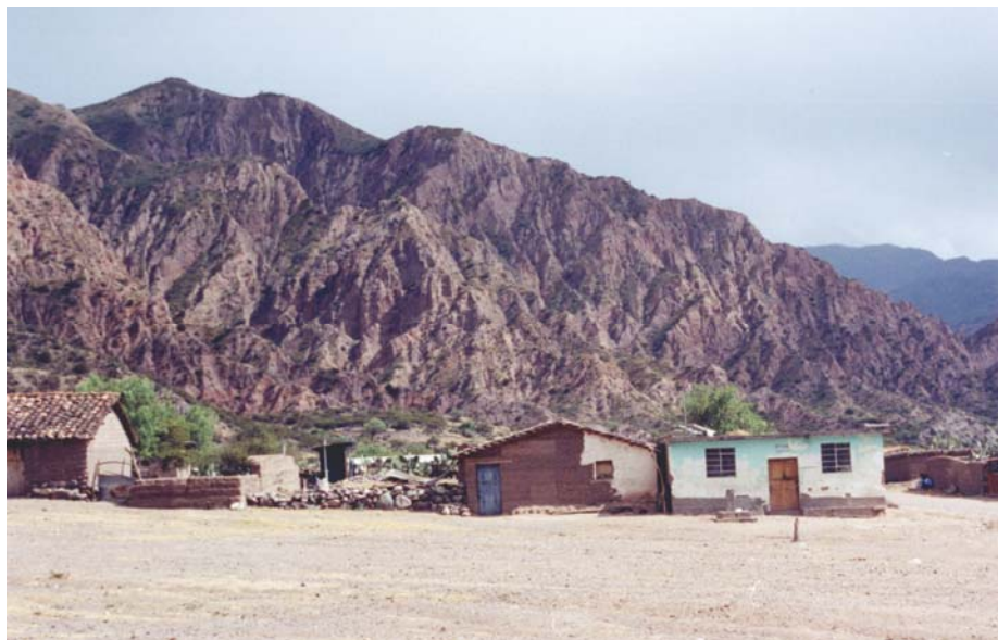
Foto N° 16.- Erosión de laderas en superficies colinosas del sector Cayarpachi Provincia de Huamanga, Departamento de Ayacucho en la trocha afirmada Huamanga-Julcamarca donde a menudo suceden huaycos que interrumpen la trocha en varios tramos debido a que el material se hace muy deleznable y fácilmente acarreado por el agua de escorrentía.
