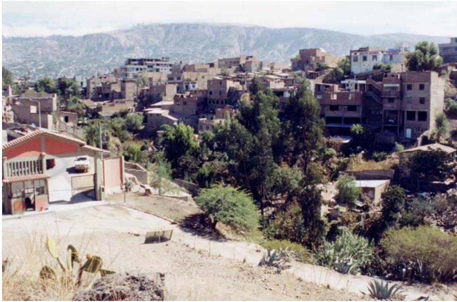
Foto N° 26.- Impacto en la calidad del agua por vertimiento de residuos orgánicos al cauce de la quebrada Tarahuaicco la misma que en época de lluvias se encarga de recolectar los residuos sólidos que son esparcidos aguas abajo en la ciudad de Huamanga.
