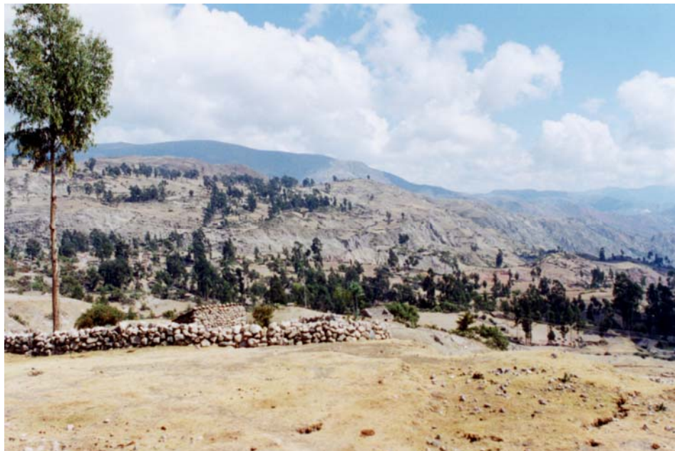
Foto N° 10.- Deslizamientos antiguos y activos en Sunchupucro, Provincia de Huamanga, Departamento de Ayacucho, en cada temporada de lluvias estos se activan, el material está constituido por areniscas, conglomerados, limolitas y yeso.
