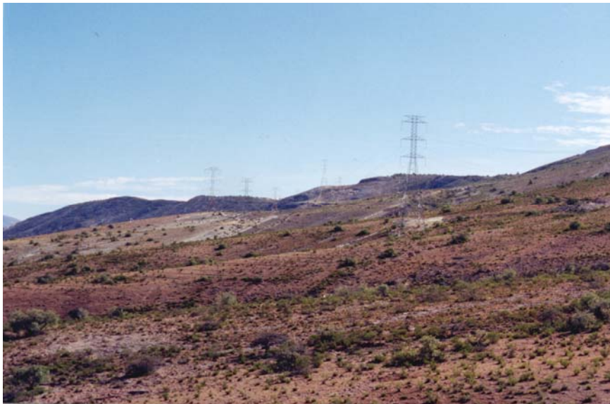
Foto N° 29.- Impacto visual en el paisaje debido a la construcción de torres de alta tensión en terrenos susceptibles a erosión de laderas.
