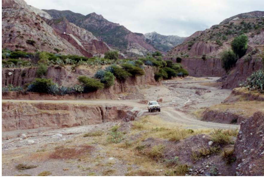
Foto N° 13.- Huayco periódico interrumpe carretera en el km 96+800 Huamanga-Julcamarca, quebrada Ancaypaya, sector Cayarpachi, Provincia de Huamanga, Departamento de Ayacucho.
