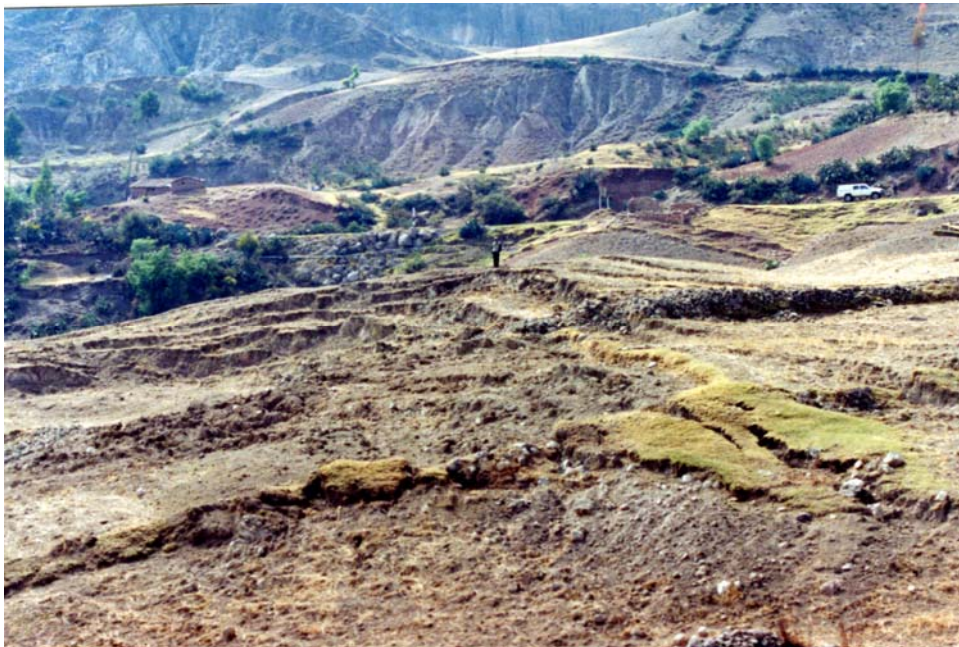
Foto N° 8.- Deslizamiento de Rancho en la Provincia de Huamanga, Departamento de Ayacucho, en el km 322 + 300 carretera Libertadores, es un deslizamiento activo que daña la vía.
