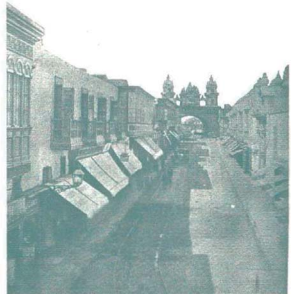
(19) Arco del Puente de Piedra de Lima , inaugurado en el año de 1611, destruido por un terremoto en el año 1746, reconstruido en el año de 1752 y 1771, funcionando hasta el año de 1879 en que fue destruido por un incendio.
