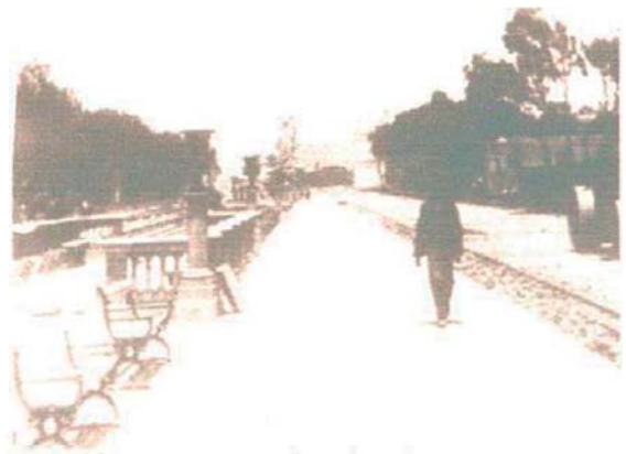
(23) Vista del paseo 9 de Diciembre, en construcción.
