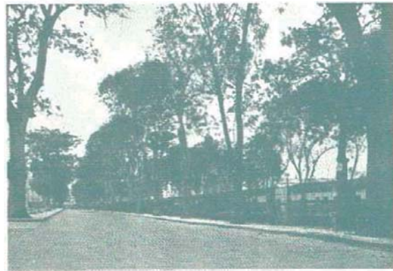
(57) Alameda de los descalzos, en el distrito del Rímac, Lima 1918,
