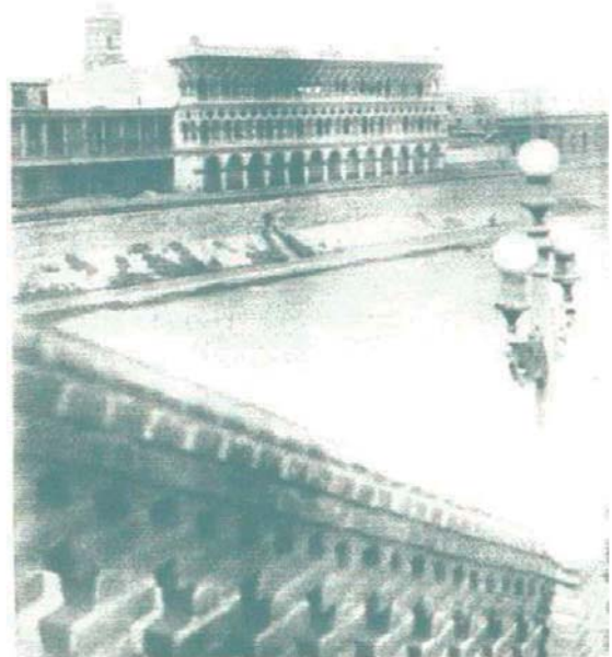
(59) Casa de los Astete y Concha, Palacio de estilo veneciano, ubicado en parte del terreno ocupado actualmente por la Alameda Chabuca Granda, Lima 1918
