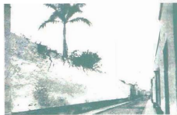
(71) Calle del Antiguo Barrio del Cercado
