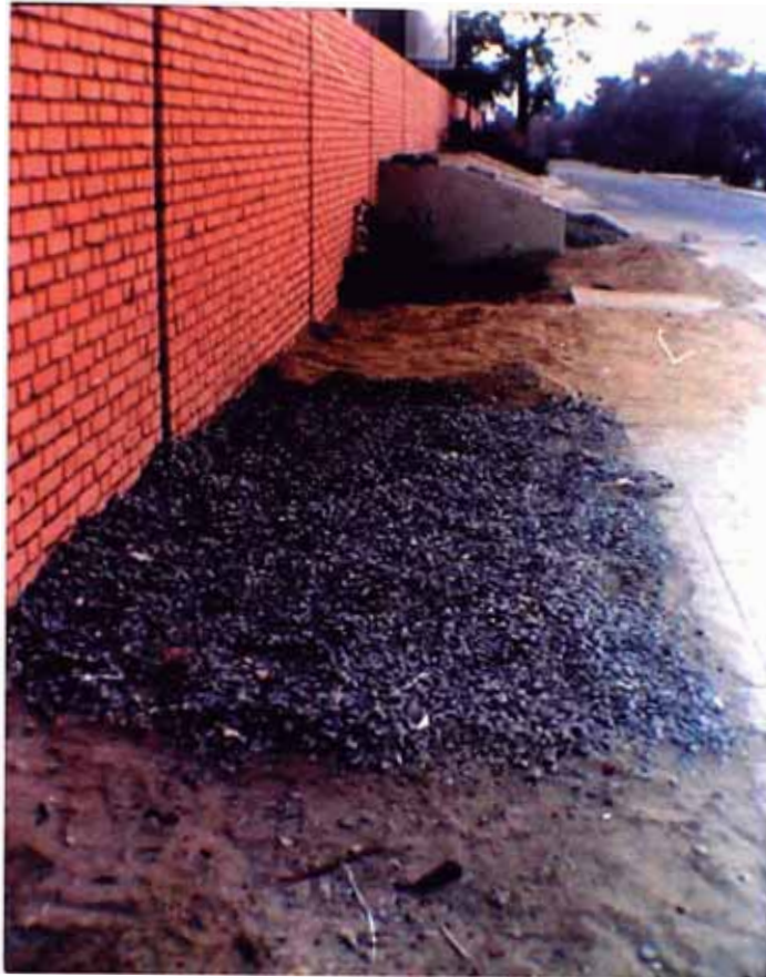
FOTO N° 3 Se debe desechar el agregado que está en contacto con material contaminante.
