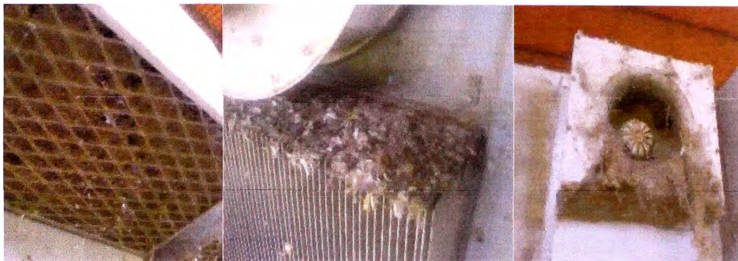
Fig. 4.1 Rejillas obstruidas
