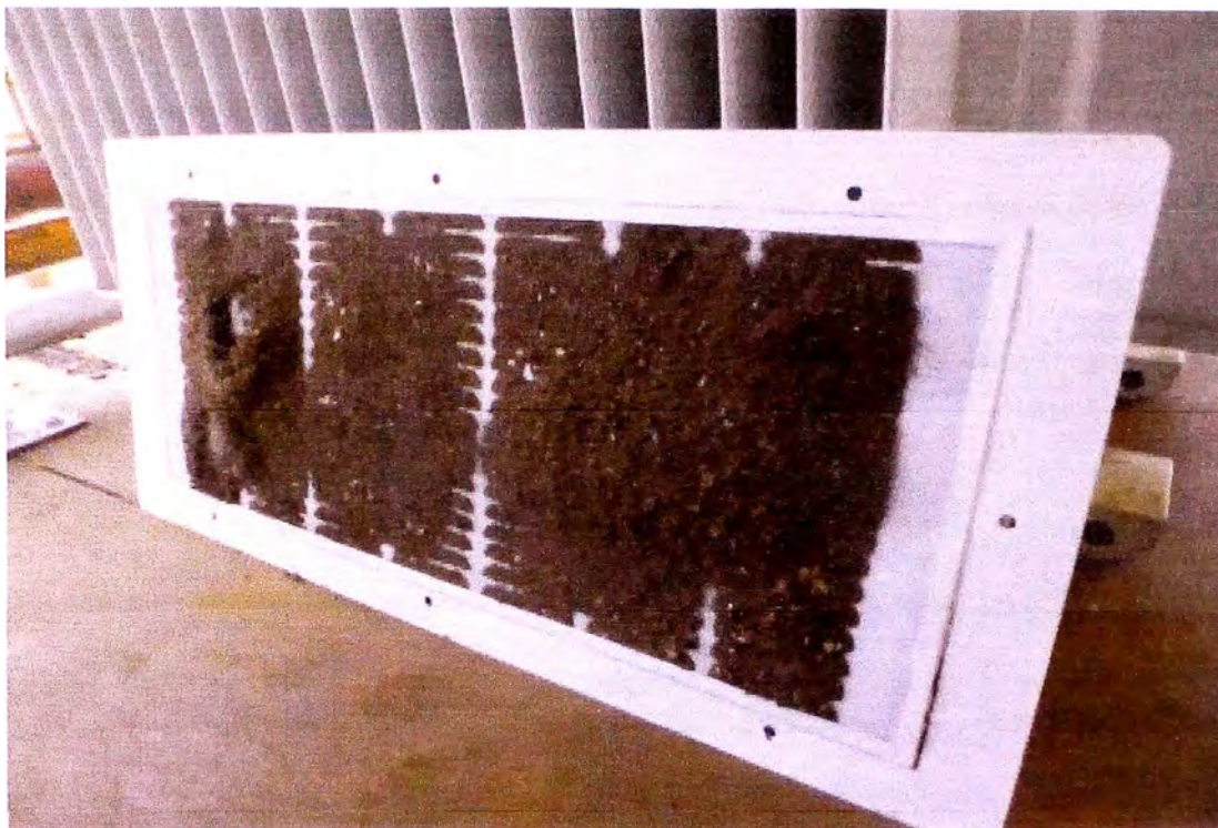
Fig. 4.2 Rejillas obstruidas
