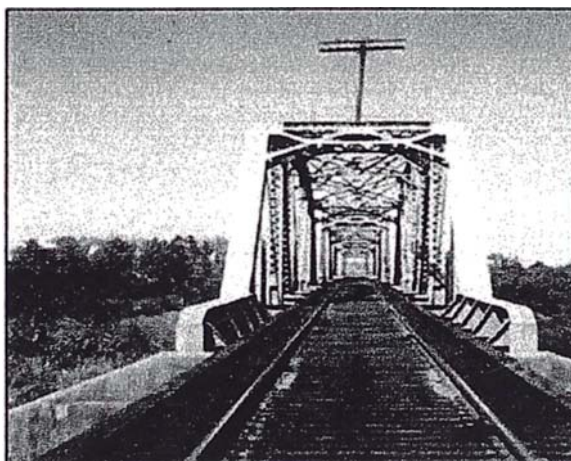
Figura 2.7 Ambiente Rural - Puente ferroviario
