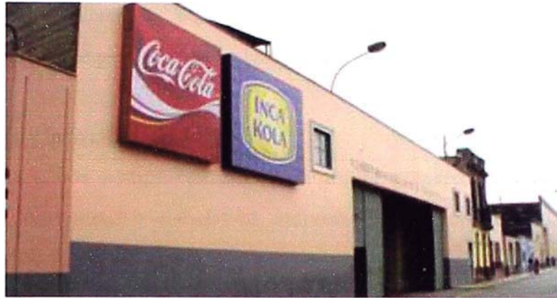
Figura 3.1: Vista de la Planta Rímac
