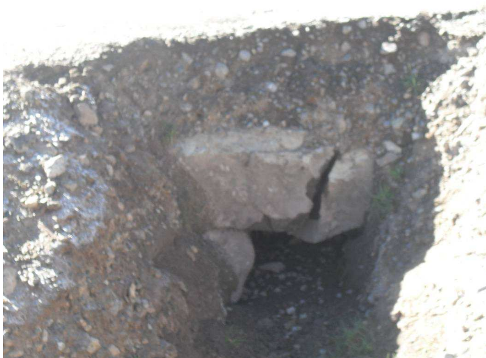
Alcantarilla artesanal Progresiva 206+500
