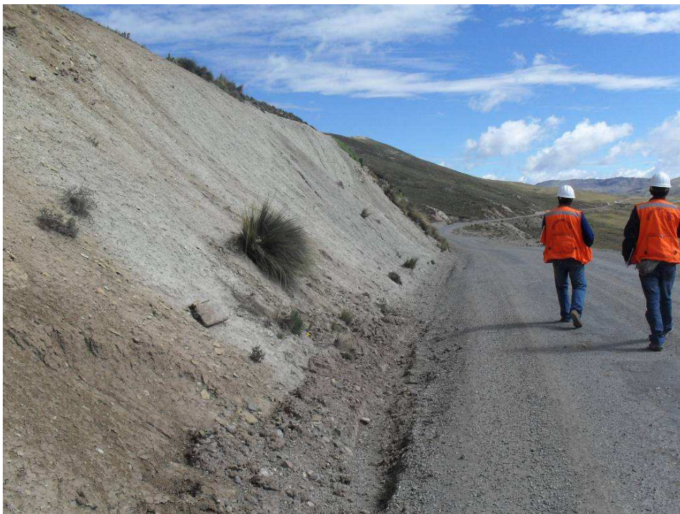
Talud de aproximadamente 4m de altura Progresiva 209+000
