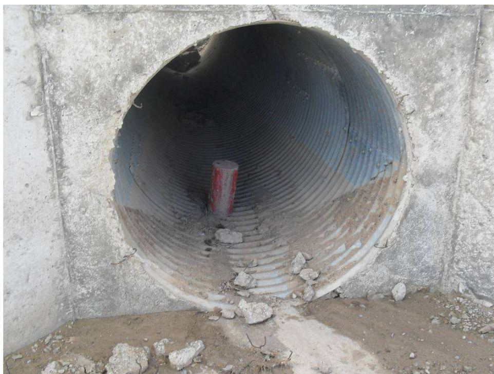
Alcantarilla de 48" de diámetro Progresiva 211+100
