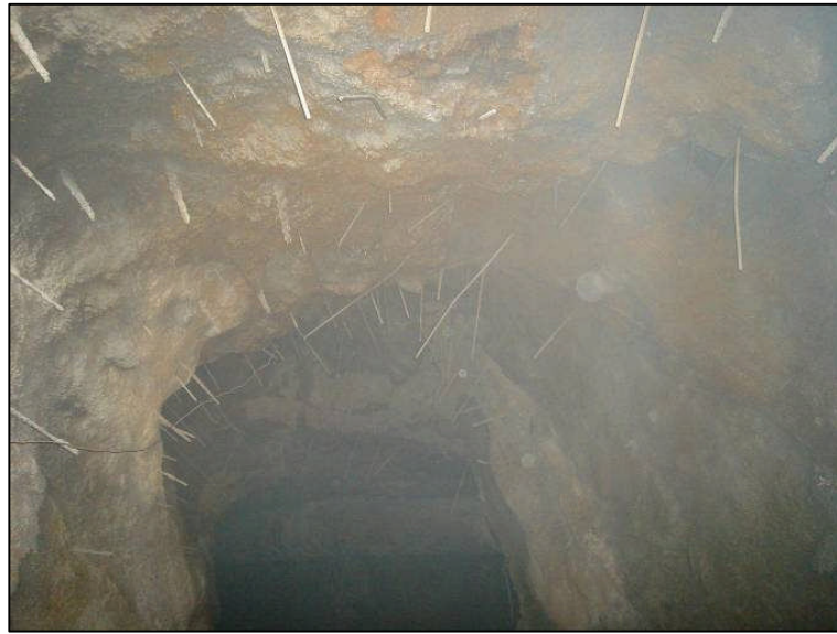
Figura 50. Labor avanzada usando fore piling
