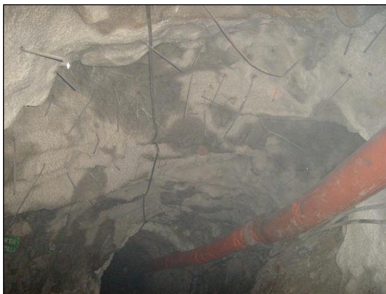
Figura 42. Labor avanzada con shotcrete
