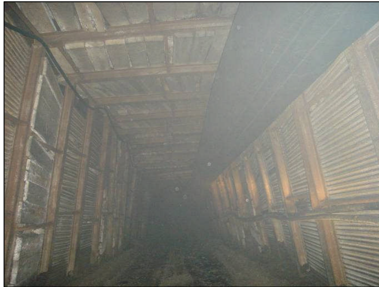
Figura 47. Labor avanzada con cuadros metálicos
