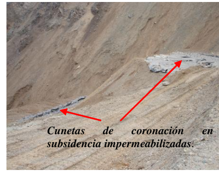
Foto 7.6: Impermeabilización en el área de subsidencia.
