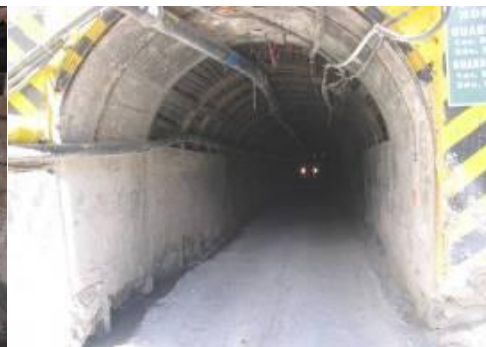
Foto 7.2: Bocamina Nv 4090 – Año 2006
