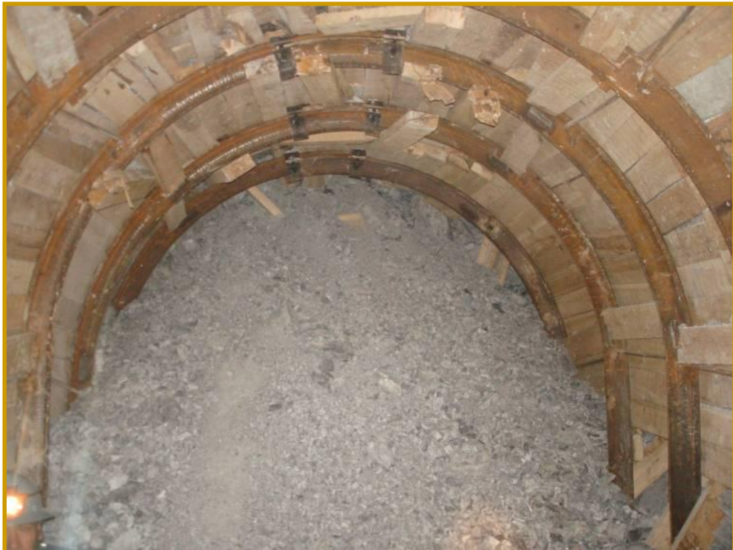
Foto 2.2: labor sostenimiento con cimbras deslizantes.
