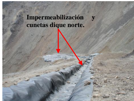
Foto 7.5: Cuneta de coronación en el área de subsidencia
