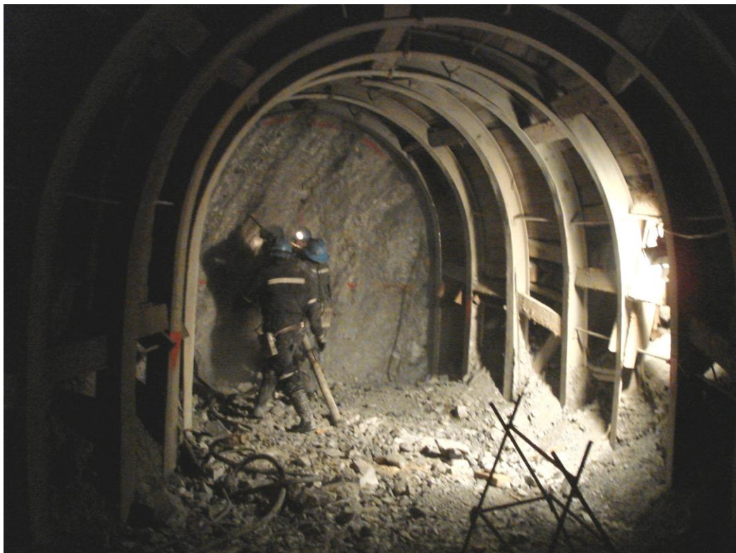
Foto 2.1: labor sostenimiento con cimbras rígidas
