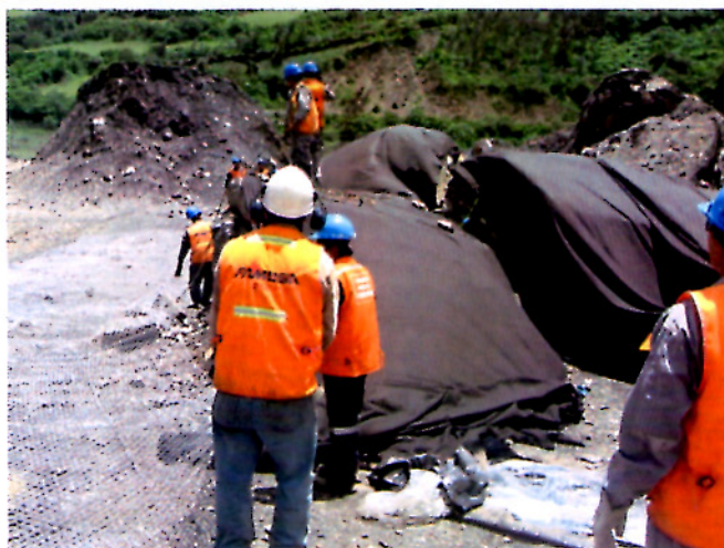
FOTO 3.2: COBERTURA CON GEOTEXTIL
