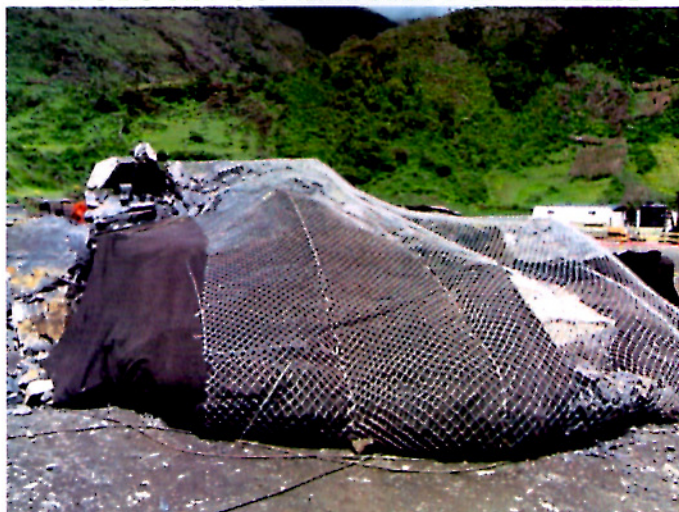
FOTO 3.3: COVERTURA CON MALLA
