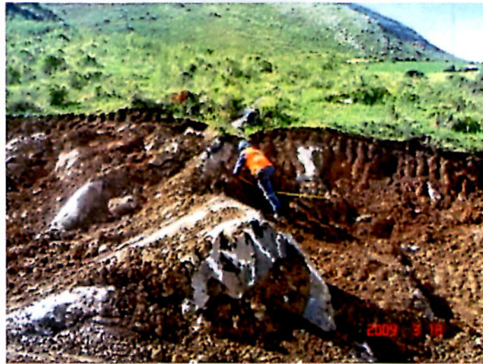
FOTO 3.1: MARCADO DE MALLA
