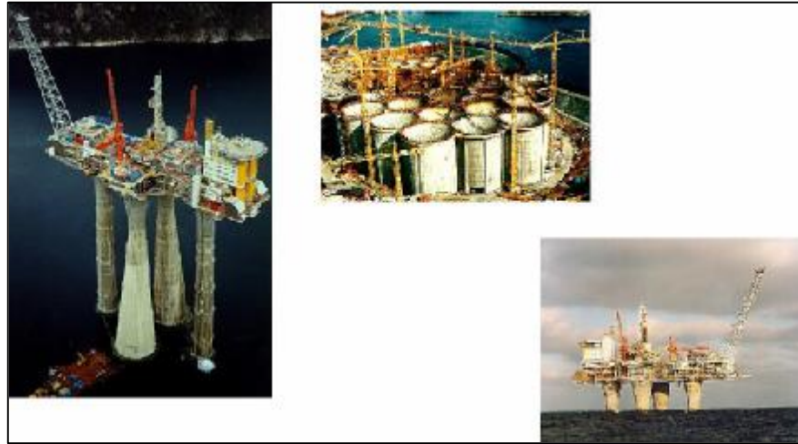
Figura 2.6 Plataforma fija por gravedad
