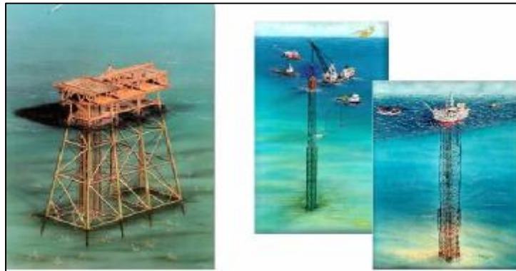
Figura 2.4 Plataformas fijas: Jacket
