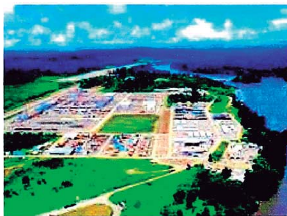
FIGURA 10.- PLANTA DE COMPRESIÓN Y SEPARACIÓN LAS MALVINAS
