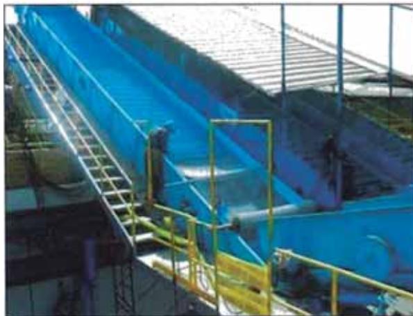
Figura 5.3 Transportador de mallas.
