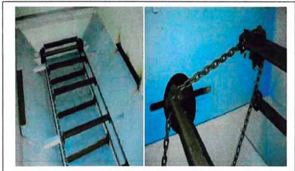
Figura 3.16: Draga Extractora de Lodos
