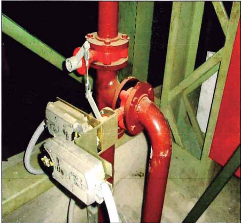
Figura 3.24: Válvula de Tres Vías
