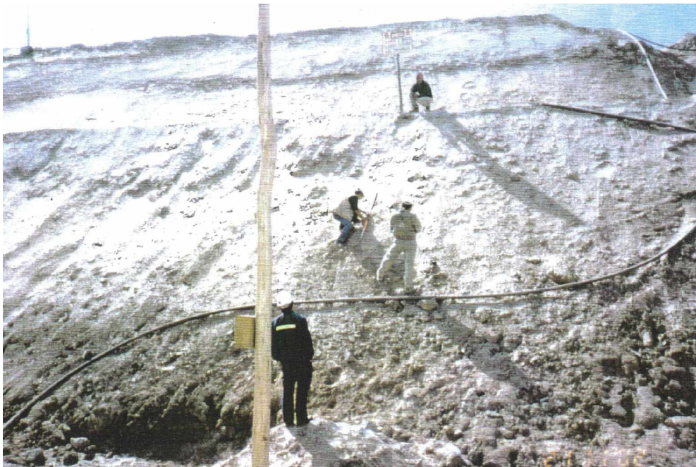
Foto 30. Midiendo el talud del relave
