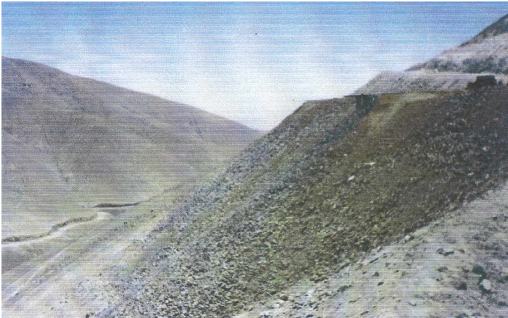
Foto 36. La pendiente del desmonte sigue a la pendiente natural del terreno
