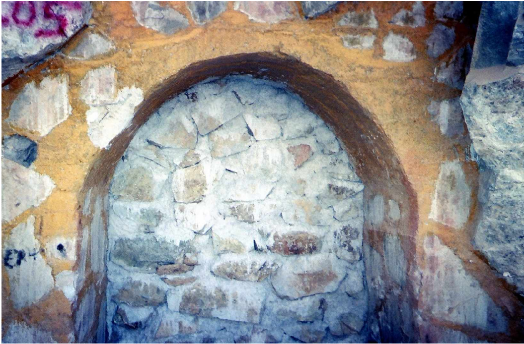
Foto 45. Taponeado de una boca mina
