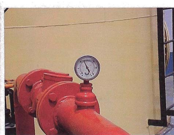
Manómetro en línea operando a 120 libras
