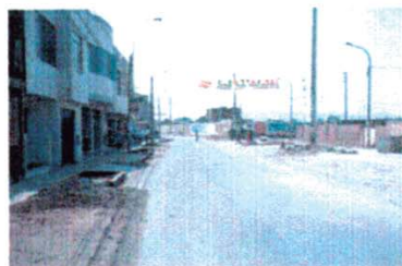
■ Viviendas en construcción y de dos niveles
