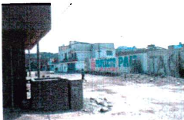
■ Vivienda en construcción
