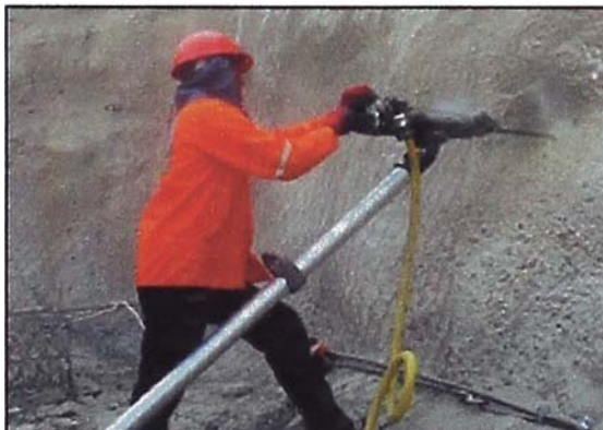
Fig 1.1 Perforación de taludes
