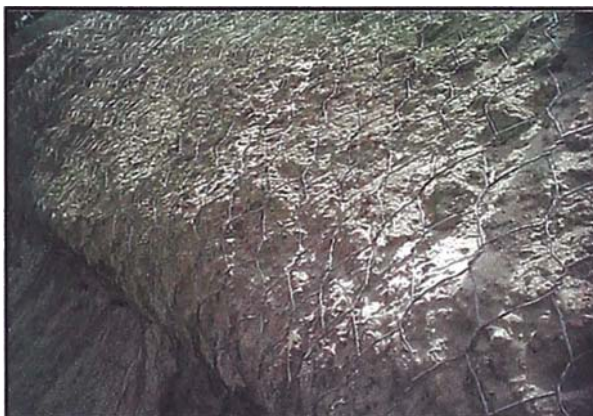
Fig 1.3 Malla para sostenimiento de taludes
