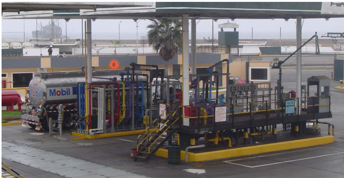
Figura 3.7: Zona de Despacho
