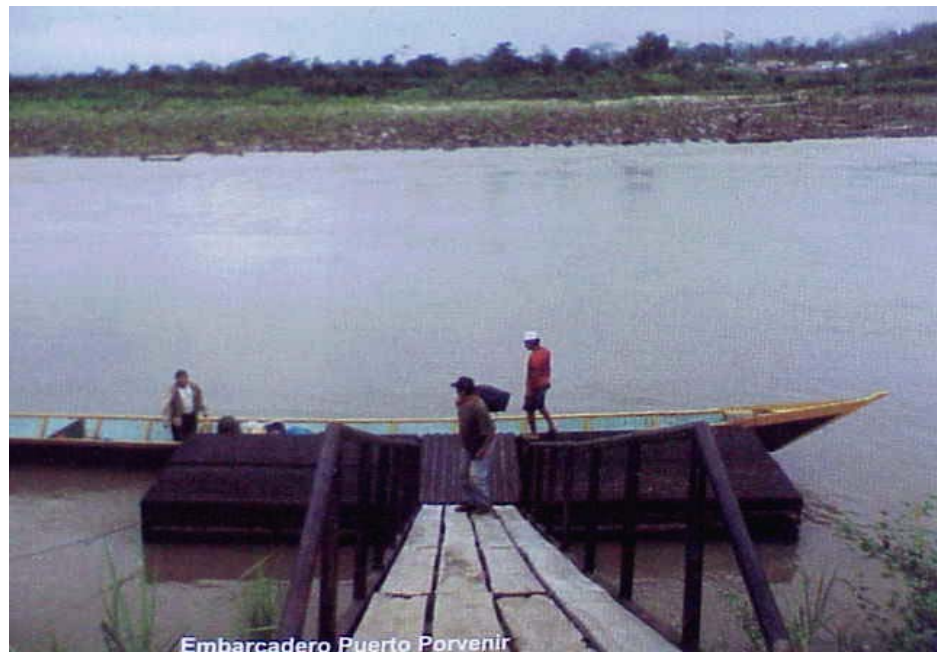
Fig. 5.5 En las fotos que anteceden, apreciamos los embarcaderos SHIMA y PORVENIR
