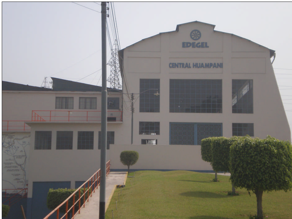
Figura N° 3.26 Casa de Máquinas de la Central Hidroeléctrica (Huampani)
