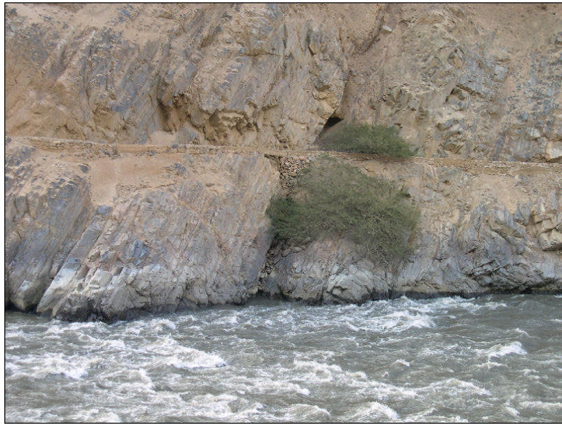
Foto 3.3: Vista de la zona por donde se construirá la Bocatoma
