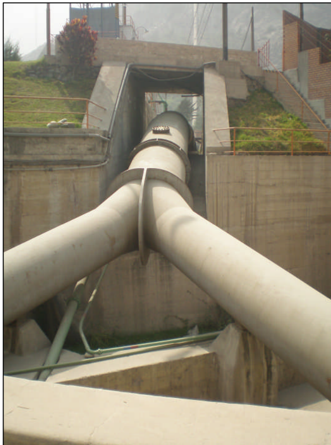
Figura N° 3.13 Bifurcación de la tubería forzada.
