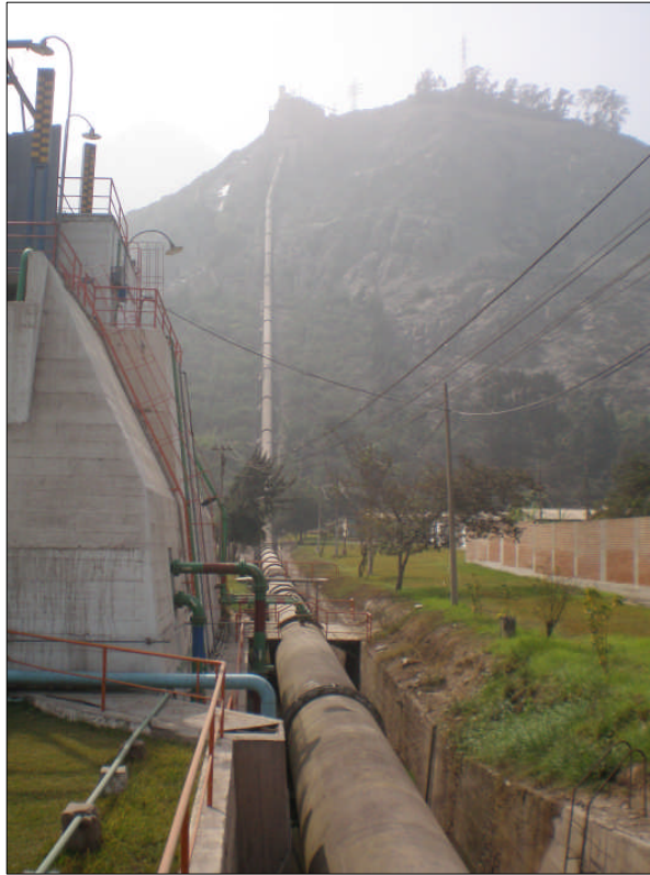
Figura N° 3.14 Tubería Forzada de la Central Hidroeléctrica Huampani
