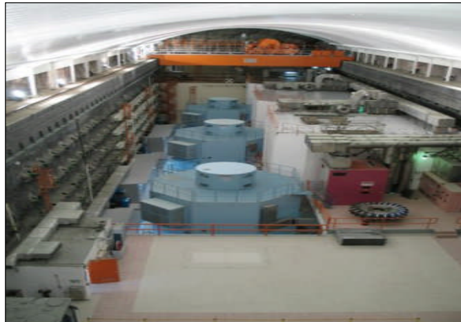
Figura 3.16 Vista de una Casa de Máquinas
