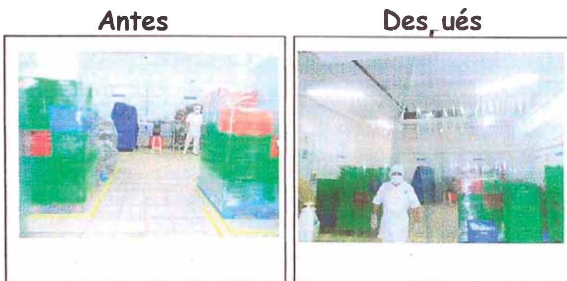
Figura 3.6 – Muestra en Antes y Después de la colocación del separador de ambiente Fuente: Elaboración propia
