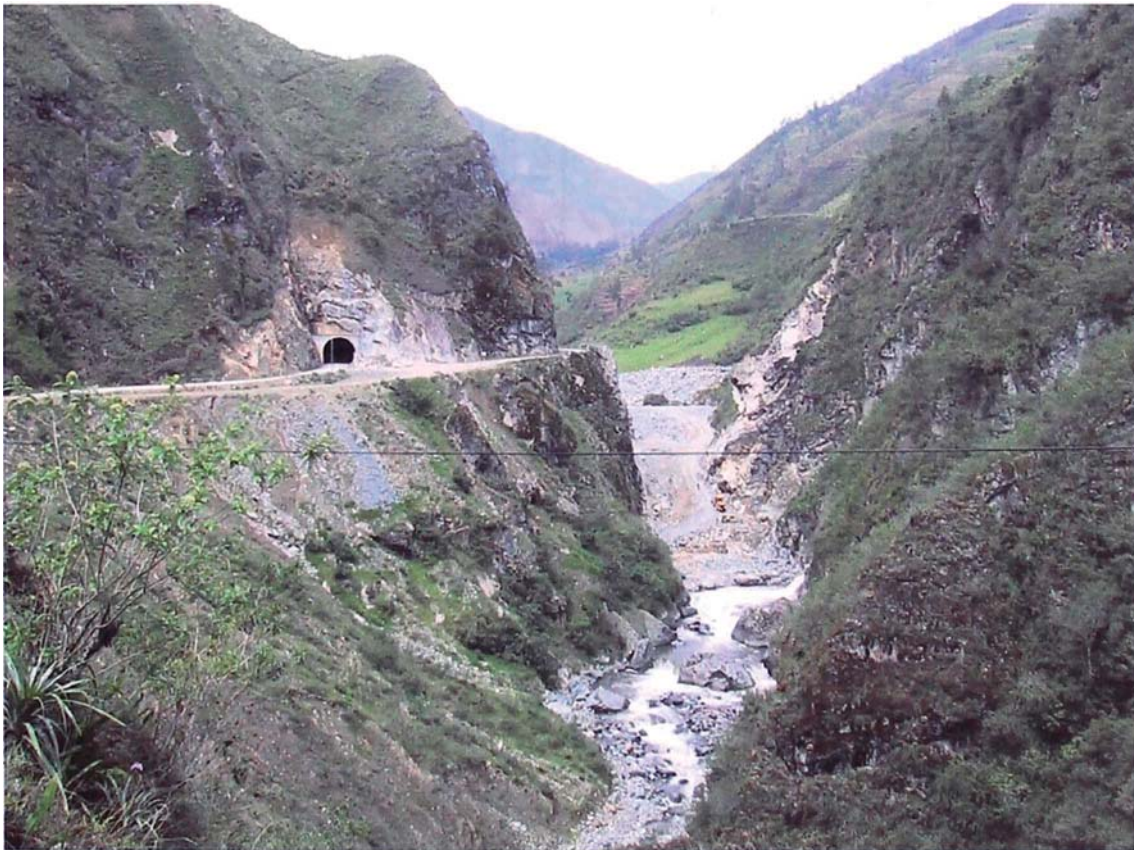
Foto No.14.- Excavación de la Presa Huallamayo
