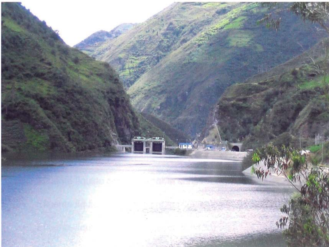
Foto No.04.-Presa – Bocatoma – Desarenador - Huallamayo
