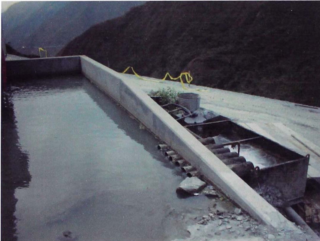
Foto No.21.- Tanque de sedimentación y tratamiento de aceites y grasas – Túnel No.1 Ventana No.02
