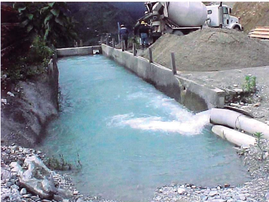
Foto No.22. – Tanque de Sedimentación – Túnel No.04 Penstock
