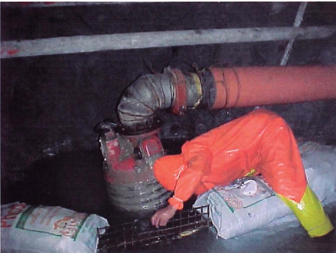
Foto No.08.- Bombeo agua subterránea - Túnel No.04 Penstock
