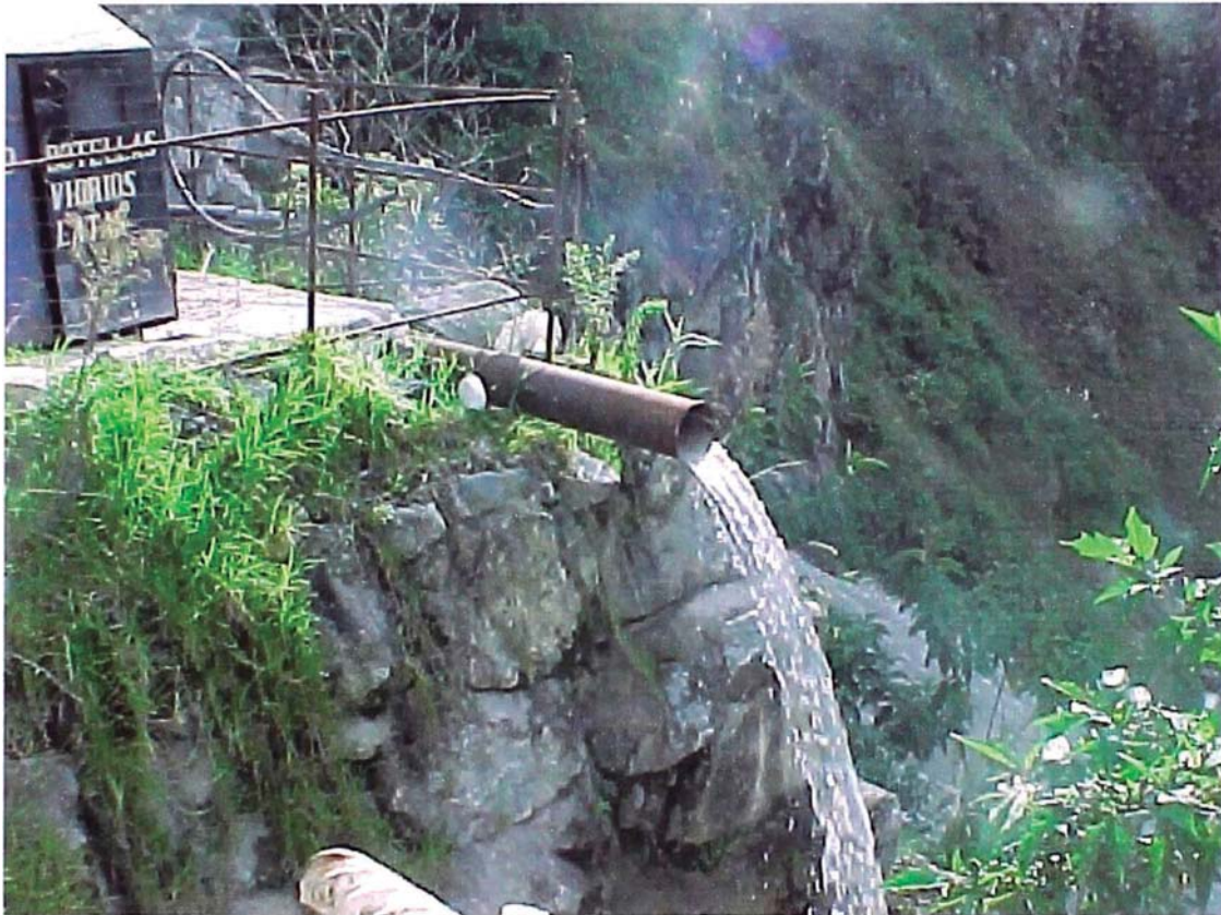
Foto No.11.- Agua Subterránea derivada al río sin tratamiento
